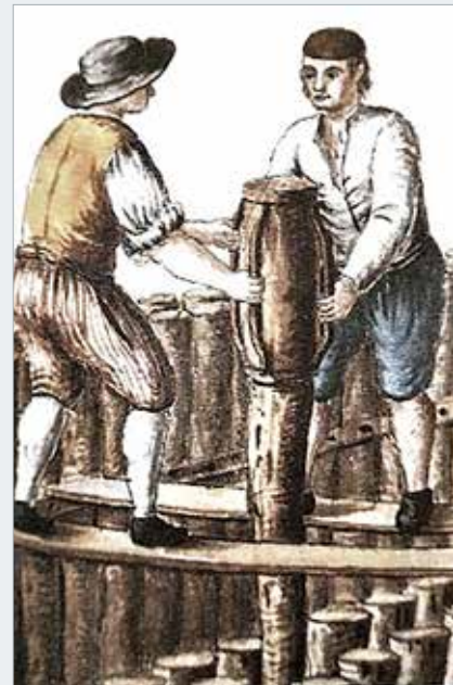
Obr. 6: Uspořádání dřevěných pilot v Benátkách – Roloff (2016)
