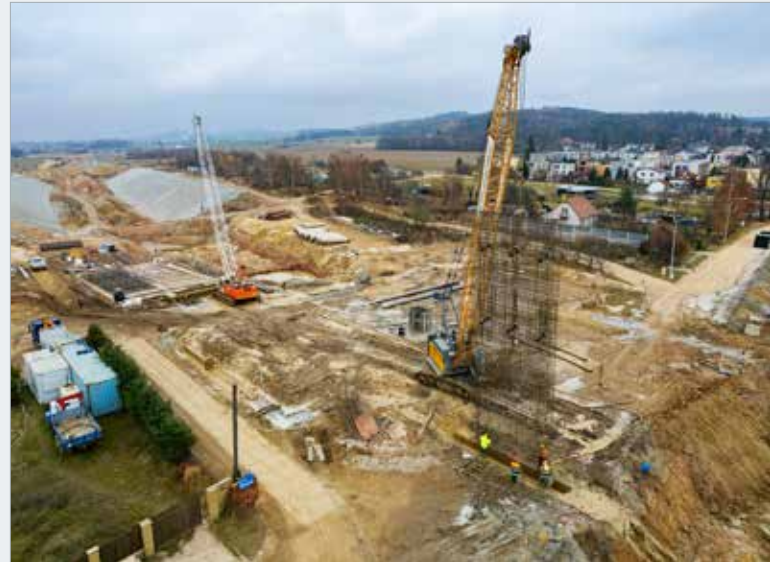
Osazování armokoše lamely podzemní stěny na Pražském portále
