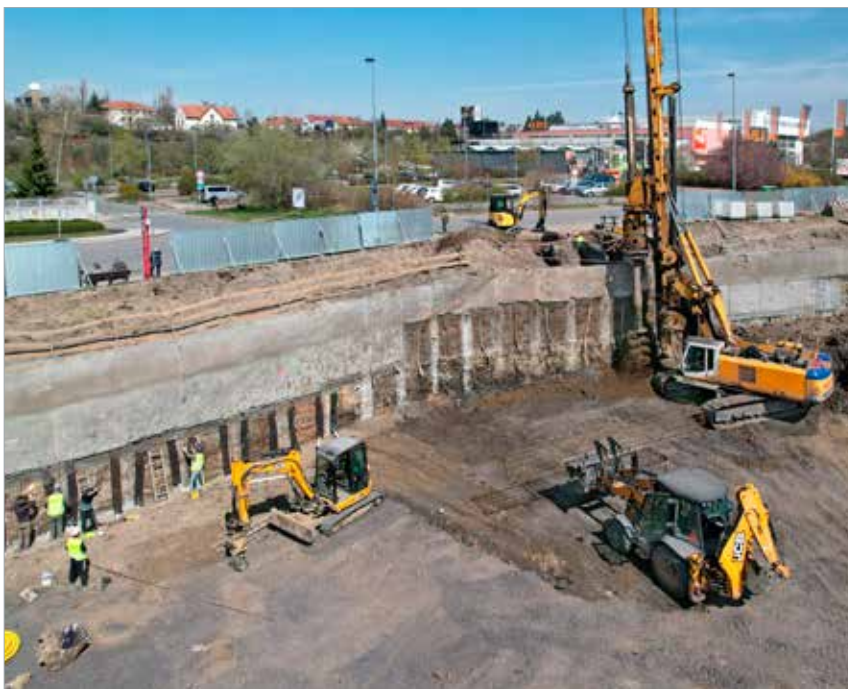
Realizace základových pilot a instalace drénu na pilotové stěně
