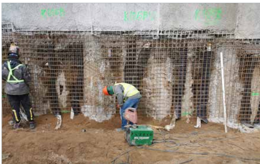
Pilotová stěna s dotěsněním mezilehlého prostoru sloupy tryskové injektáže, příprava Kari sítě před aplikací stříkaného betonu
