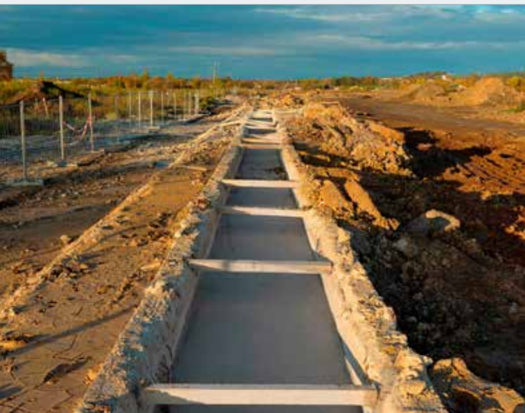
Dokončená koruna těsnící podzemní stěny
