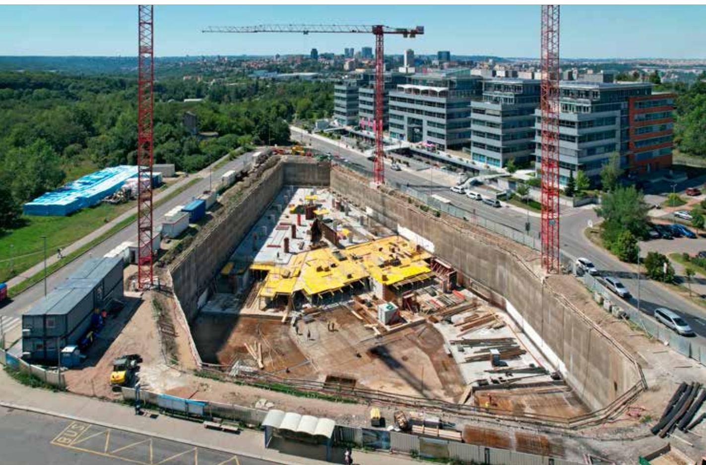
Výstavba prvních podzemních podlaží v zapažené stavební jámě
