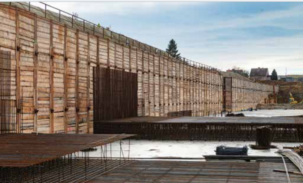
Armování základové desky tunelu v úseku zajištěném kotveným záporovým pažením
