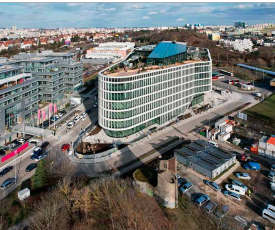
Budova Roztyly Plaza před dokončením hlavních stavebních prací (2/2024)
