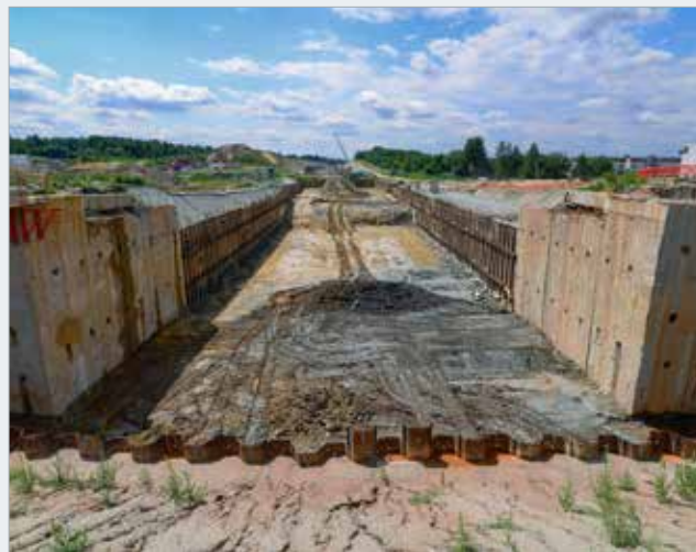
Pohled na úsek výstavby v napojení Pražského portálu na tunel
