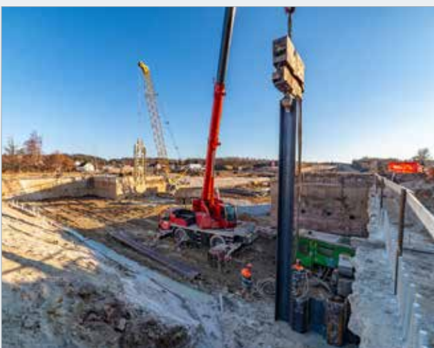
Beranění štětovnic příčné stěny pro oddělení 1. etapy výstavby Pražského portálu
