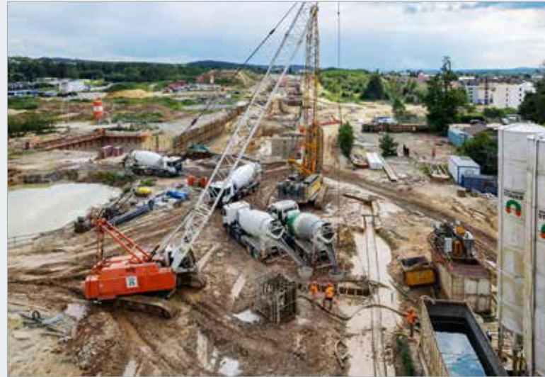
Obtížné podmínky při betonáži lamely podzemní stěny Pražského portálu
