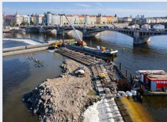
II. etapa rekonstrukce jezu u vorové propusti
