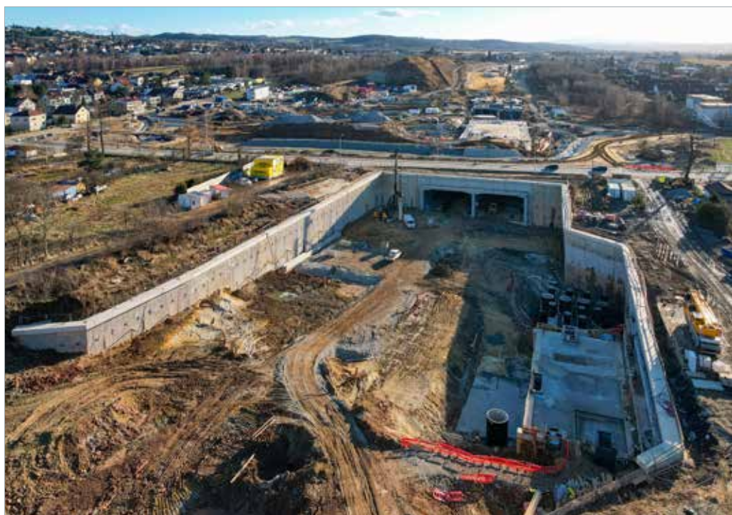
Pažení stavební jámy Pražského portálu kotvenými podzemními stěnami
