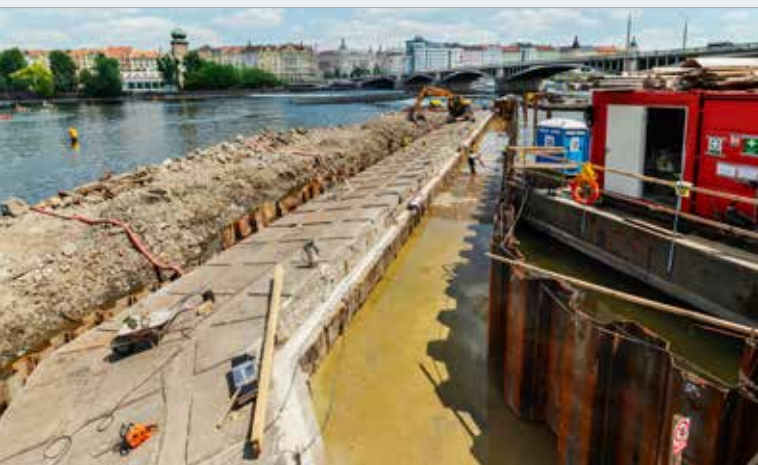
Výstavba nového žlb. prahu mezi štětovou stěnou a korunou jezu, I. etapa
