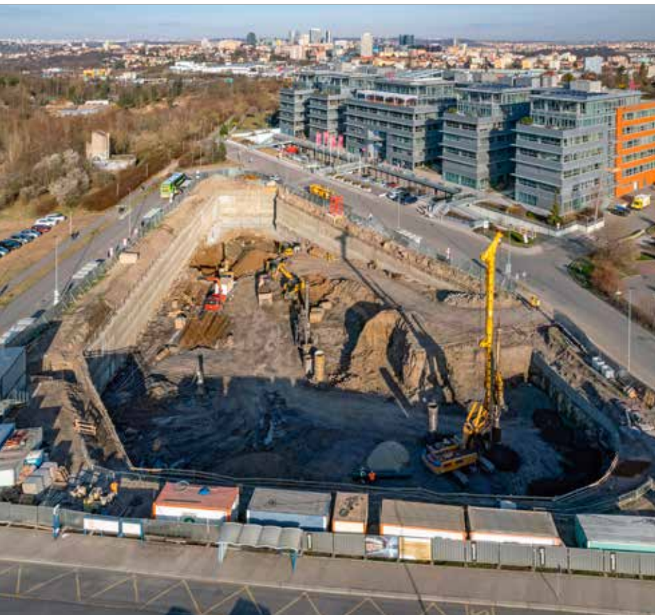
Závěrečná etapa prací na zajištění stavební jámy a založení objektu
