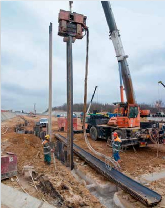
Osazování štětovnic VL 603 do rýhy těsnicí podzemní stěny vyplněné jílocementostruskovou směsí
