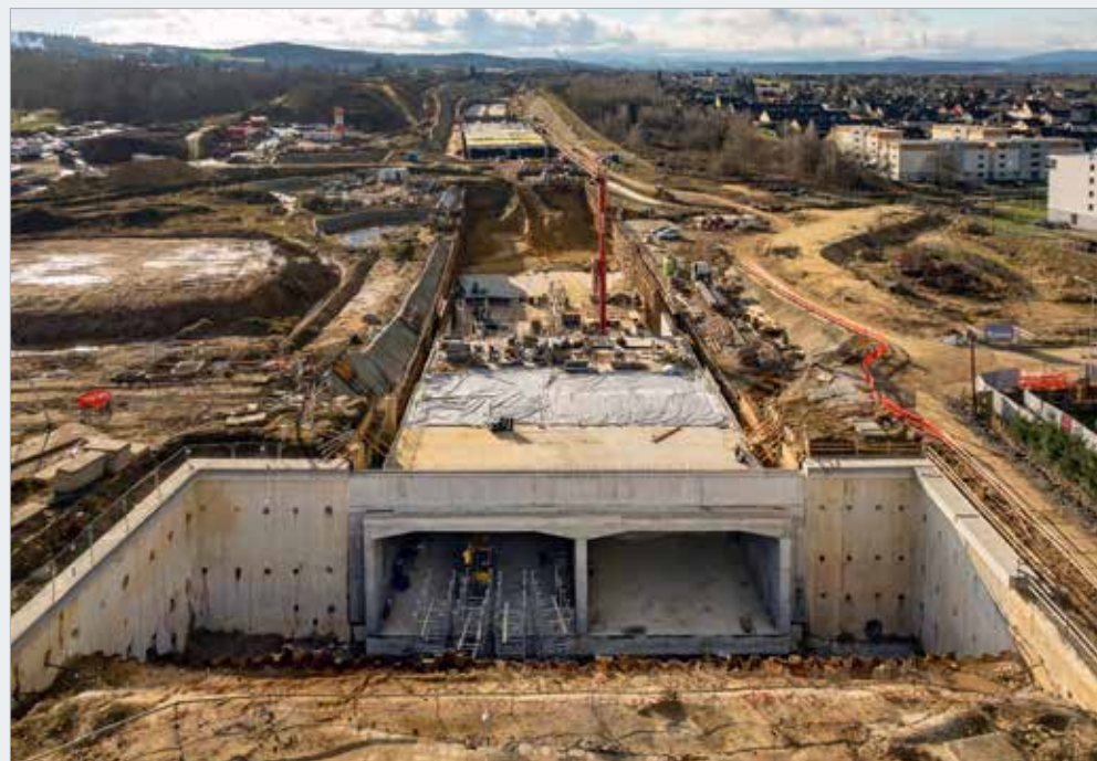
Výstavba železobetonové konstrukce tunelu za částečně dokončeným Pražským portálem
