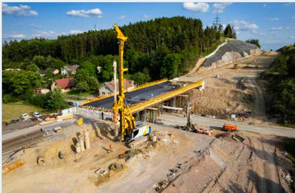
Pro nový dálniční most u Milína na dálnici D4 (přes silnici III/1181-8) byla použita netypicky kombinace pilotového a mikropilotového zakládání.
