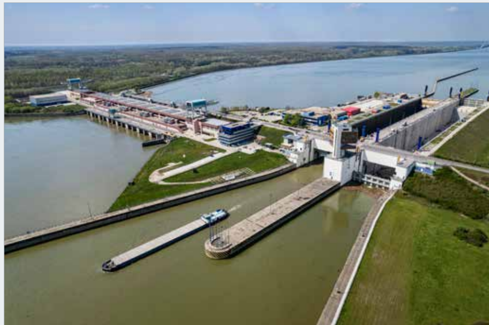
Vodní dílo Gabčíkovo s plavebními komorami a elektrárnou
