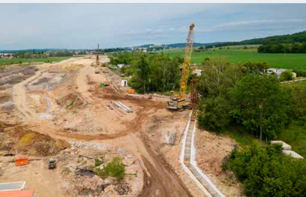
Hloubení rýhy pro štěrkový drén navazujícího na Pražský portál
