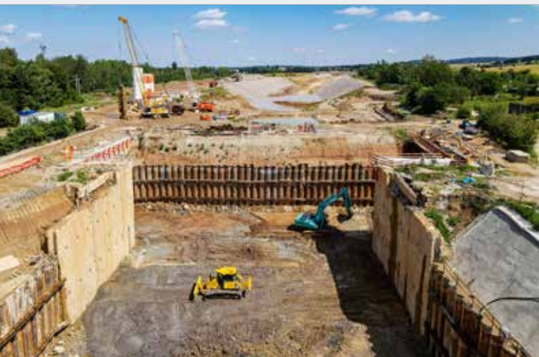
Definitivní výkop v úseku napojení Pražského portálu na tunel
