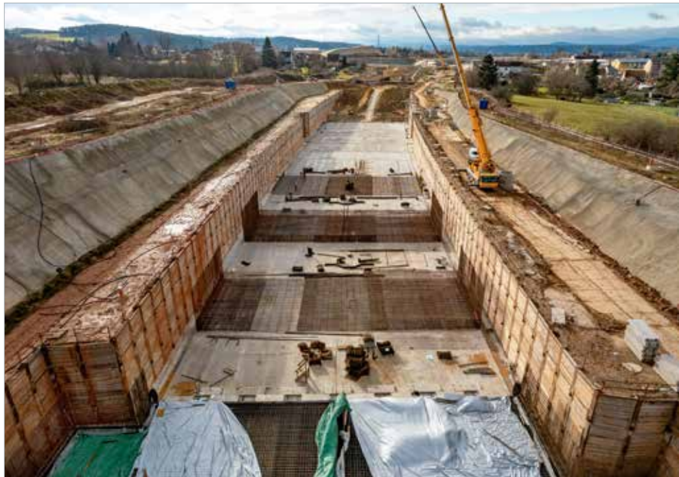
Armování základové desky a stěn tunelu ve stavební jámě pažené kotveným záporovým pažením, staveniště střed
