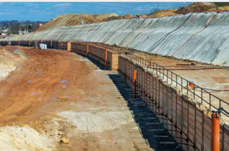
Stavební jáma pažená kotveným záporovým pažením, výkop na 1. KÚ
