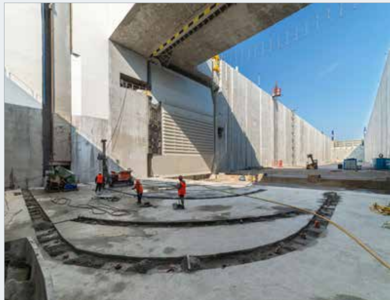
Sanace poruch vypouštěcího systému levé plavební komory
