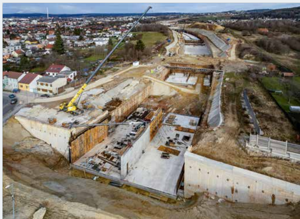
Dokončený Kaplický portál s probíhající výstavbou železobetonové konstrukce tunelu
