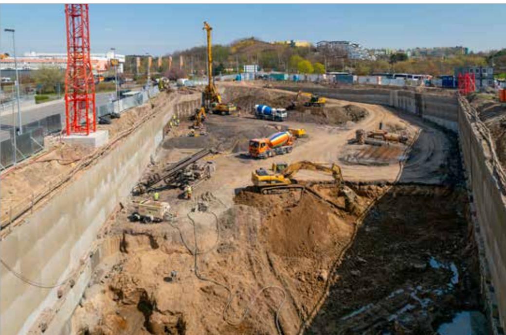
Intenzivní práce ve stavební jámě
