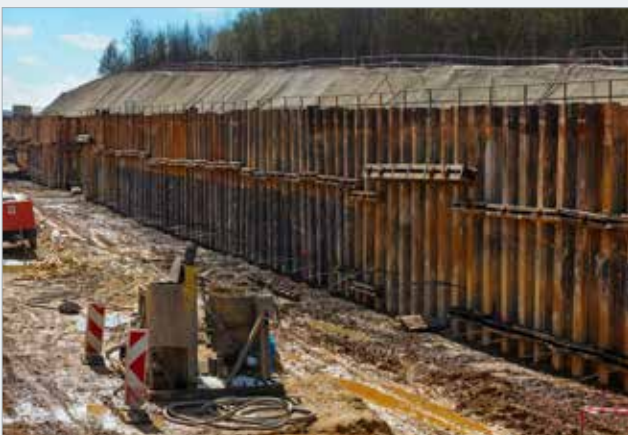
Pohled na kotvenou štětovou stěnu
