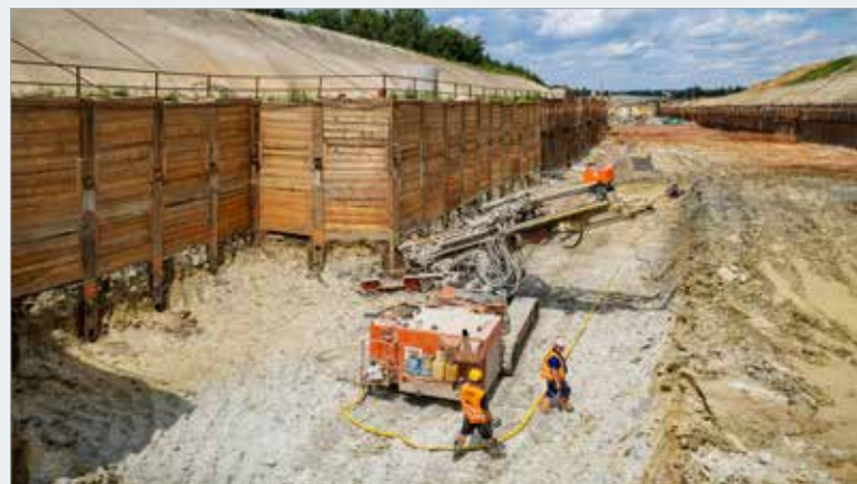
Hloubení kotev 2. úrovně na úseku tunelu zajišťovaném záporovým pažením
