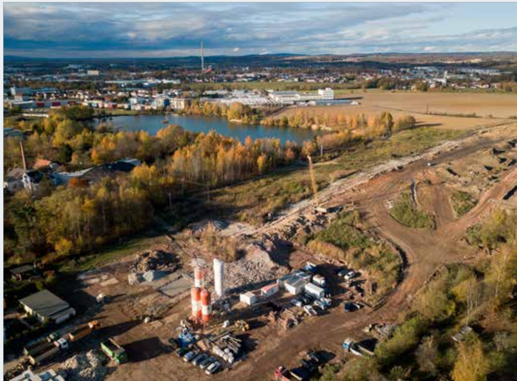
Těžba rýhy těsnící podzemní stěny navazující na Pražský portál
