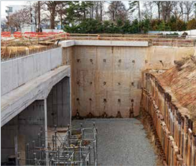
Ofrézovaná část podzemní stěny na Pražském portálu
