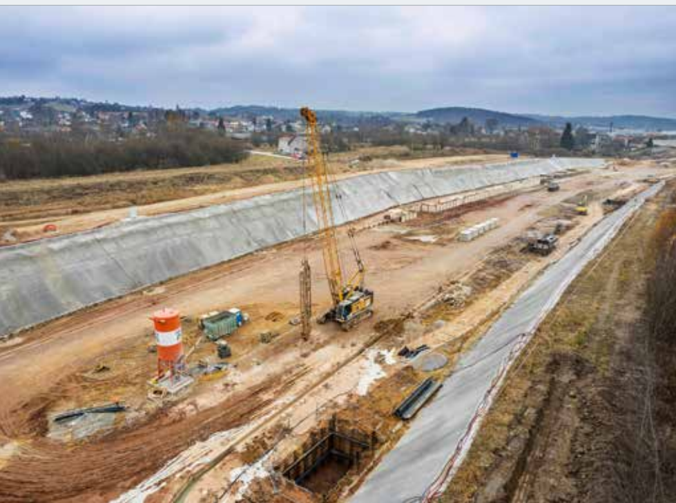
Těžba rýhy těsnící podzemní stěny vyplněné jílocementostruskovou směsí pro následné osazení štetovnic
