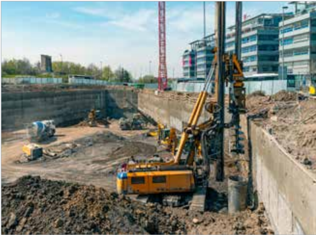
Současné provádění základových pilot a kotev
