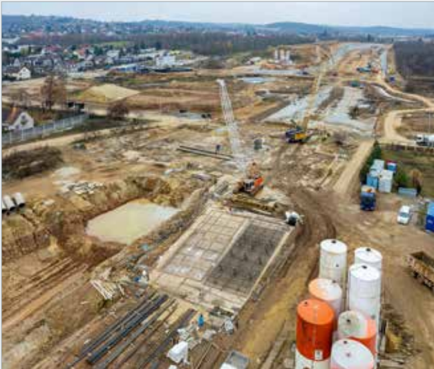
Realizace podzemních stěn na Pražském portále – výroba suspenze, montáž armokošů, těžba
