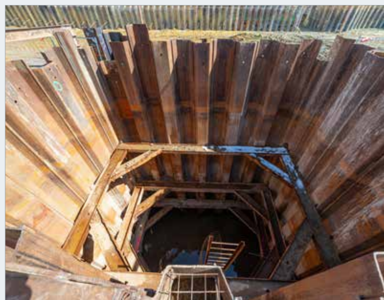
Šachta objektu SO 310 – Odvodnění tunelu, pažená štetovými stěnami a dotěšňovaná technologií tryskové injektáže
