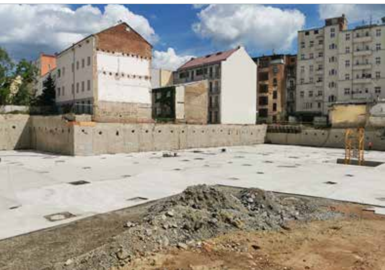
Zapažená stavební jáma s dokončeným pilotovým založením
