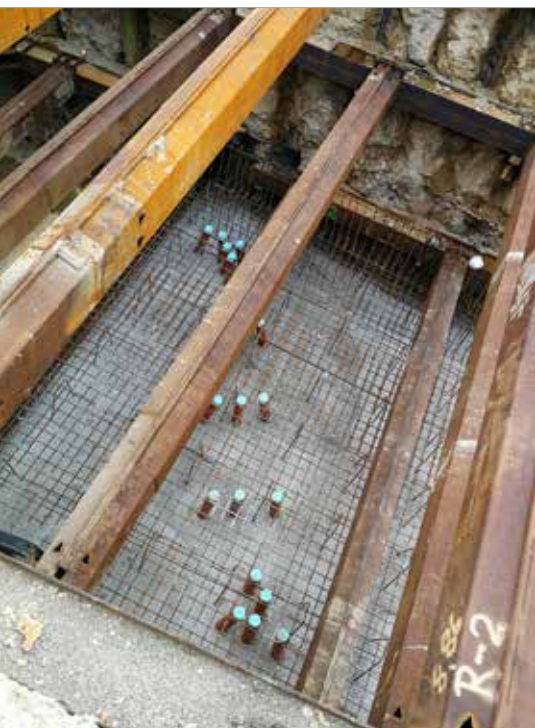
Osazené průchodky přes žlb. desku skluzu – příprava pro horninovou injektáž
