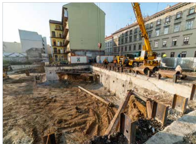
Částečně odtěžená kotvená podzemní stěna podél ulice Bratislavské
