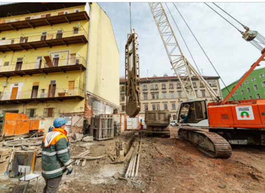
Provádění podzemní stěny u objektu v ulici Bratislavská
