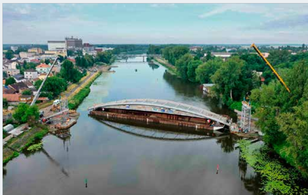
Otáčení transportní lodi v profilu lávky
