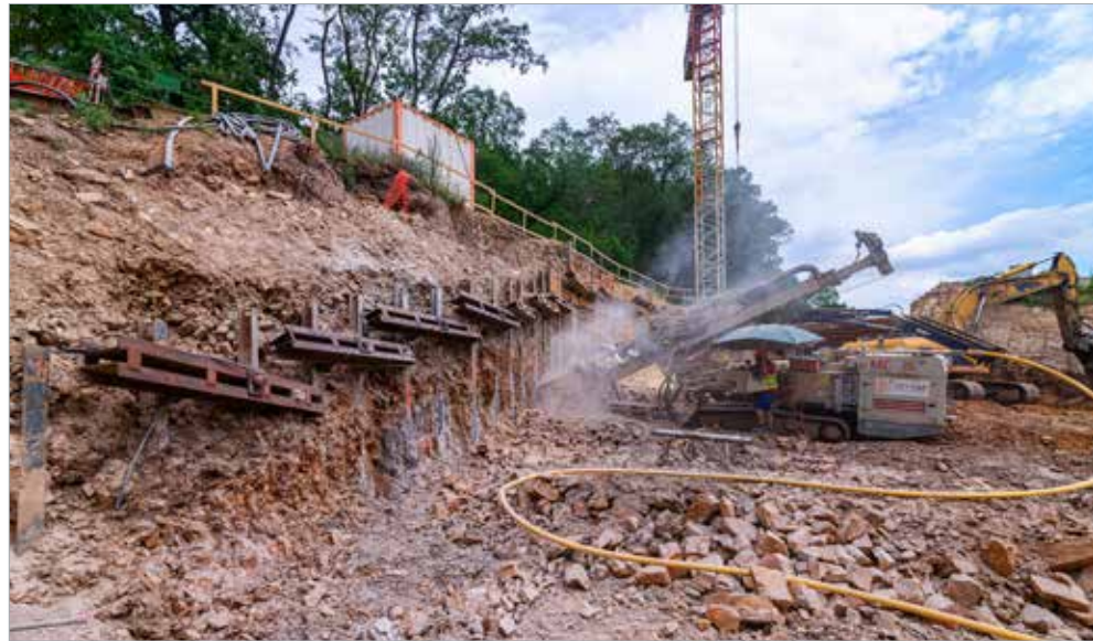
Hloubení vrtů pro kotvy v místě skluzu
