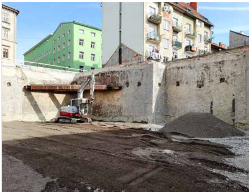
Frézování povrchu podzemních stěn
