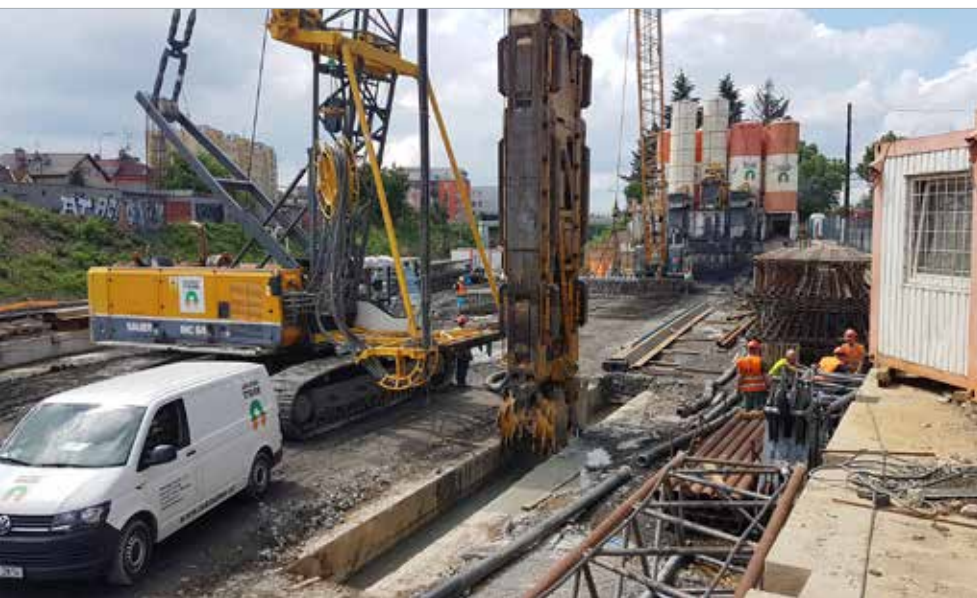
Těžba severní stěny tl. 1200 mm hydrofrézou
