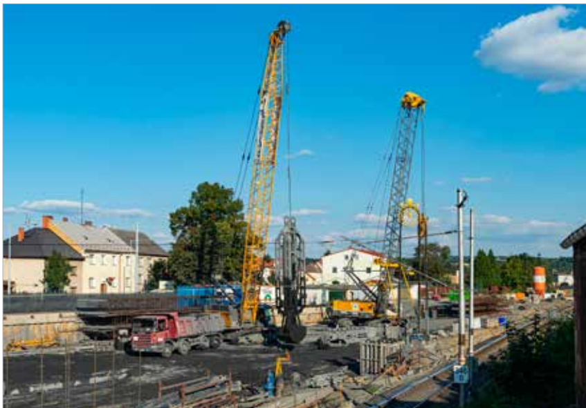
Souběžná práce drapáku a hydrofréz
