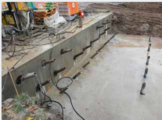
Hotový hlubinný základ pilíře P3
