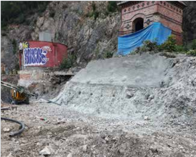
Zajištění svahu pod objektem C705 – Kaple, pomocí stříkaného betonu, KARI sítí a ocelových hřebíků
