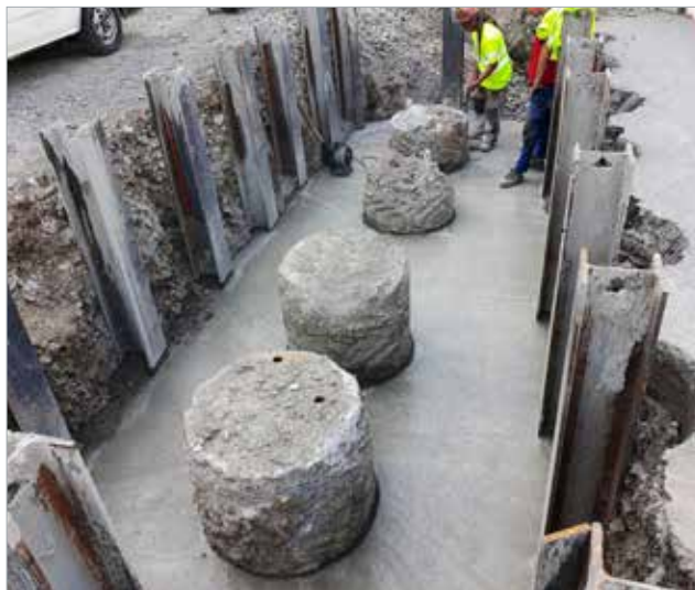
Pilotové založené podpěry P3 objektu C202 – Lávka přes VM0 pod ochranou záporového pažení
