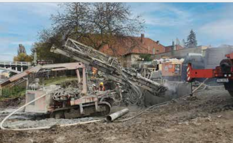
Realizace systémových MP na pilíři P3
