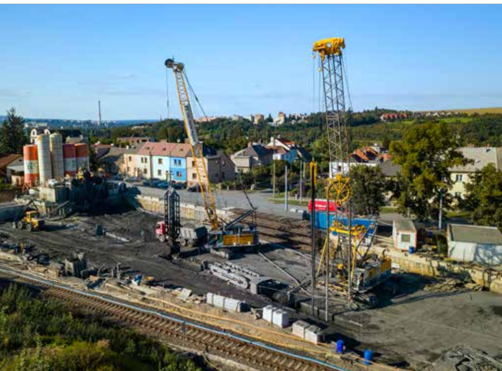
Hloubení středové linie podzemních stěn tl. 1500 mm drapákem a hydrofrézou
