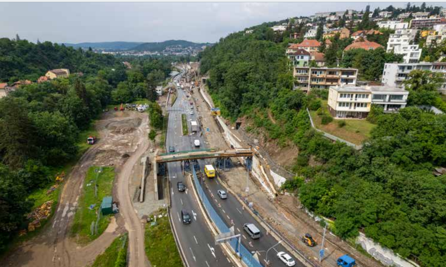
Pohled na staveniště od jihu (od Pisárek)
