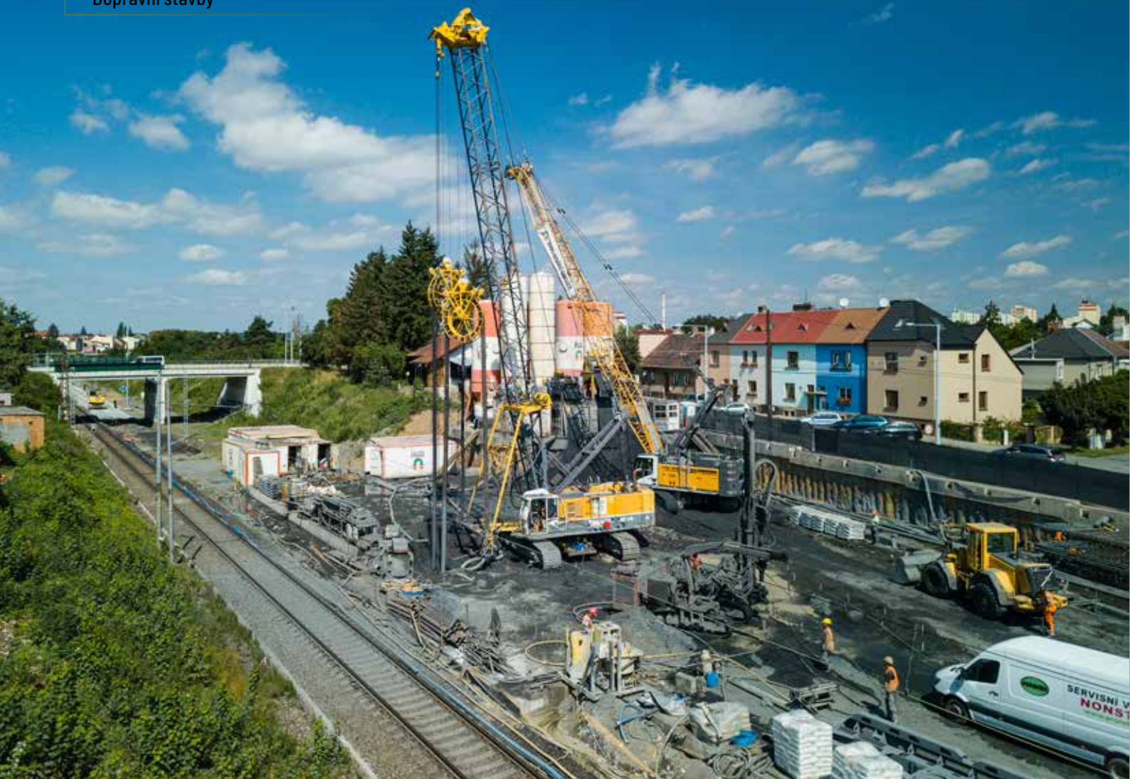
Provádění podzemních stěn v zapážené stavební jámě, první fáze výstavby
