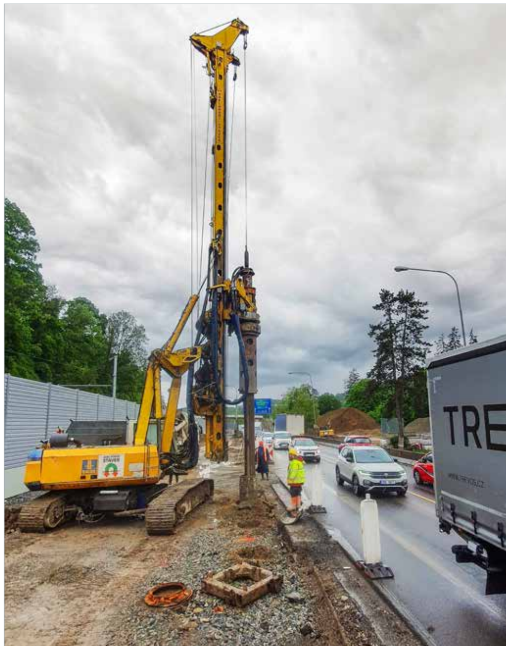
Pilotové založení objektu C762 Protihlukové stěny
