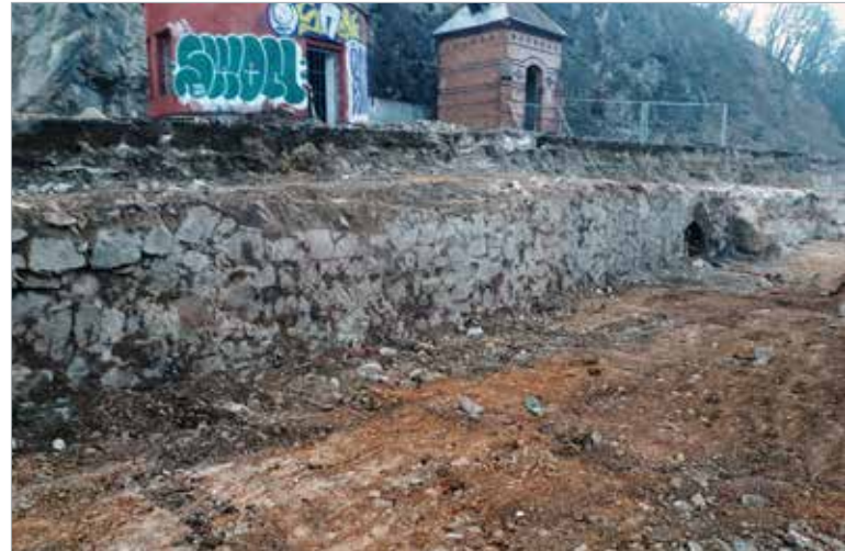
Pozůstatek historické skladovací budovy mlýna ze 16. stol. v místě dnes budovaného rozšíření silnice I/42
