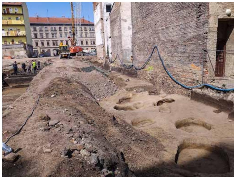
Archeologický průzkum před zahájením hlavních prací speciálního zakládání
