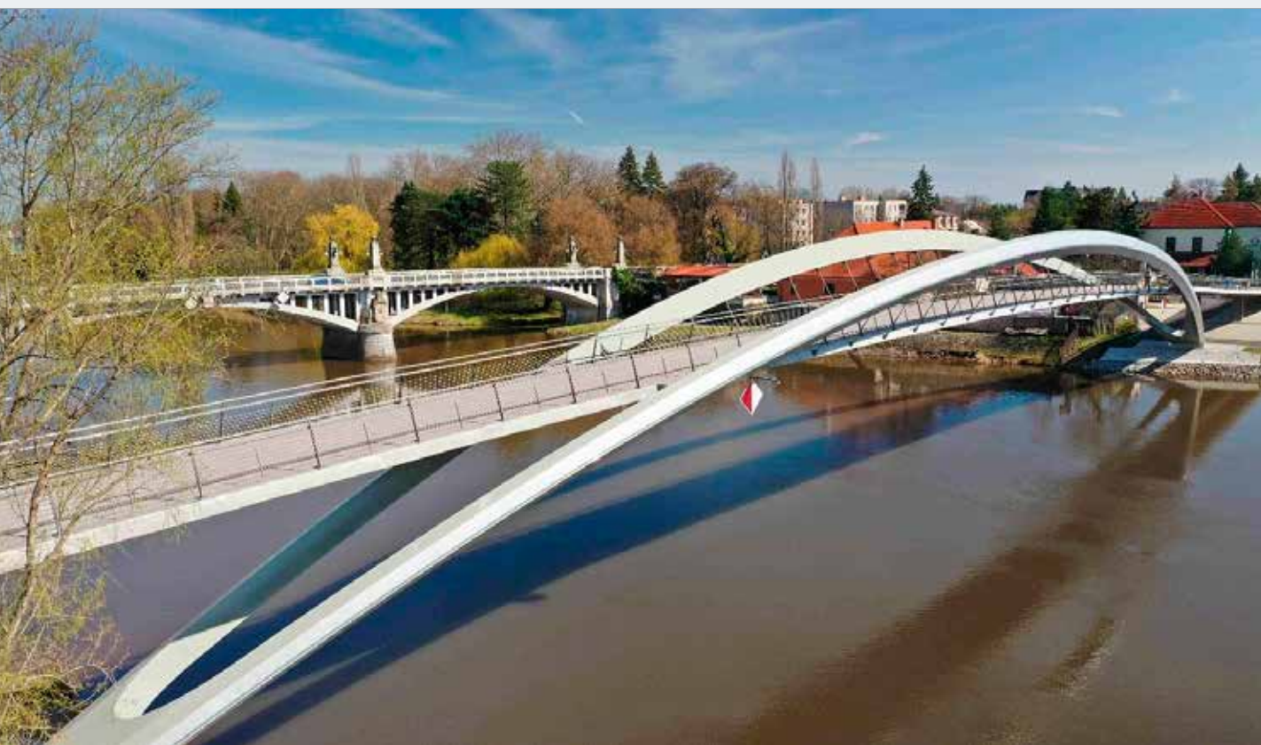
Pohled na hotovou lávku proti proudu Labe
