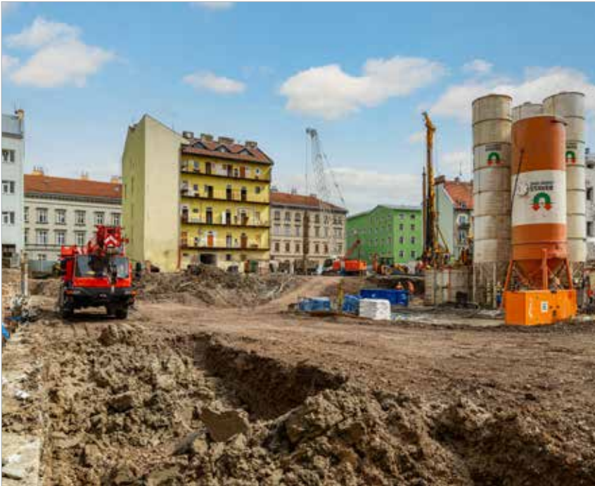
Staveniště v době zahájení prací speciálního zakládání
