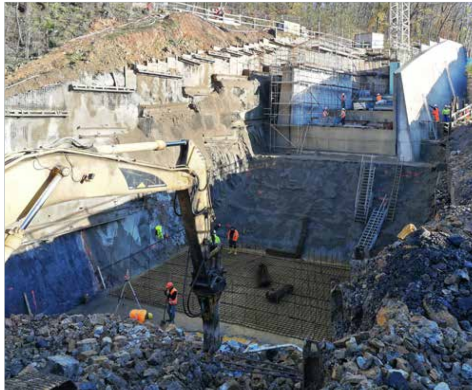
Probíhající práce na konstrukci vývaru
