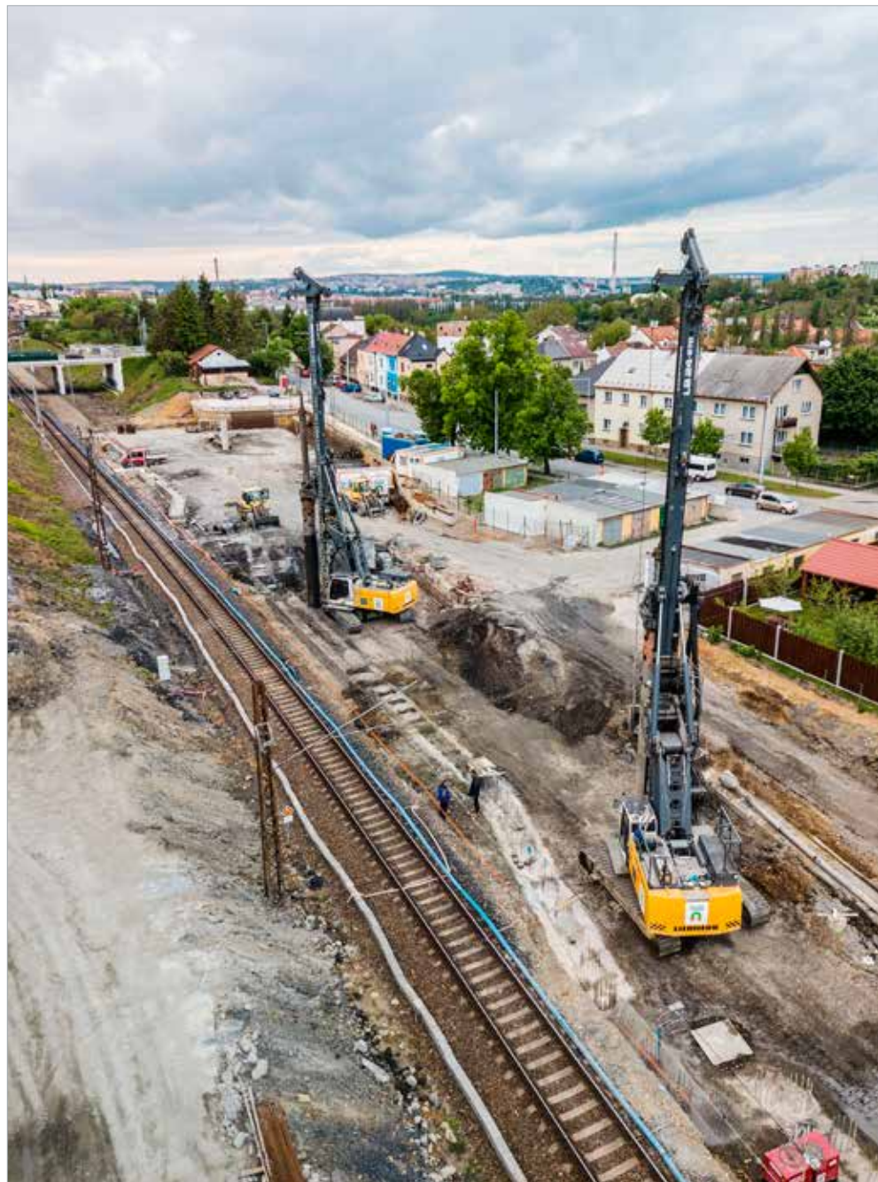
Realizace pažení stavební jámy formou převrtávané pilotové stěny podél provozované koleje
