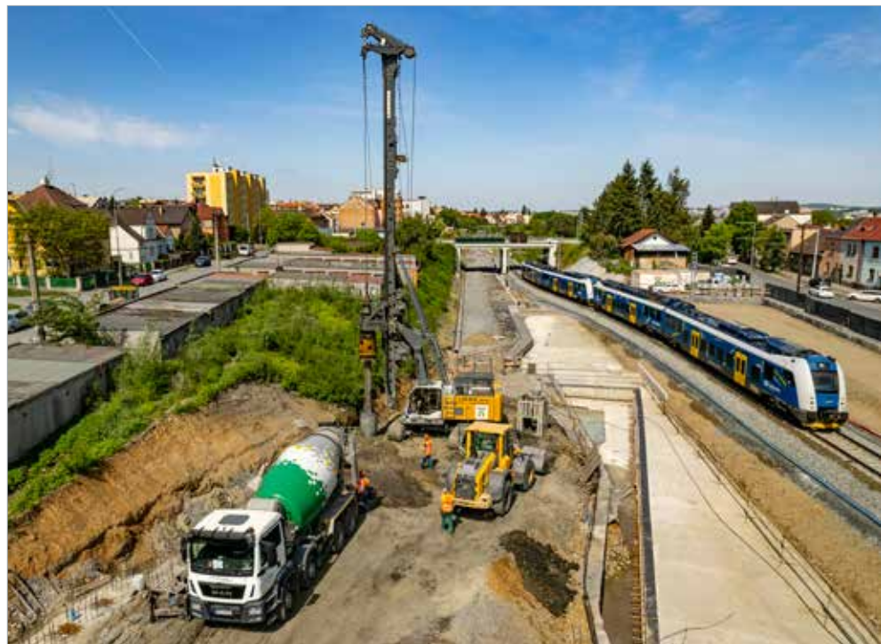
Provádění pažící stěny druhé fáze výstavby
