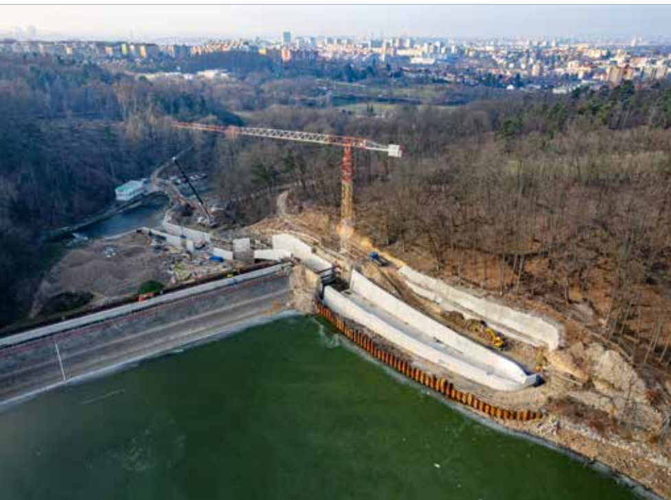
Pokročilá fáze výstavby monolitických konstrukcí bezpečnostního přelivu do zajištěné stavební jámy
