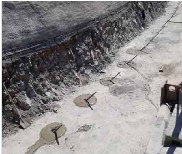
Sklolaminátové kotvení tyče pro kotvení základových bloků objektu C252 Zárubní zed' - tramvaj
