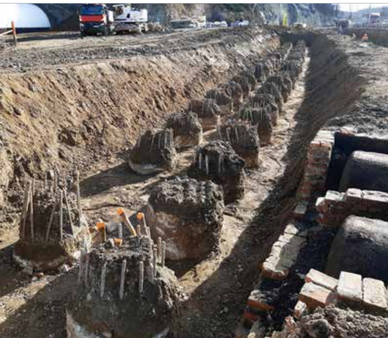
Pilotové založení objektu C621 Galerie
