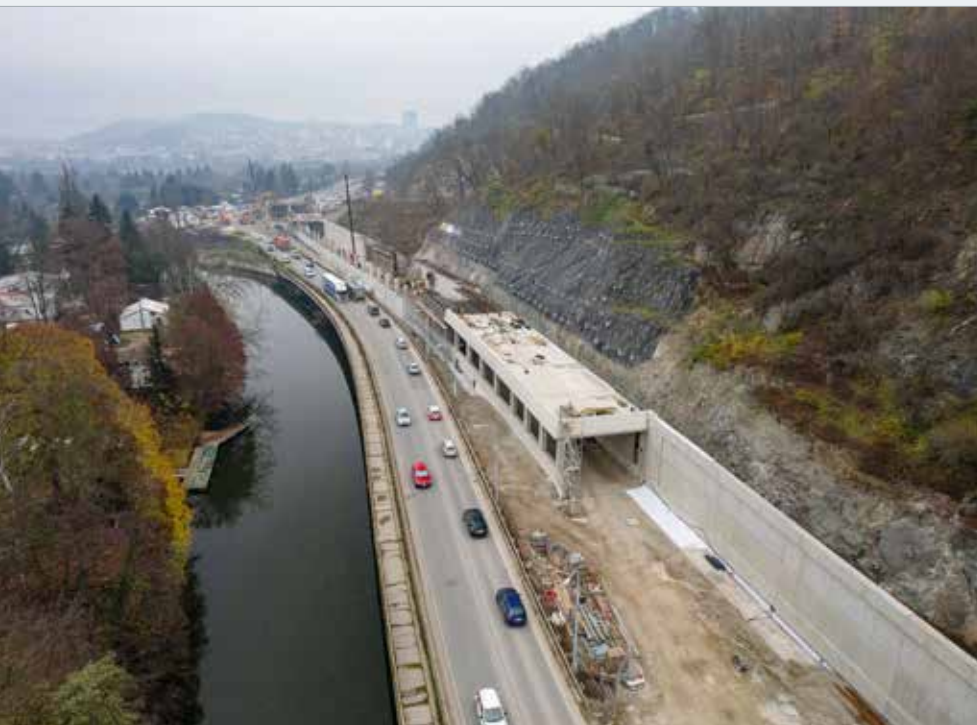
Zárubní zeď, silniční galerie a nově kotvený odřez svahu Wilsonova lesa, pohled k severu
