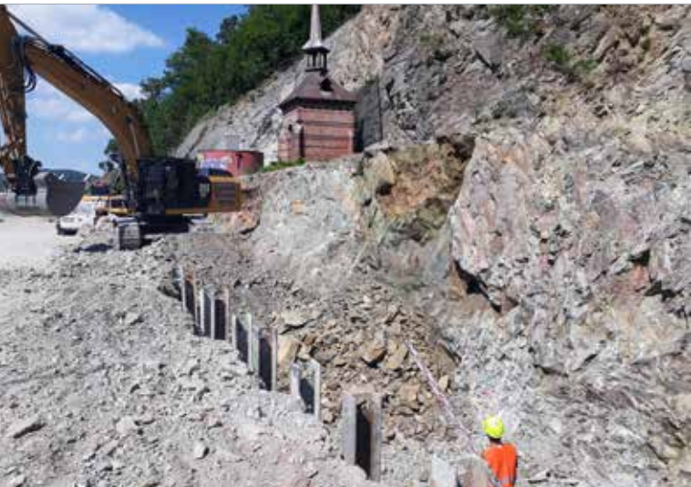
Provádění výkopu pro založení objektu C252 Zárubní zed' - tramvaj, pod ochranou záporového pažení
