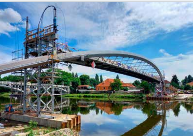
Napojení středního dílu lávky na připravené zárodky
