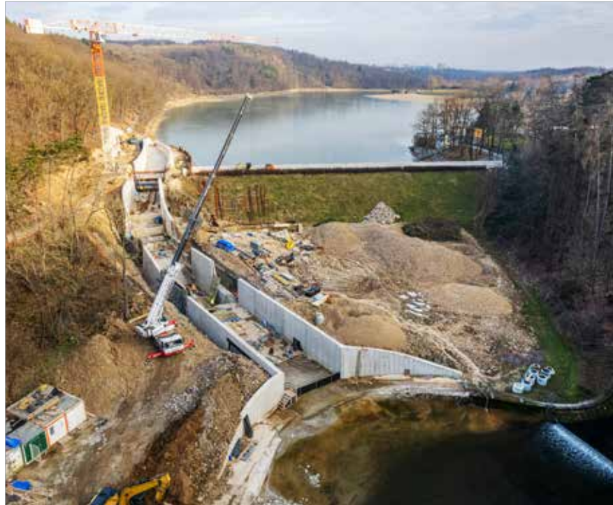
Výstavba monolitických konstrukcí bezpečnostního přelivu
