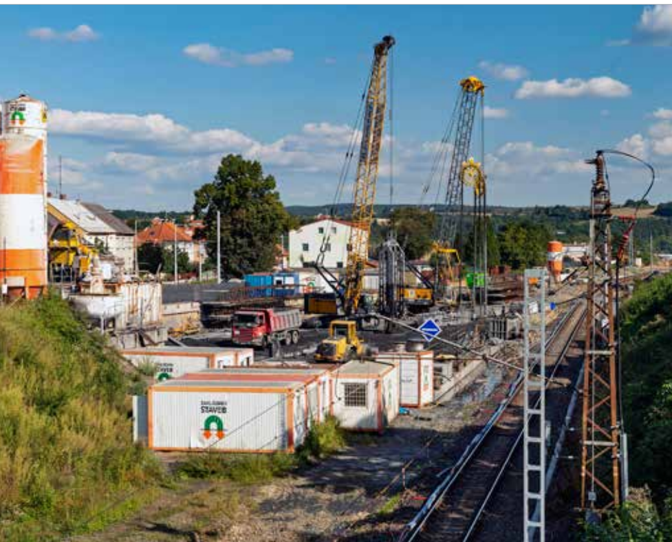
Pohled na staveniště z mostu ulice Sušická přes železniční trať
