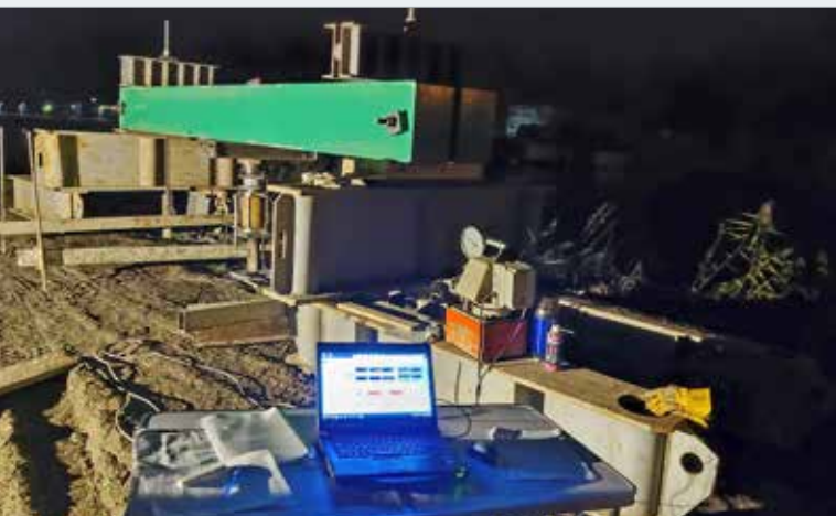
Provádění statické zatěžovací zkoušky mikropiloty v nočních hodinách
