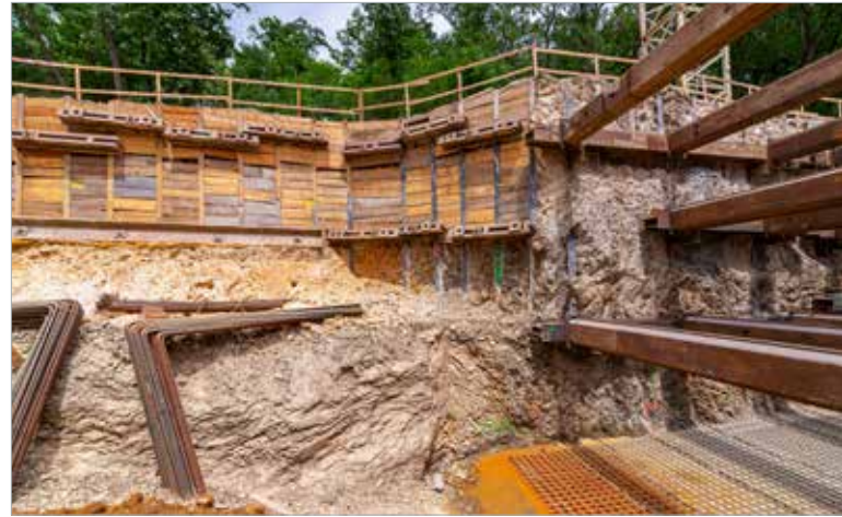
Pažení a rozepření stavební jámy v místě překopu hráze (vpravo) a navazující kotvené mikrozáporové pažení
