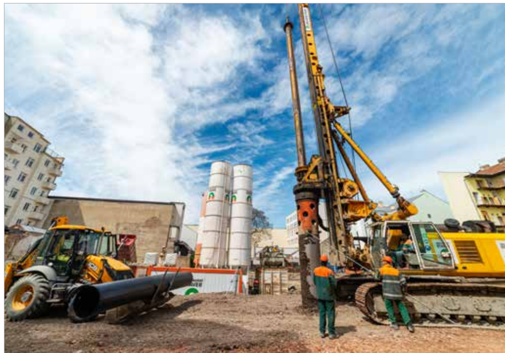
Hloubení vrtů pro čerpací studny
