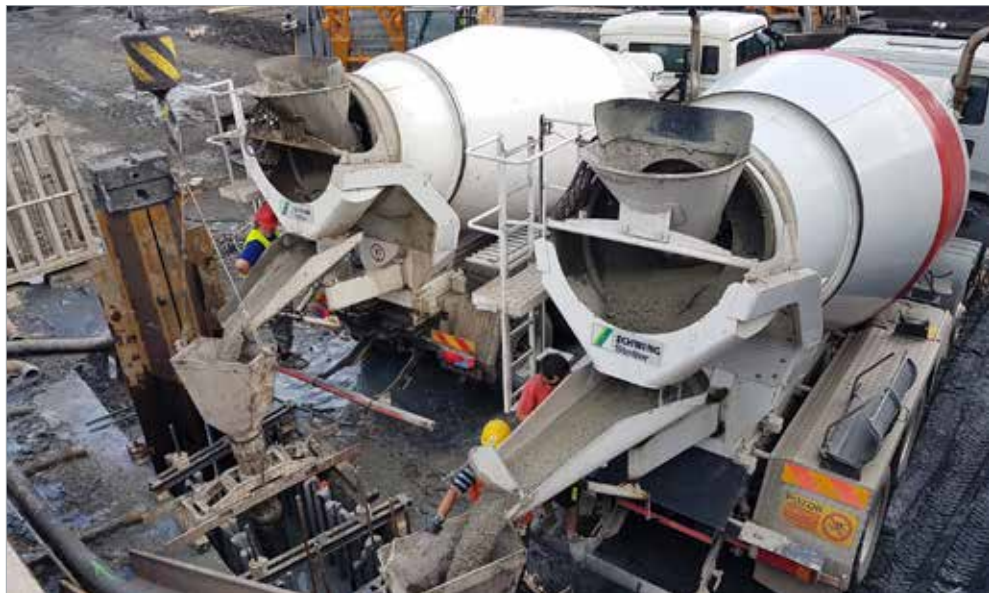
Současná betonáž lamely podzemní stěny dvěma autodomíchávači
