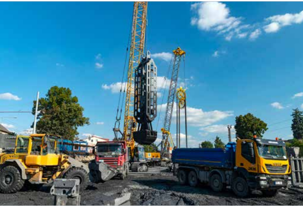
Hloubení prostřední stěny budoucího tunelu tl. 1500 mm drapákem a hydrofrézou
