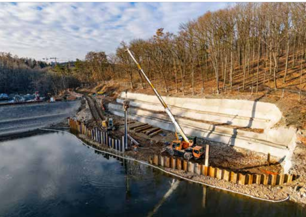
Beranění štětovnic návodní části stavební jámy bezpečnostního přelivu
