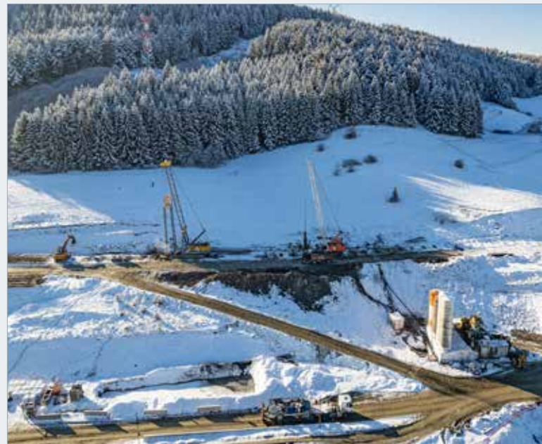
Stavenisko počas ťažby lamiel podzemných stien s výrobňou a čističkou bentonitovej suspenzie
