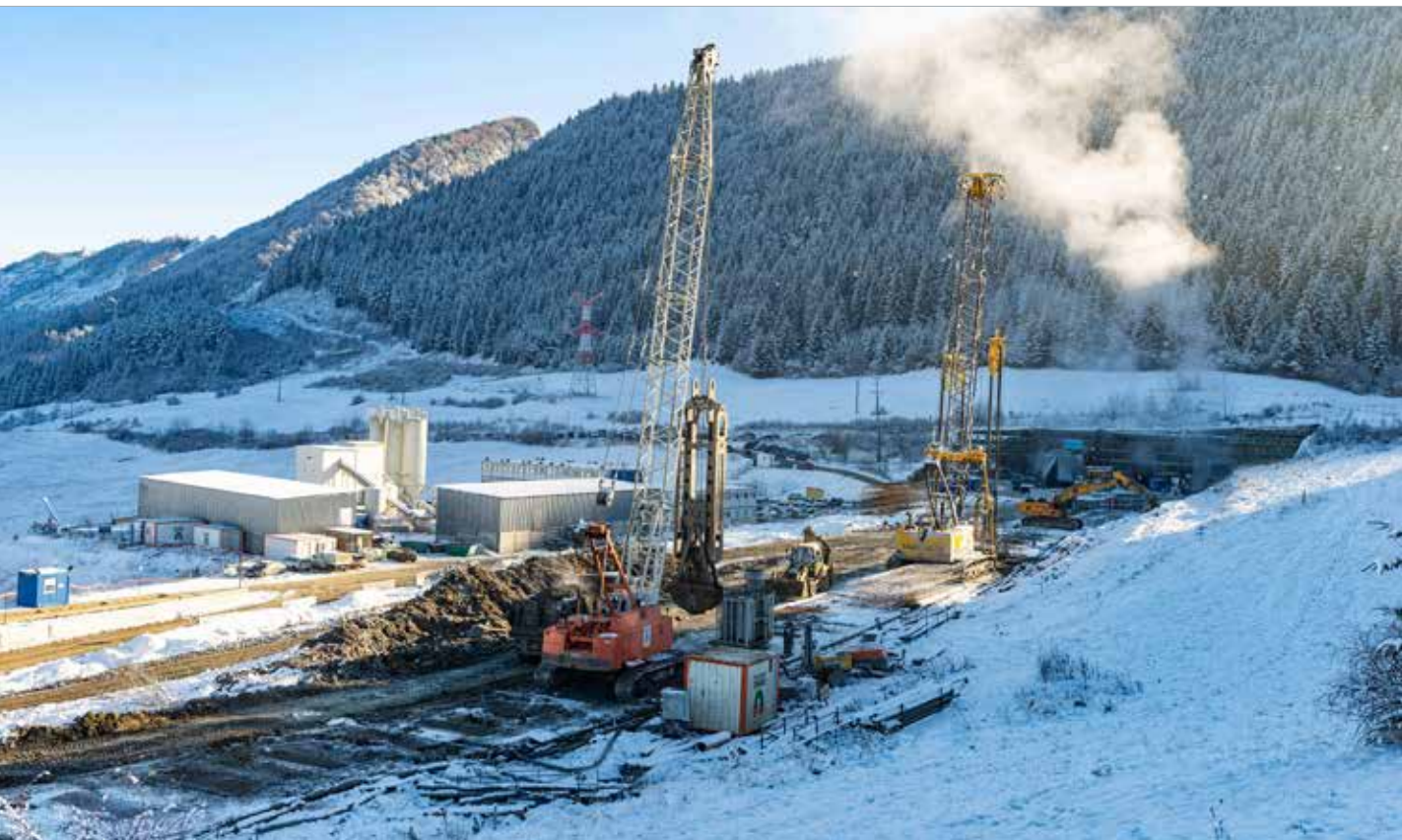
Realizace lamel podzemních stěn drapákem a hydrofrézou
