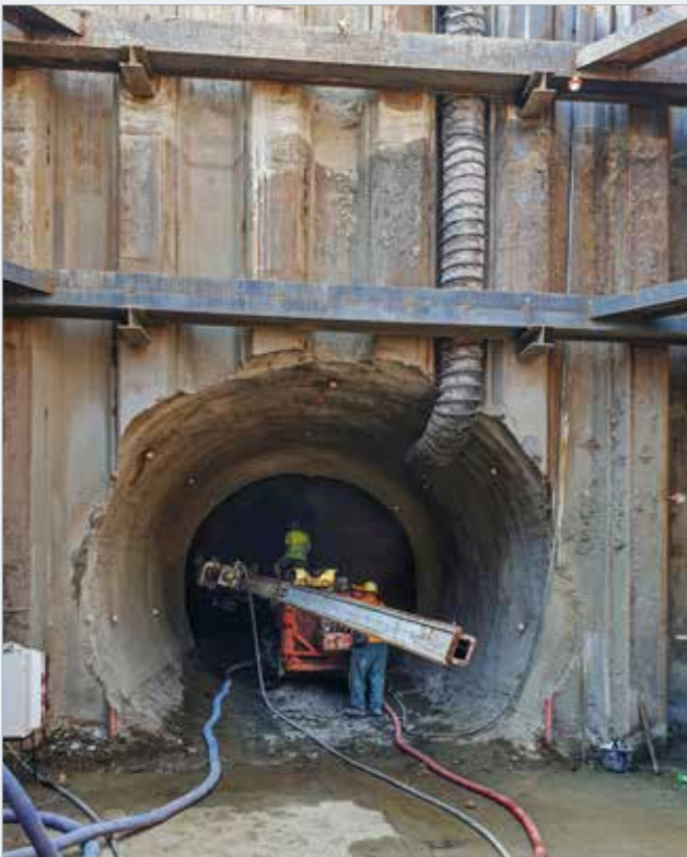
Provádění dovrchní tryskové injektáže z již částečně vyraženého tunelu
