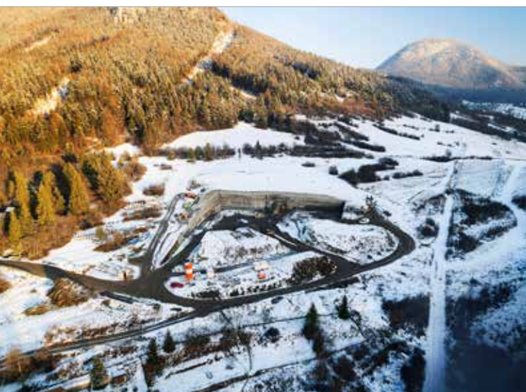
Celkový pohľad na stavebnú jamu portálu na razenie
