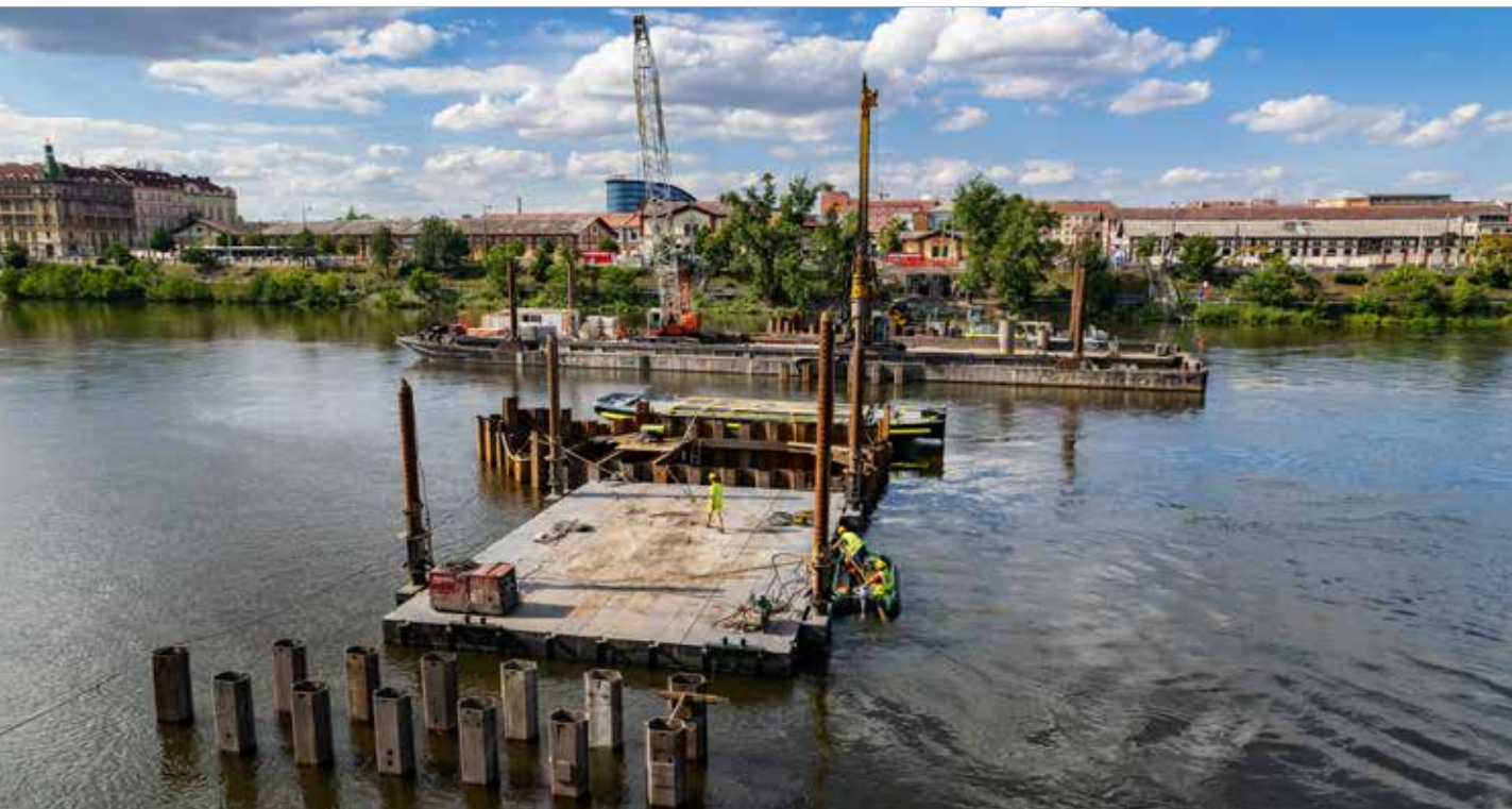
Zakládání dočasných podpěr montážní skruže lávky z lodí Jantar. Dokončeno je již trvalé pilotové založení dvou pilířů P50 a P40 a je obklopujících jednoduchých rozpíraných jímek ze štětovnic.
