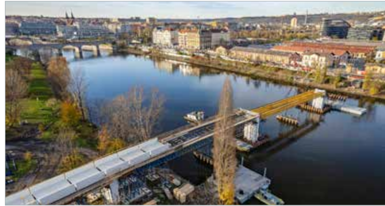
Pohled na výstavbu lávky v nesplavné části Vltavy a sestavování její nosné konstrukce na pevné skruži, podepřené dvěma trvalými pilíři a třemi dočasnými podpěrami
