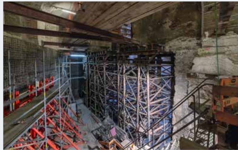
Mikropilotové bárky mezi objekty D a E1
