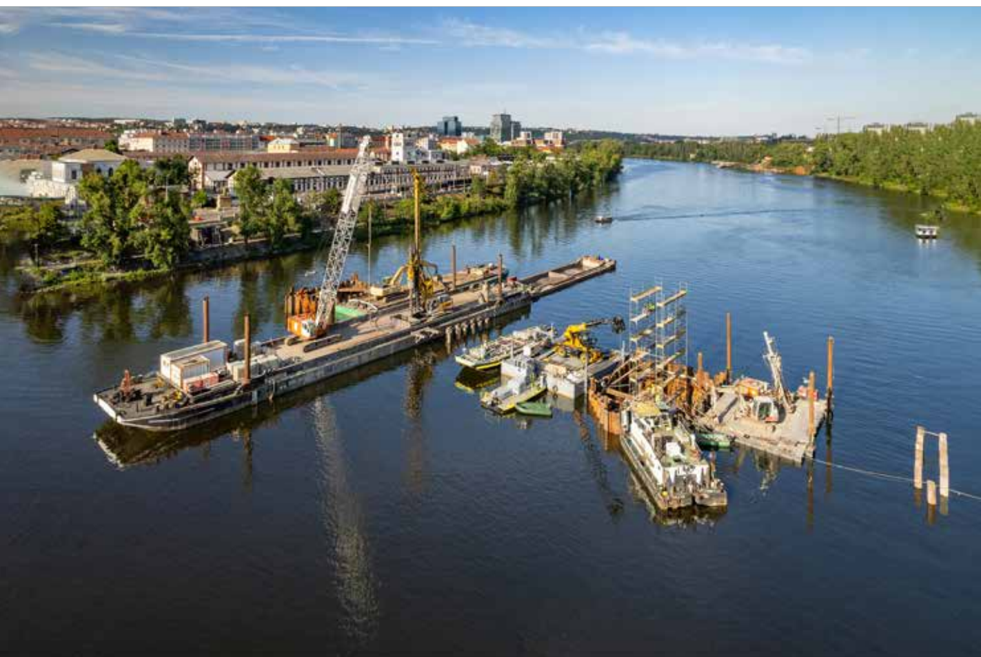
Zakládání dočasných podpěr montážní skruže lávky, trvalé pilotové založení dvou pilířů je již dokončeno a navazuje na ně výstavba dřívků pilířů pod ochranou rozpíraných štětových jímek.
