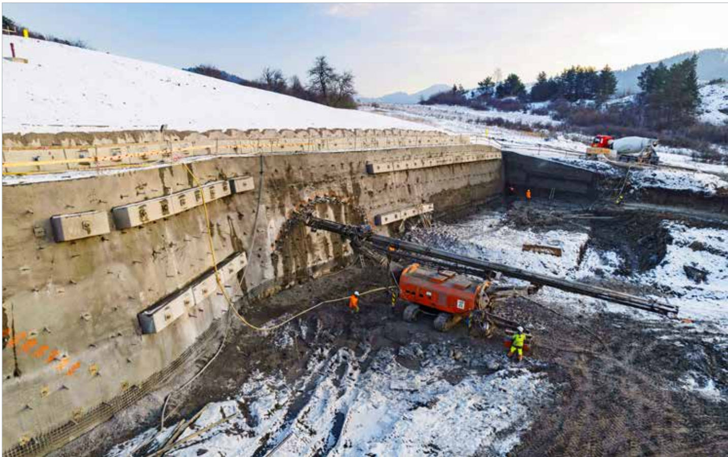
Pohľad na čelnú stenu zaistenia portálu, realizácia mikropilótového dáždnika
