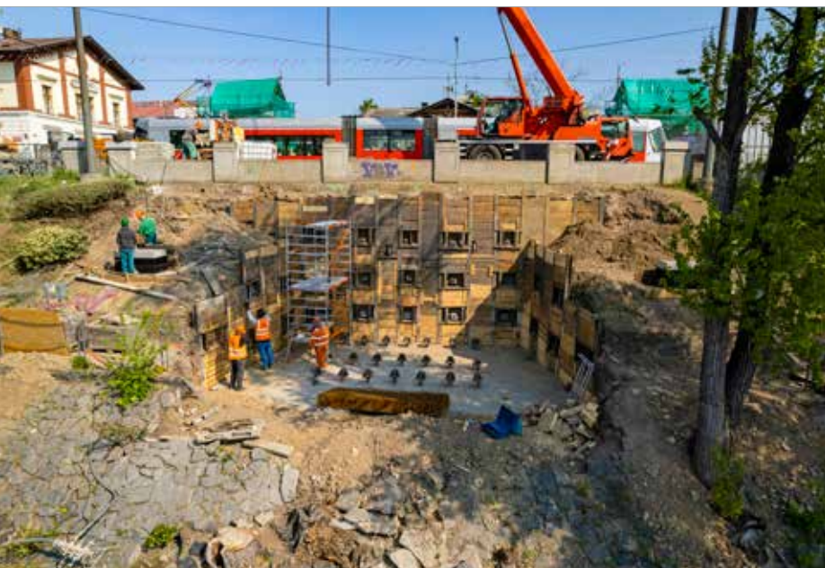
Založení opěry OP60 na Bubenském nábřeží na mikropilotovém roštu pod ochranou kotveného záporového pažení
