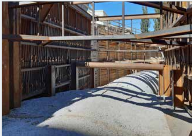
První delší jímka s již osazeným vedením výpusti OS 6B D3200
