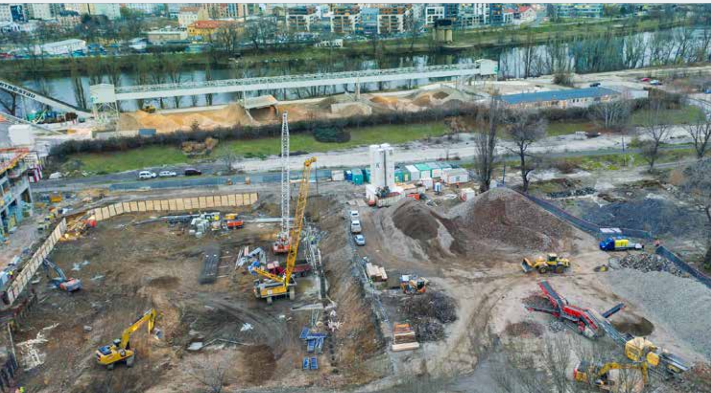
Realizace podzemních stěn retenční nádrže a čerpací stanice
