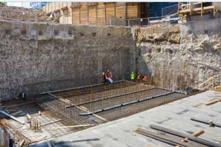
Realizace základové desky v jámě zapažené kotvenými PS
