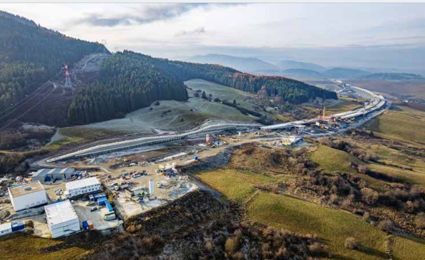
Celkový pohľad na zárubný múr pred tunelom Višňové
