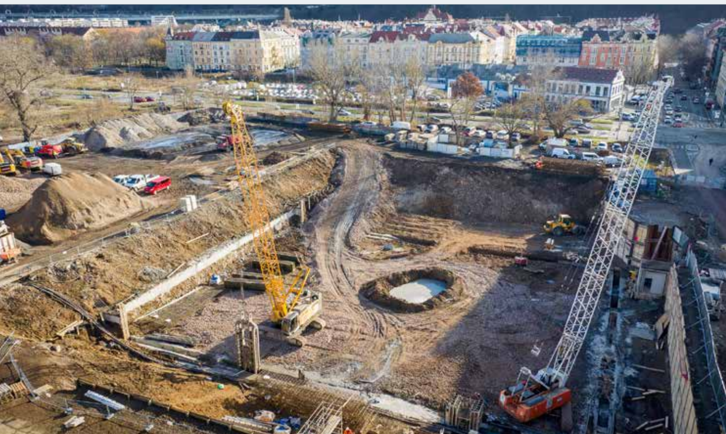
Realizace podzemních stěn retenční nádrže a čerpací stanice
