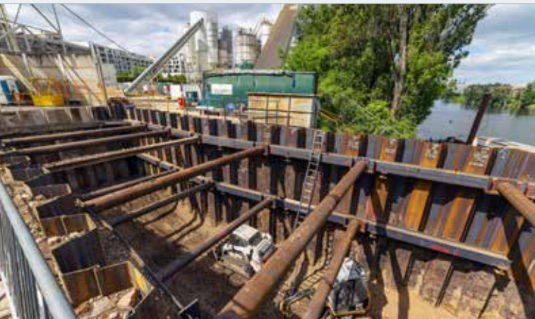
Druhá rozpíraná štětová jímka pro vedení výpusti OS 6B D3200
