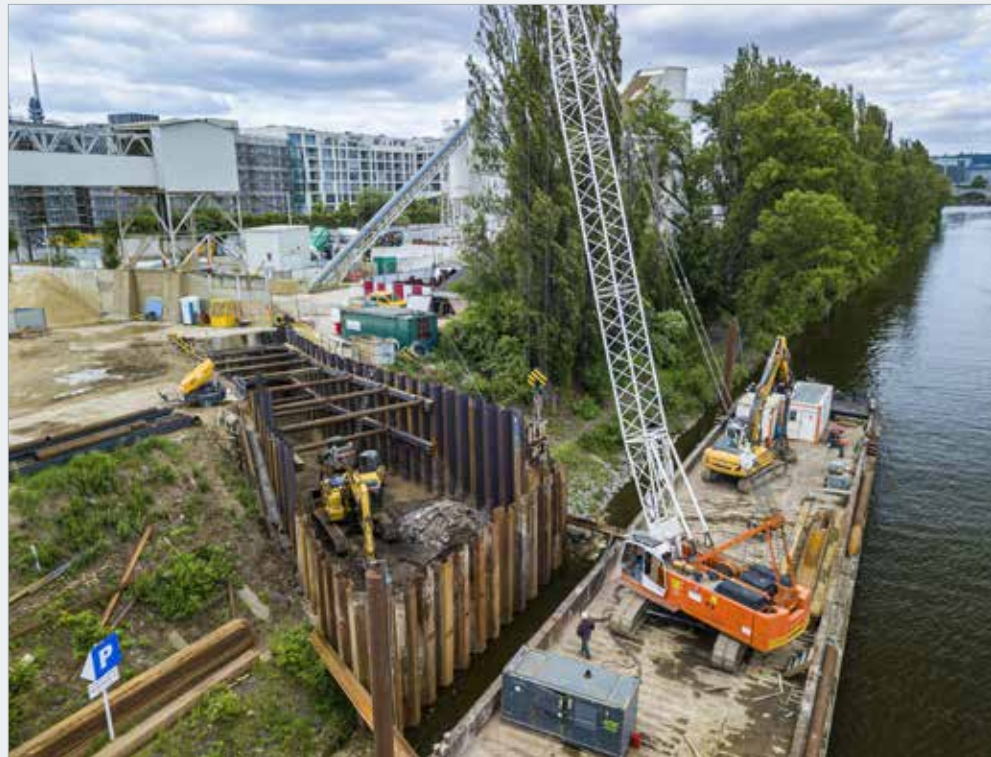
Beranění štětovnic druhé stavební jímky pro vedení výpusti OS 6B D3200
