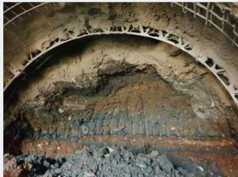
Zajištění kaloty raženého úseku obálkou ze sloupů tryskové injektáže
