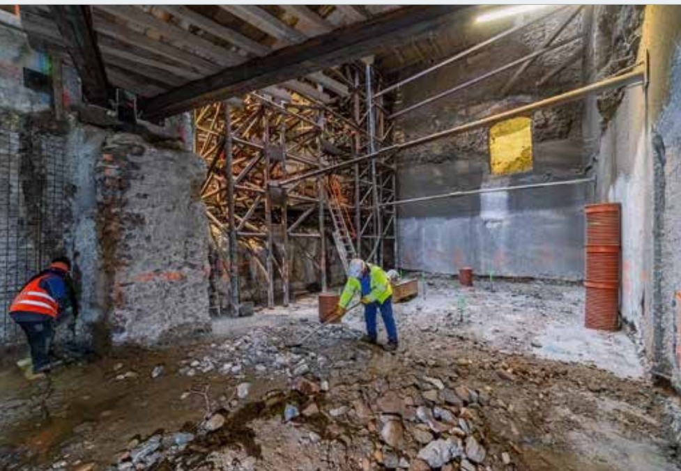
Úprava základové spáry v nově prohloubeném objektu E1, uprostřed MP bárka mezi obj. E1 a D
