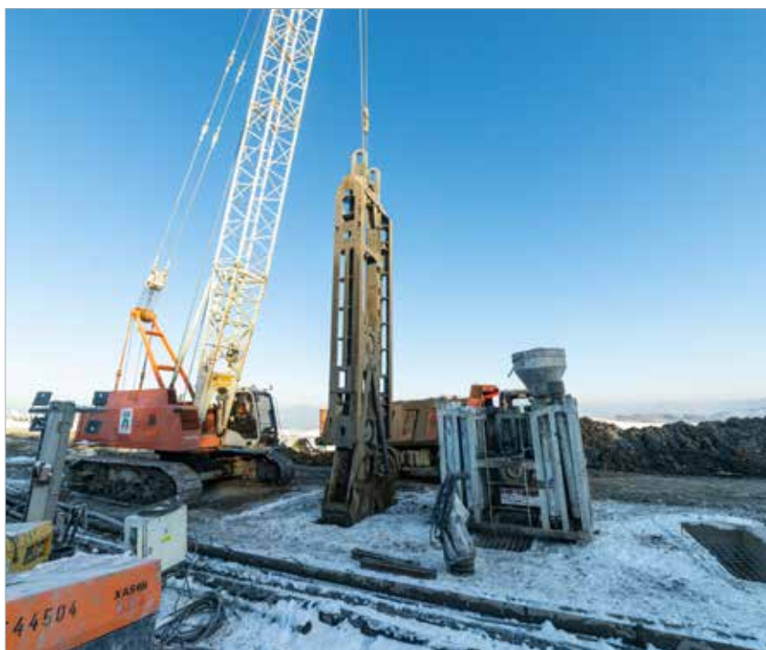
Předtěžení lamely drapákem Stein
