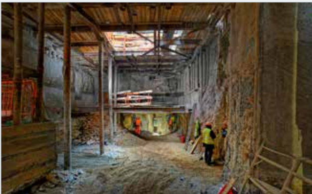
Zajištění výkopu v části objektu Y (rok 2020) ...
