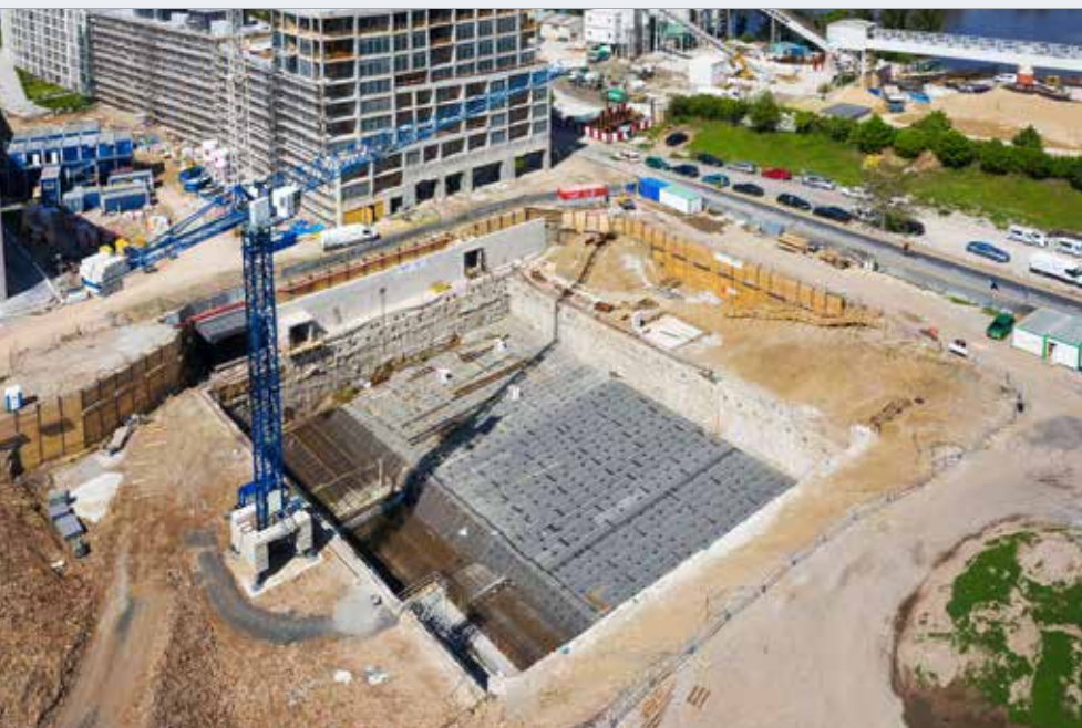
Výstavba vnitřních konstrukcí stavební jámy RN a ČS pod ochranou podzemních stěn
