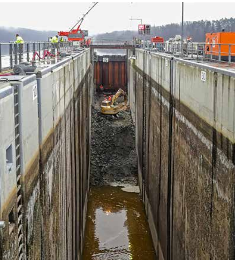
Odbourávání záporníku v horní části plavební komory
