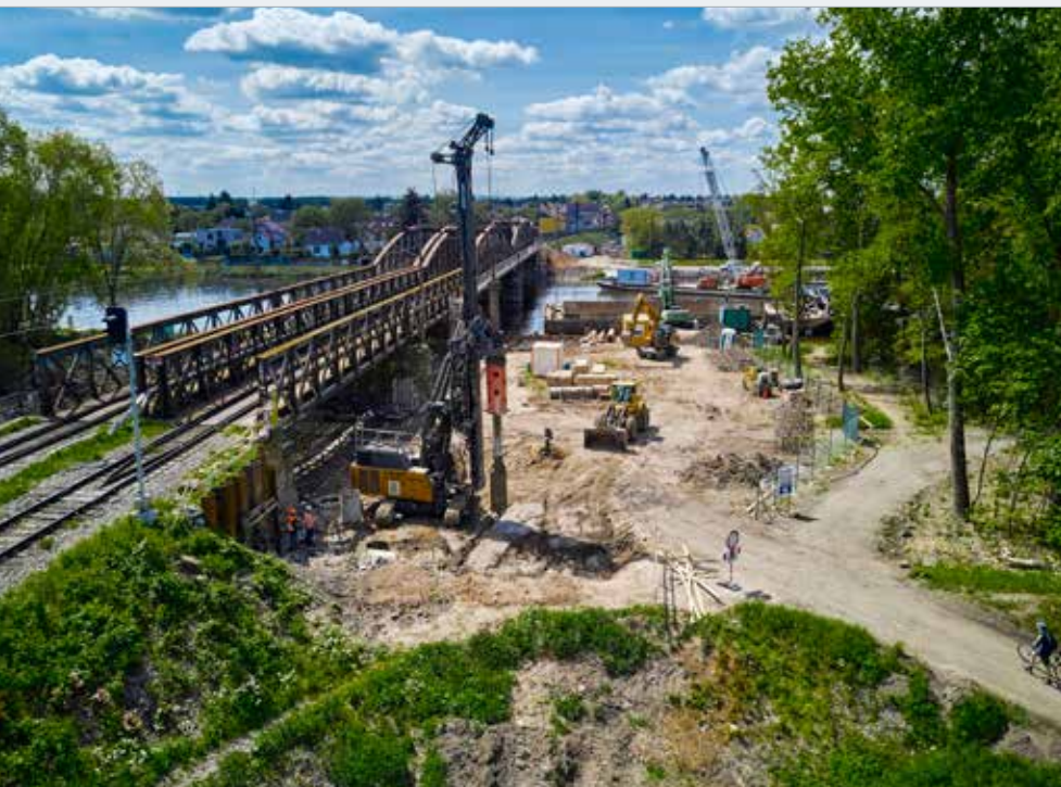
Pilotové zakládání provizorní opěry OP1 na levém břehu
