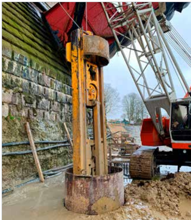
Provádění předvrtů maloprofilovou vrtnou soupravou a hloubení pilot pomocí drapáku osazeného na nosiči Liebherr
