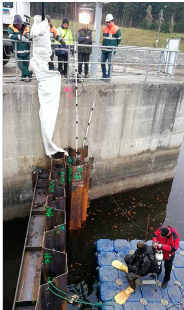
Těsnění boku hrazení plavební komory pomocí „rukávů“ plněných jillocementovou směsí
