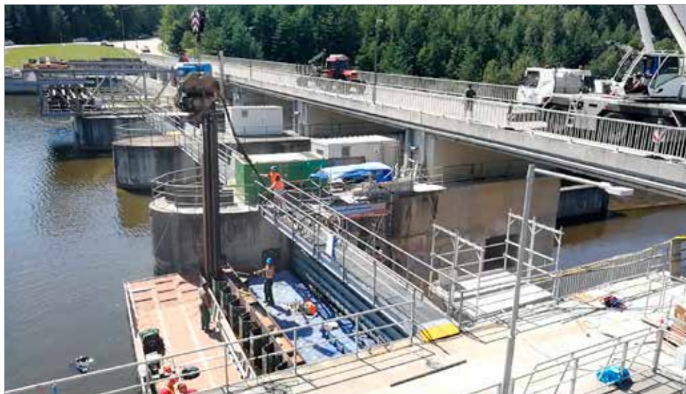
Instalace pažicí štětové stěny jímky SO 04.1 z mostovky VD pro zahrazení bezpečnostního přelivu č. 7
