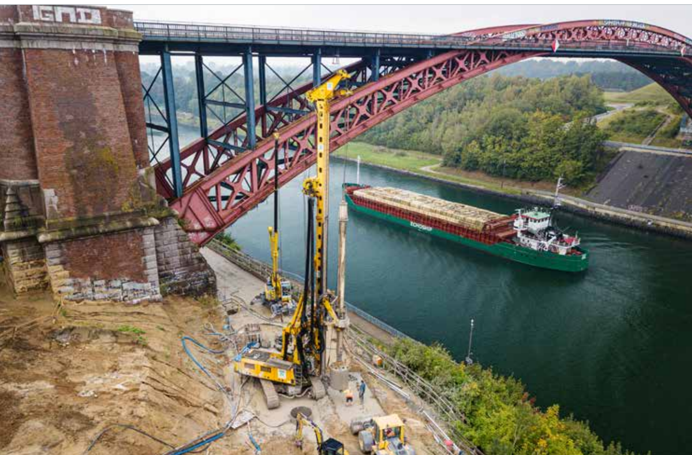
Hloubení pilot průměru 1500 mm pod ochrannou pažící suspenze vrtnou soupravou Bauer BG 36 na severozápadní straně mostu
