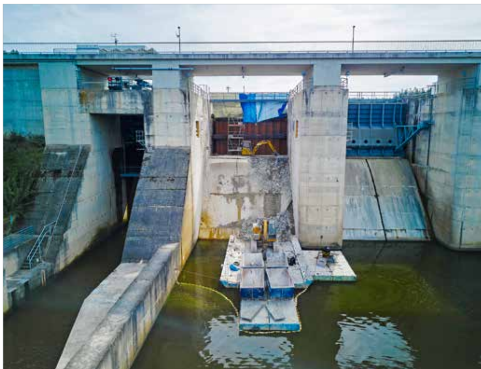
Bourací práce na dně bloku č. 7 bezpečnostního přelivu probíhají pod ochranou štětové jímky.
