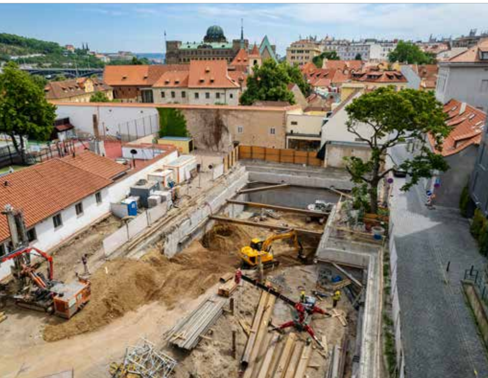
Výkop stavební jámy s částečně osazeným rozpěrným rámem
