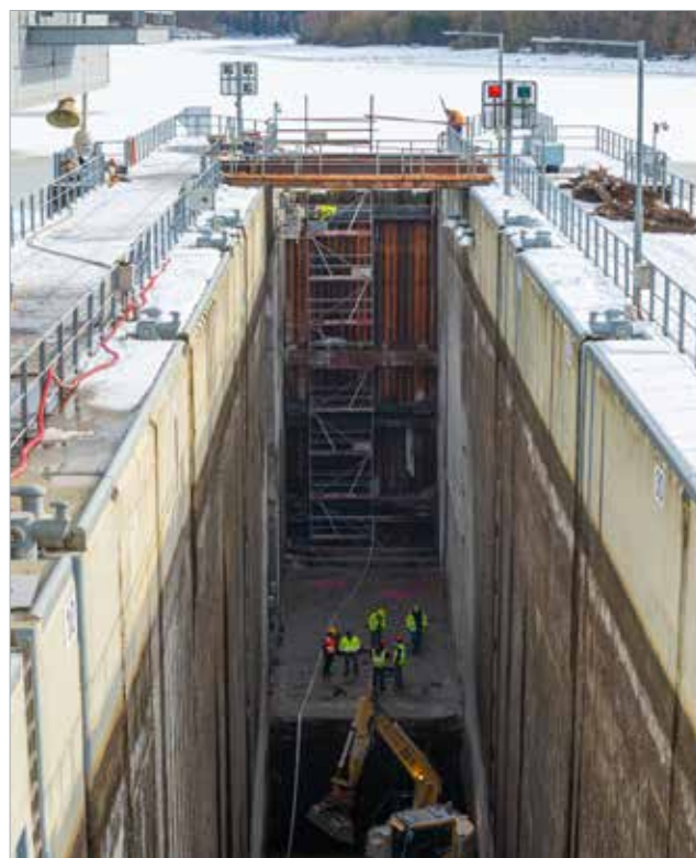
Dokončené pažení plavební komory umožnilo provádění stavebních prací pro zkapacitnění povodňového průtoku
