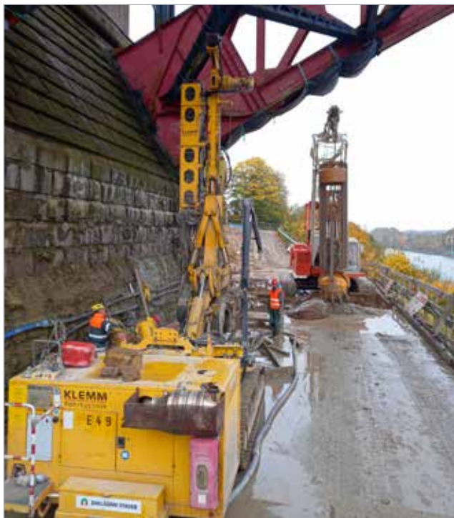
Provádění předvrtů maloprofilovou vrtnou soupravou a hloubení pilot pomocí drapáku osazeného na nosiči Liebherr
