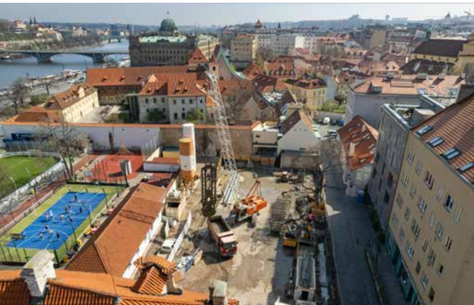
Těžba podzemních stěn, v pozadí klášter sv. Anežky České
