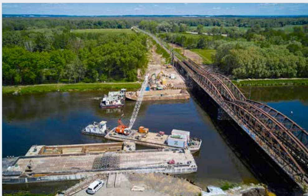
Zahájení rekonstrukce mostu, provedeny jsou přístavní hrany ze štětových stěn na obou březích (tlačný člun Jantar 1000 t, plovoucí bagrjeřáb ZS/Hanka)
