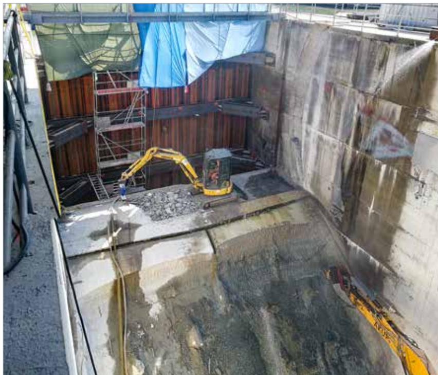
Bourací práce na dně bloku č. 7 bezpečnostního přelivu probíhají již pod ochranou štětové jímky SO 04.1
