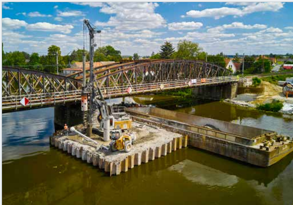
Pilotové založení pilíře P3 pro mostní provizorium z pracovní roviny dvojité nasazené štětové jímky
