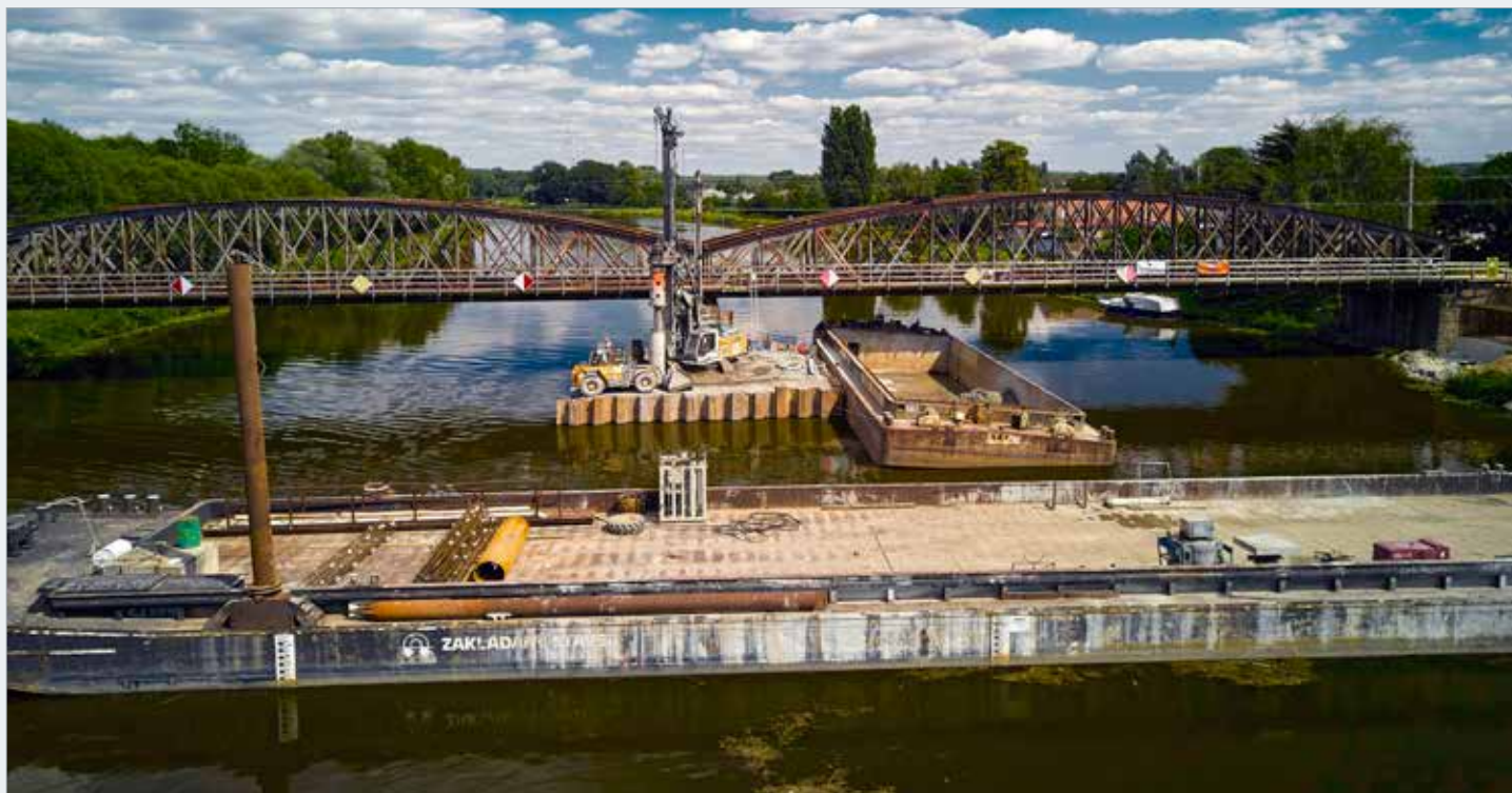
Pilotové zakládání pilíře P3 pro mostní provizorium, v popředí tlačný člun Jantar
