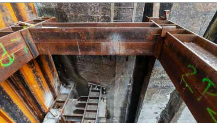
Detailní pohled na druhou rozpěrnou úroveň s příčnickem osazeným do drážky pro hrazení, níže je vidět 3. rozpěrná úroveň s již instalovaným kotveným příčnickem.
