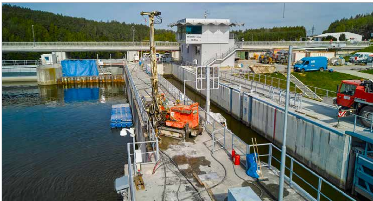
Hloubení vrtů pro osazení tyčových kotev do stěn plavební komory, vlevo nahoře zahrazené pole bezpečnostního přelivu č. 7
