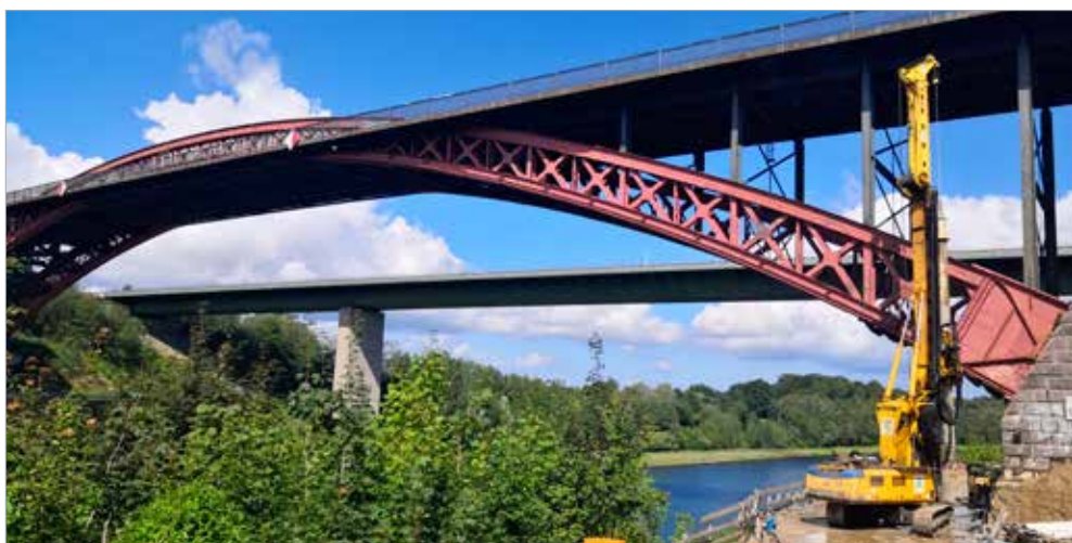
Provádění pilot na jihozápadní straně mostu
