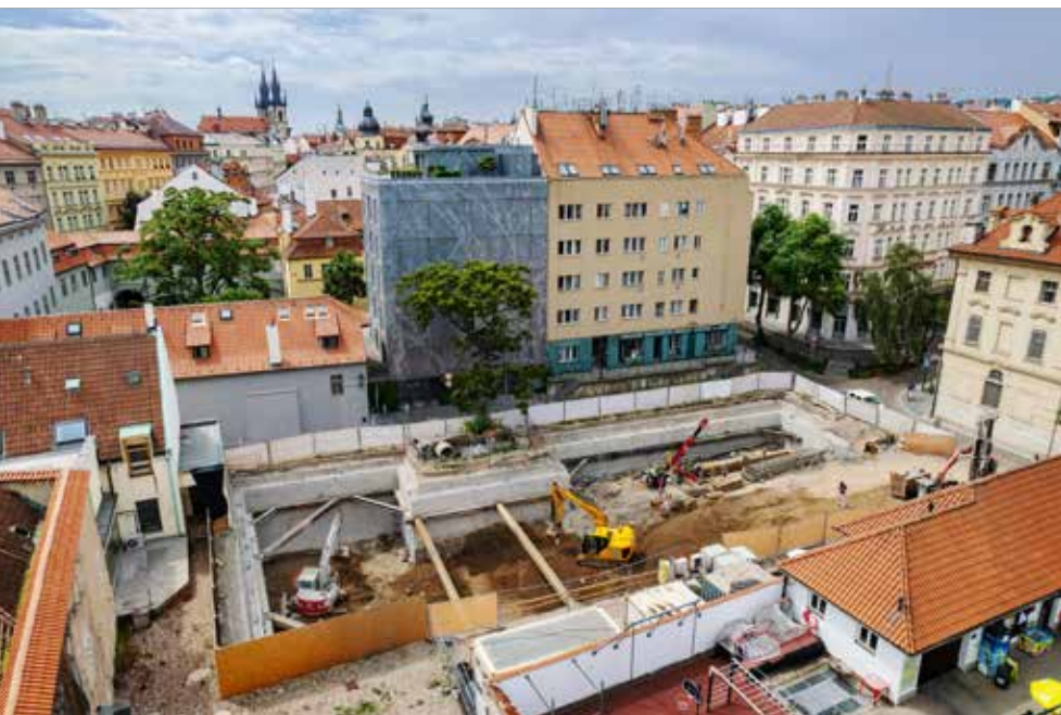
Další fáze výkopu stavební jámy s probíhajícím frézováním povrchu podzemních stěn
