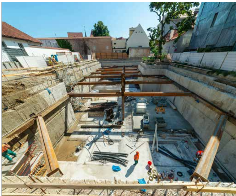
Zajištěná stavební jáma během realizace základové desky
