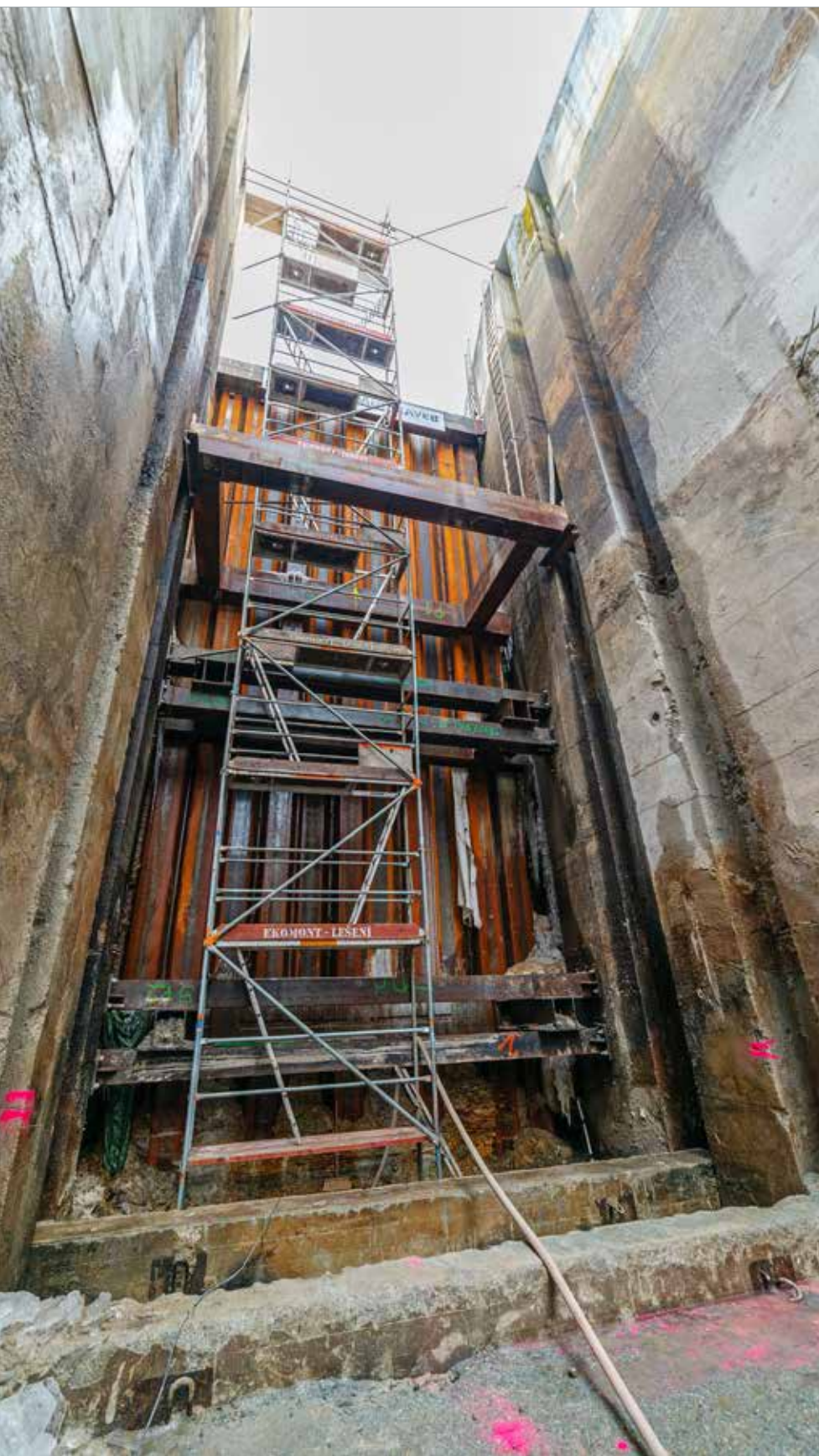
Dokončená jímka SO 04.3 v horním zhlaví plavební komory rozpíraná v pěti úrovních přenášející zatížení až 16,5 m vodního sloupce
