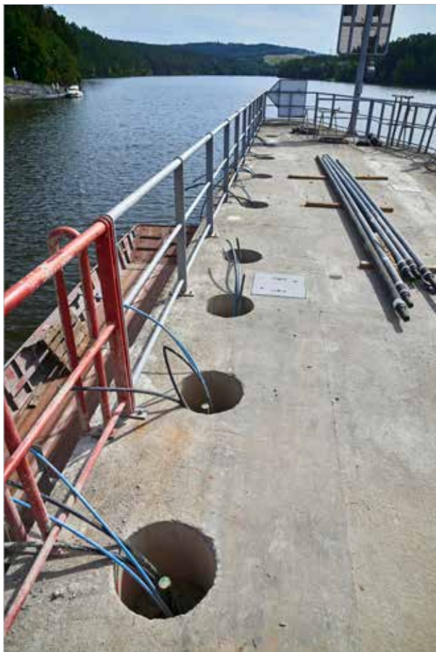
Osazené tyčové kotvy ve stěně plavební komory před injektáží
