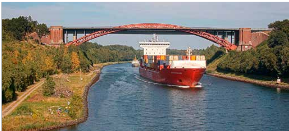
Průjezdny profil stávajícího mostu umožňuje jen jednosměrnou současnou plavbu velkých lodí
