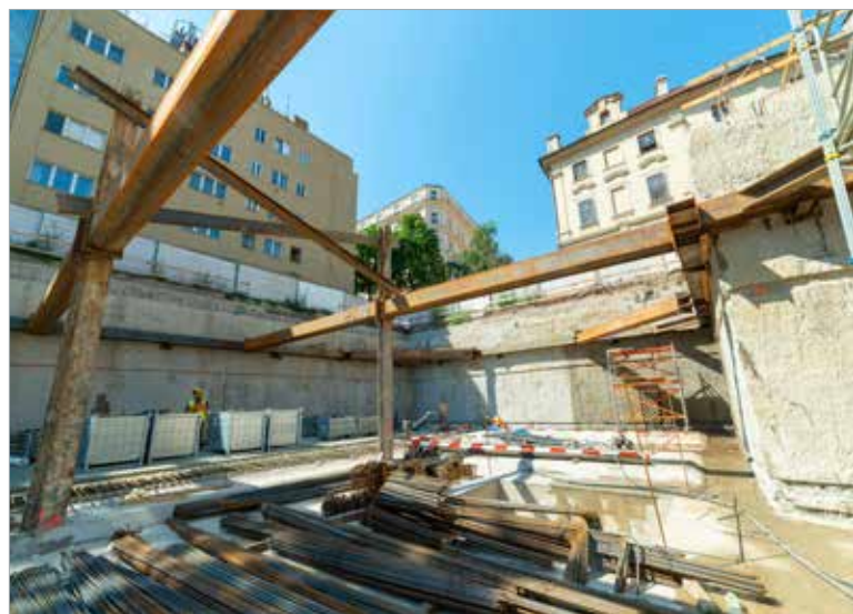
Detailnější pohled na rozpěry s mezilehlými podpěrami
