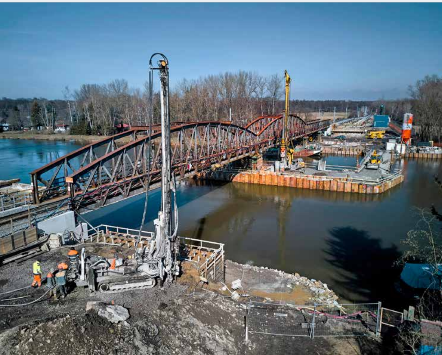
Současné zakládání trvalé opěry OP2 na piliřích tryskové injektáže s vyztužením mikropilotami a piliře P3 na velkopřůměrových pilotách v řečišti s přístupem přes pontonový most
