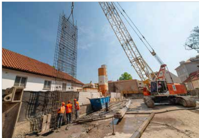
Těžba podzemních stěn na severní straně stavební jámy a následné osazování armokoše do zapažené rýhy
