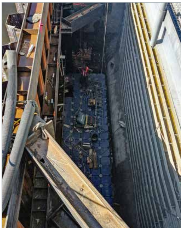
Provádění 3. rozpěrné úrovně na jímce SO 04.1 z pontonové sestavy z částečně vyčerpaného prostoru mezi rubem jímky a bezpečnostním hrazením
