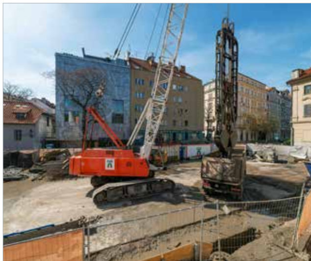
Těžba podzemních stěn na severní straně stavební jámy a následné osazování armokoše do zapažené rýhy
