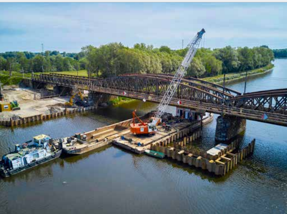
Beranění dvojité jímky pro založení pilíře P3 pro mostní provizorium s využitím plovoucího bagrjeřábu ZS – Hanka a tlačného člunu 200 t
