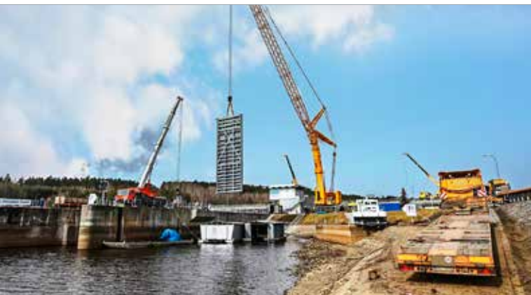
Instalace vrat na horní ohlavi prohloubené plavební komory
