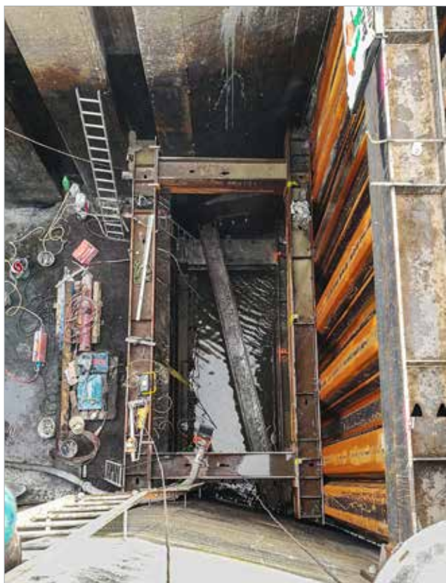
Pohled do hrazeného prostoru za jímku v plavební komoře během instalace kotvených příčníků na třetí rozpěrné úrovni, v popředí je vidět druhá rozpěrná úroveň s kotveným příčníkem osazeným do drážky pro hrazení
