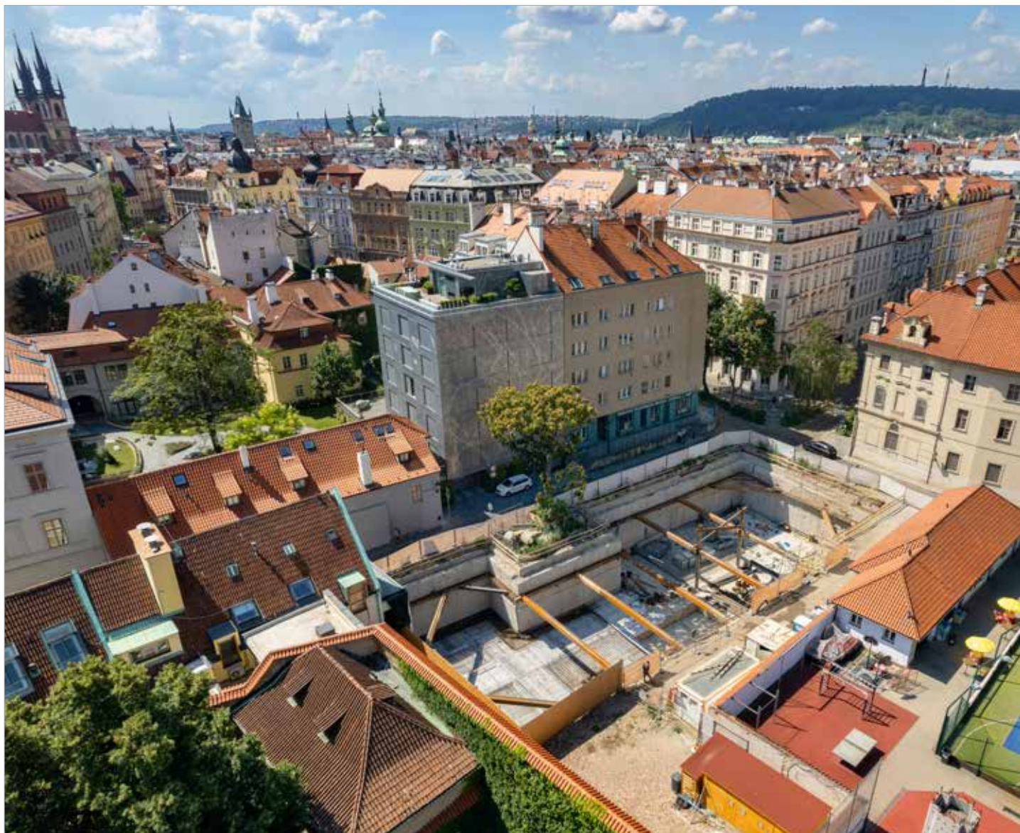
Pohled na stavební jámu budoucí novostavby v pražské památkové rezervaci
