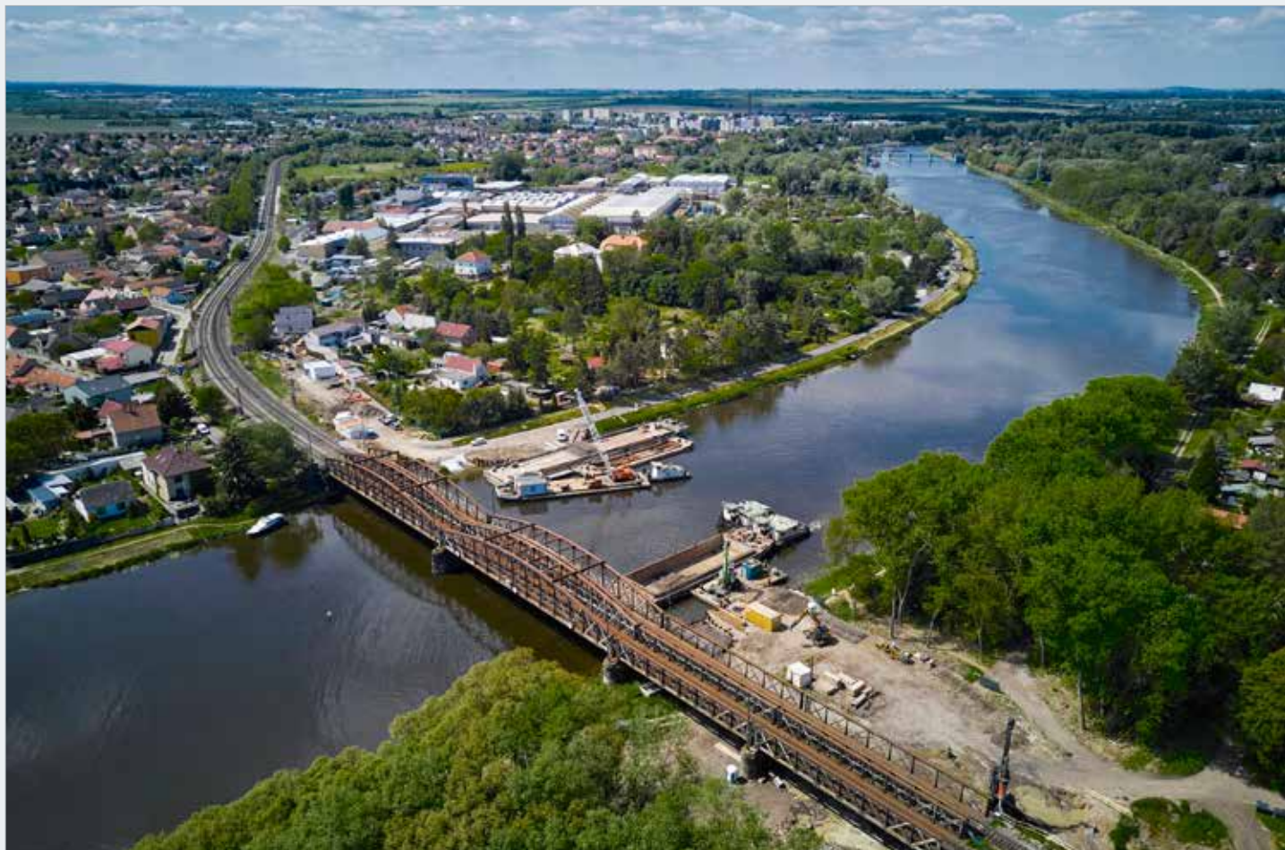
Zahájení rekonstrukce mostu, provedeny jsou přístavní hrany ze štětových stěn na obou březích
