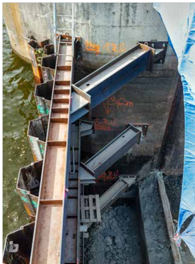
Dokončené rozpěrné pažení na jímce SO 04.1
