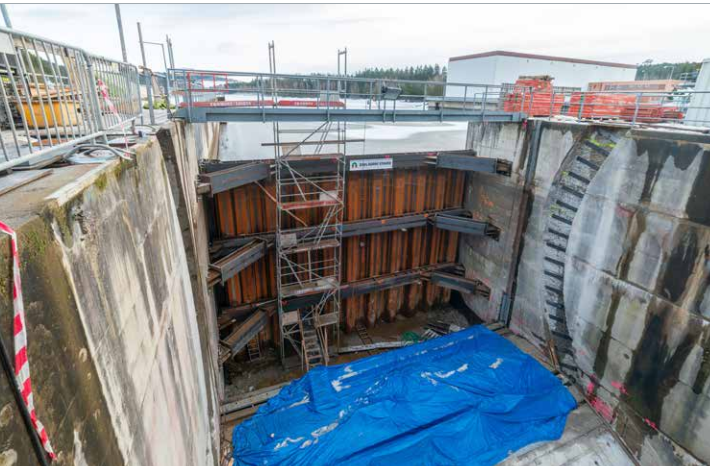
Hrazení bloku č. 7 bezpečnostního přelivu jímkou SO 04.1, stav před instalací vodících prvků segmentového uzávěru
