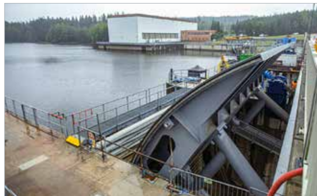
Nově instalovaná hradící konstrukce bezpečnostního přelivu na rekonstruovaném bloku č. 7
