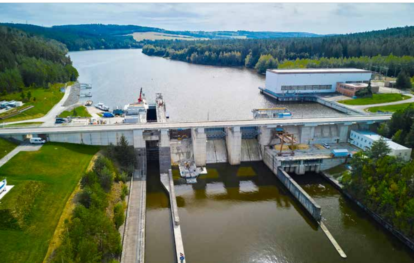
VD Hněvkovice, probíhají práce na kotvení stěn plavební komory a bourací práce ve dně bloku č. 7 bezpečnostního přelivu.
