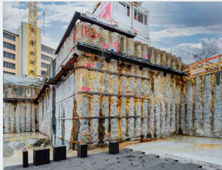
Detail pažení převrtávanými pilotovými stěnami na stavbě KNESE
