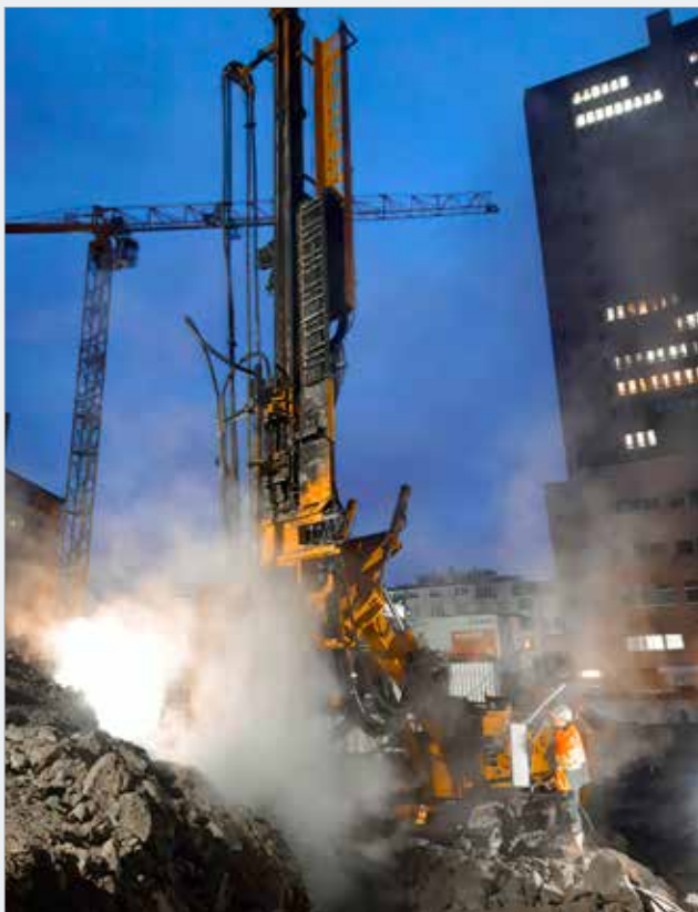
Realizace plošné tryskové injektáže na stavbě KNESE vrtnou soupravou Casagrande C7XP
