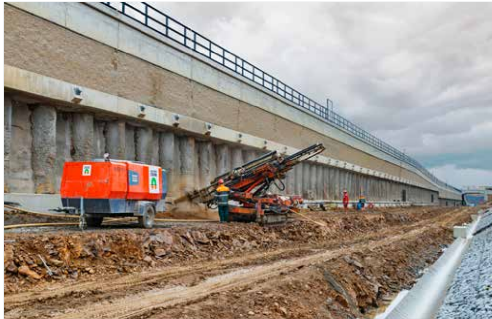
Zárubní zeď Lipiny vpravo, hloubení vrtů pro osazení trvalých kotvě, pohled k jihu
