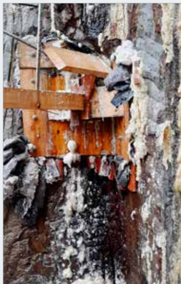
Detail poruchy ve stěně z tryskové injektáže o velikosti zhruba fotbalového míče s vnikem podzemní vody a zeminy do stavební jámy a její následná sanace chemickou injektáží
