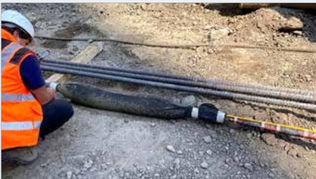
Zkušební injektáž geosyntetického vaku nainstalovaného na výztuži GEWI-mikropiloty
