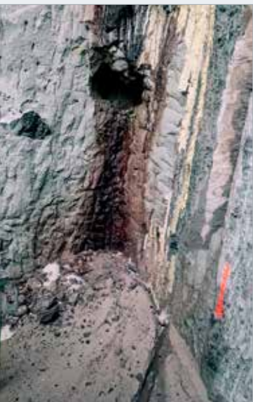
Detail poruchy ve stěně z tryskové injektáže o velikosti zhruba fotbalového míče s vnikem podzemní vody a zeminy do stavební jámy a její následná sanace chemickou injektáží
