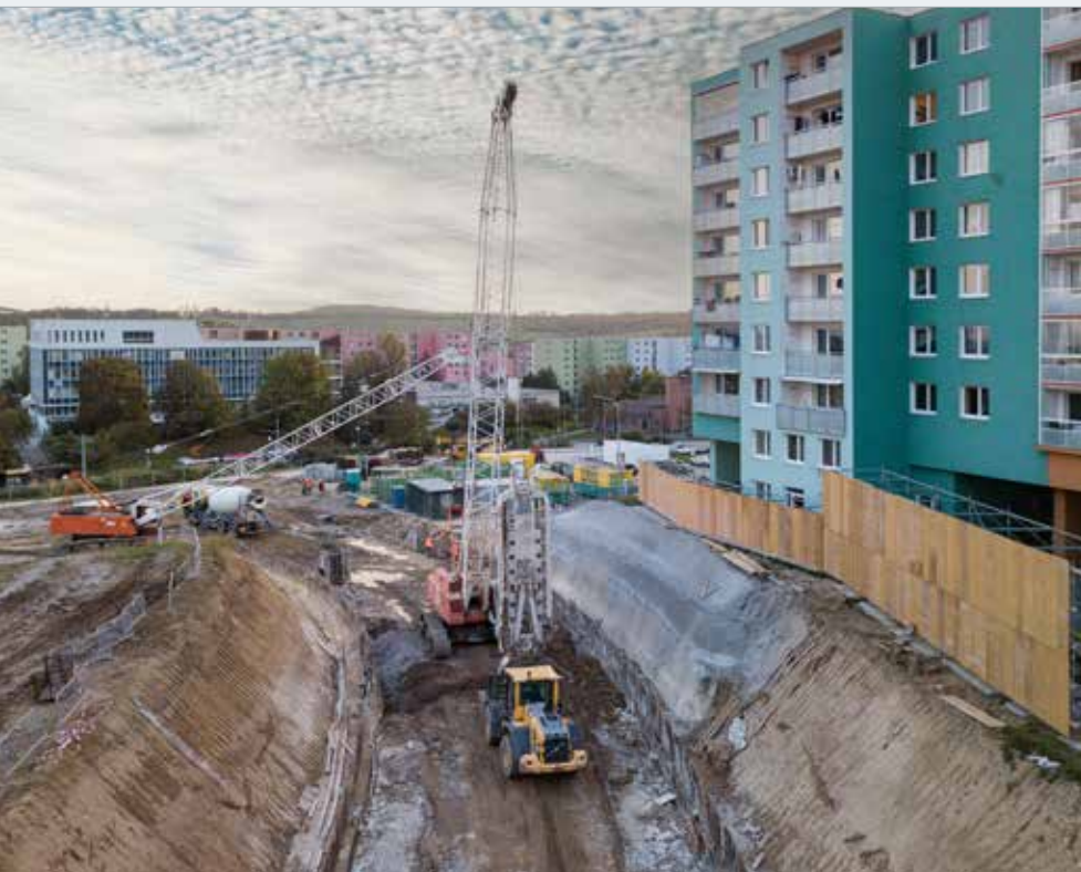
Těžba příčné podzemní stěny tl. 600 mm
