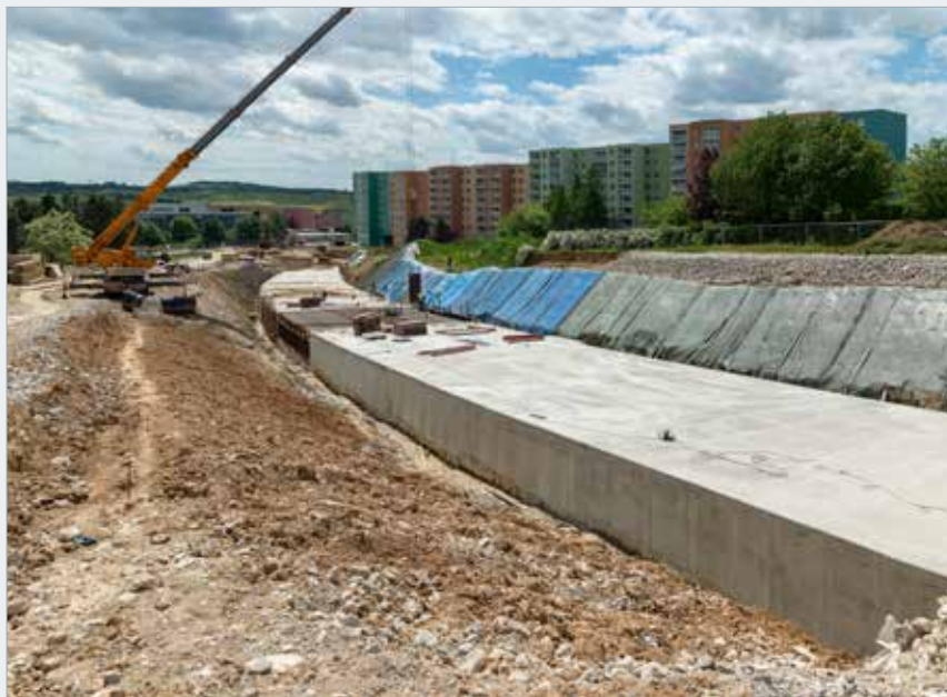
Pohled na dokončenou stropní konstrukci tunelu
