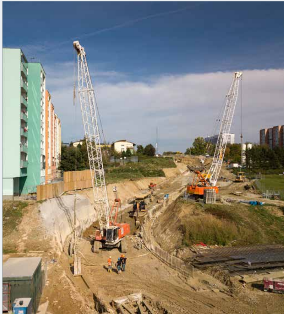
Těžba podzemní stěny tl. 800 mm v začátku staničení tunelu v blízkosti napojení na stávající tramvajovou trať v zastávce Osová
