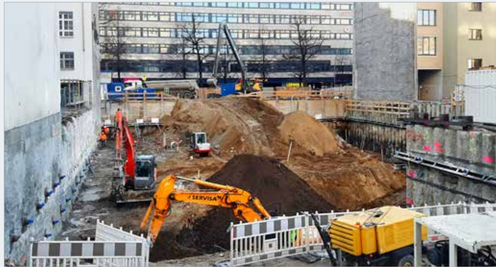
Celkový pohled na těsněnou stavební jámu KNESE v závěrečné fázi výkopových prací
