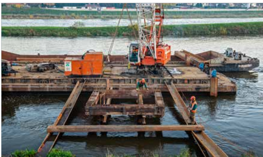
Pracovní fáze stražení rozpíraného rámu na pomocné konstrukce před beraněním vlastní štětové jímcce
