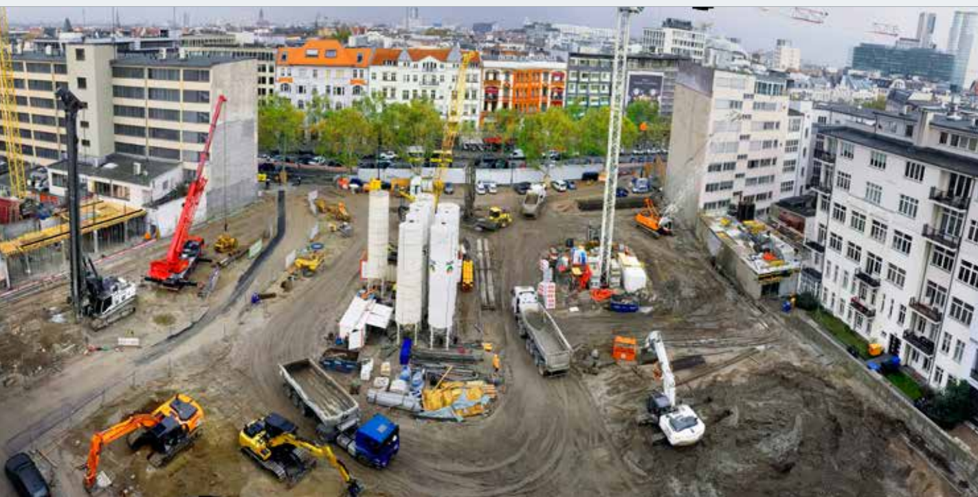
Stavební jáma KKB-Nord během provádění podzemních stěn
