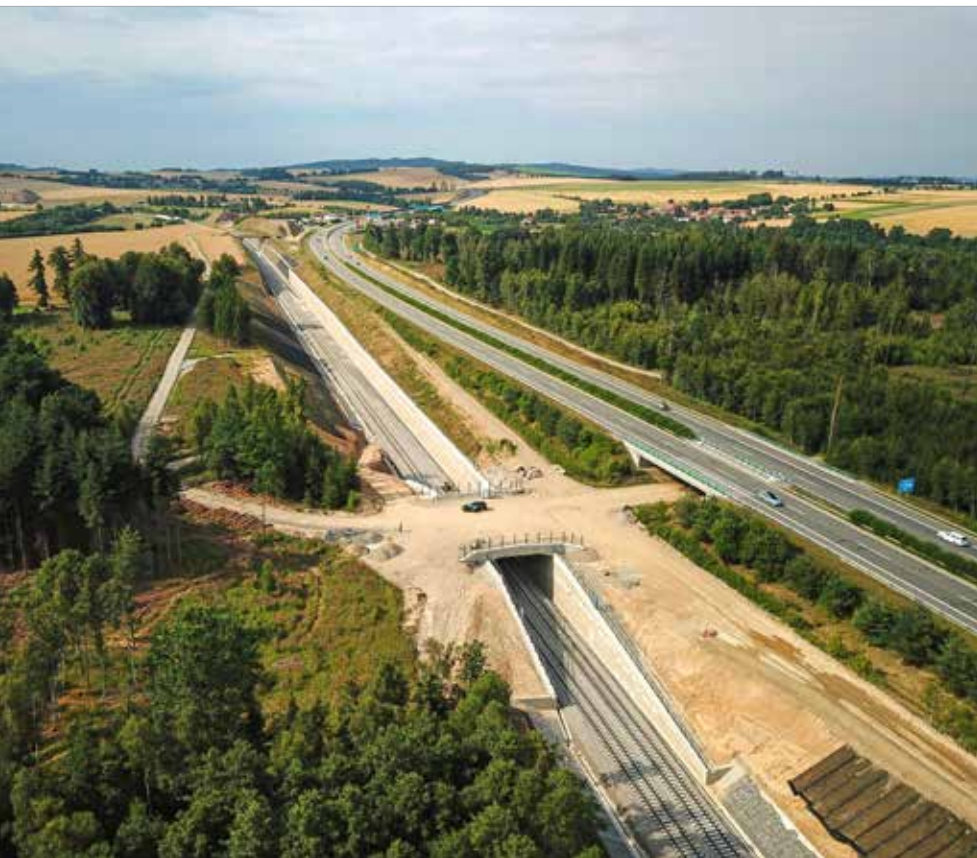
Železniční trať v oblasti Lipiny je vedena v hlubokém zářezu paralelně s dálnicí D3, pohled k severu
