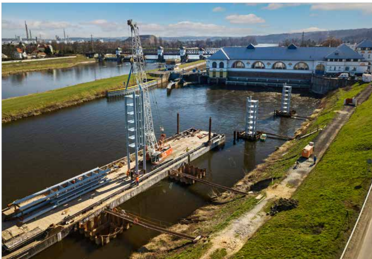
Osazování třetí dalby do štětové jímky
