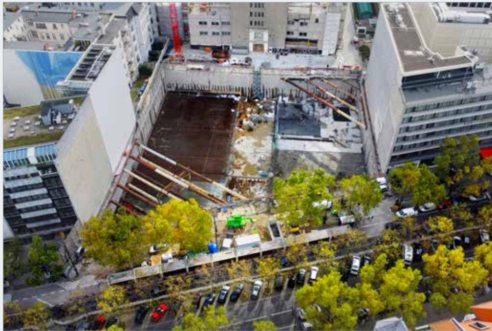
Letecký snímek dokončené stavební jámy KKB-Nord o půdorysné ploše 5500 m 2 s těsně přiléhající okolní zástavbou
