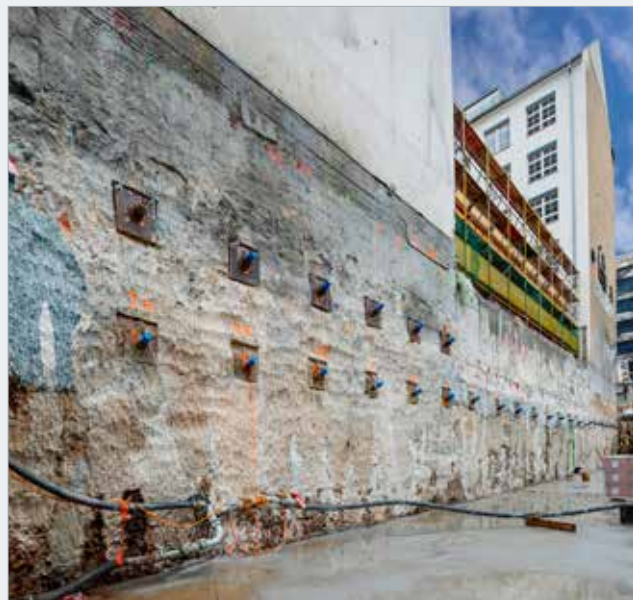
Podchycení sousedního objektu dvakrát kotvenou stěnou ze sloupů tryskové injektáže na stavbě KNESE
