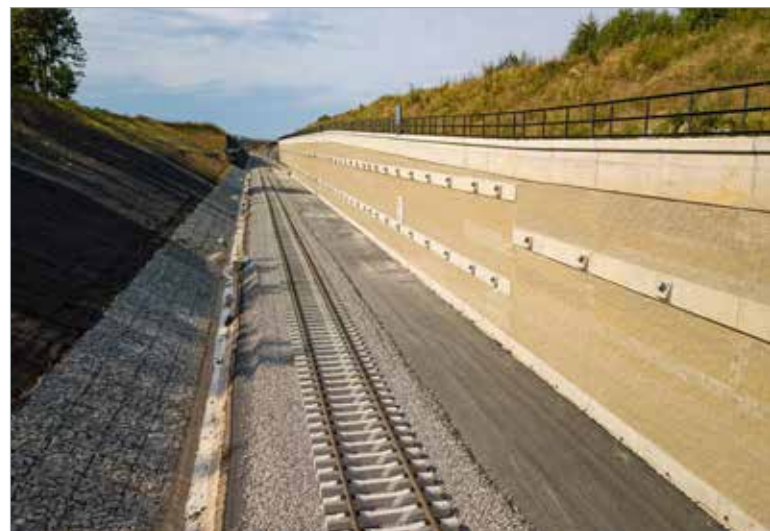
Zárubní zeď Lipiny vpravo, příčný řez traťovým zářezem s kotvenou pilotovou stěnou
