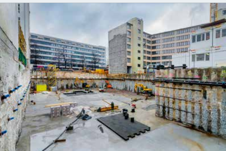
Celkový pohled na dokončenou stavební jámu KNESE. Jižní strana (vlevo) je zajištěna technologií tryskové injektáže, zbývající stěny pak stěnami z převrtávaných pilot.
