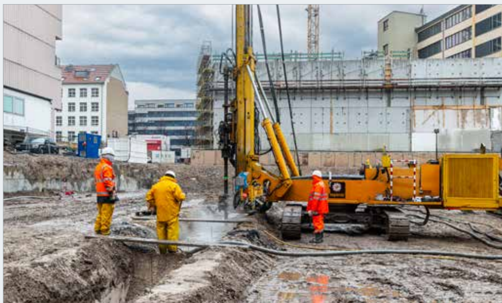
Detail provádění plošné tryskové injektáže na KKB-Nord
