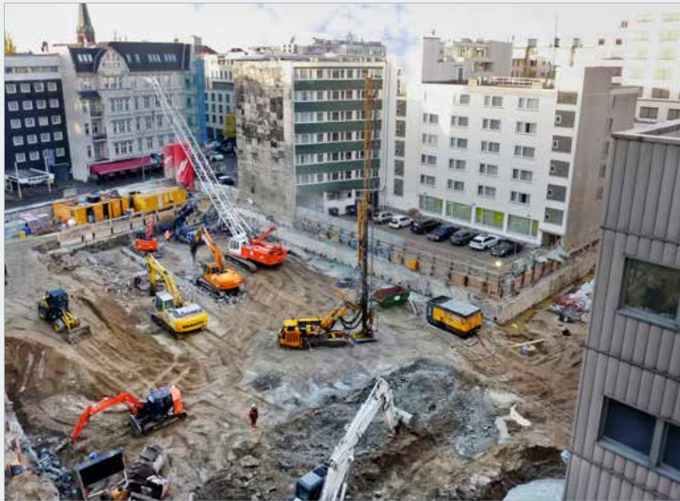
Vysoký počet strojů na malé ploše jakožto významný faktor ovlivňující celou dobu realizace stavební jámy KKB-Süd
