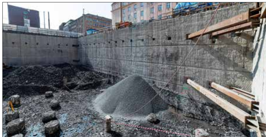
Západní strana zajištěné stavební jámy podél ulice V Háji
