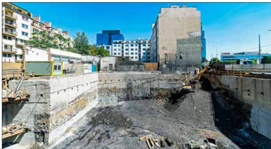
Dokončování těžby, pohled na východ
