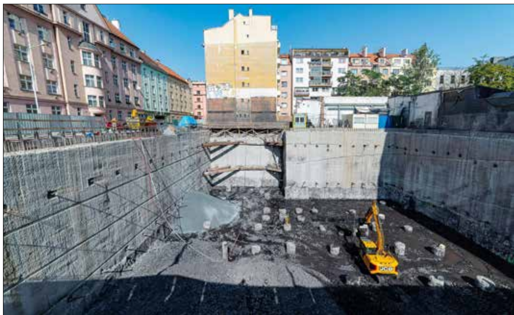
Dokončená stavební jáma před zahájením betonáže podkladních betonů
