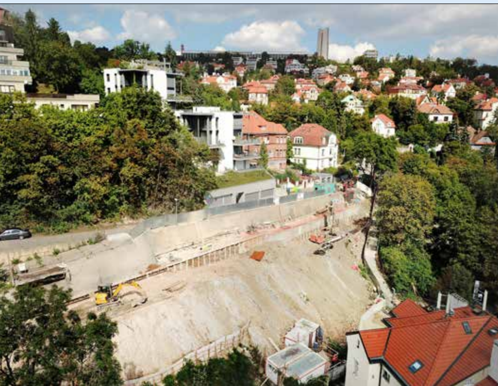
Instalace 1. stupně mikrozápor z pracovní úrovně pod zpevněnou kamennou zdí v Mošnové ulici
