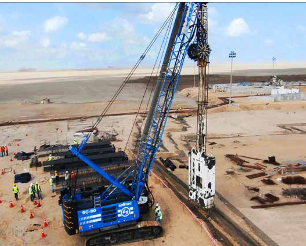
Těžba lamely podzemní stěny na úseku vjezdové rampy
