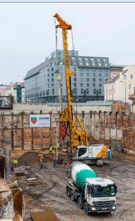
Betonáž základových pilot v západní části stavební jámy
