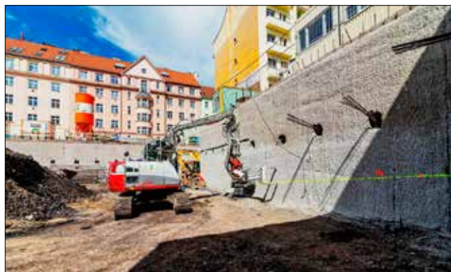
Frézování povrchu podzemních stěn
