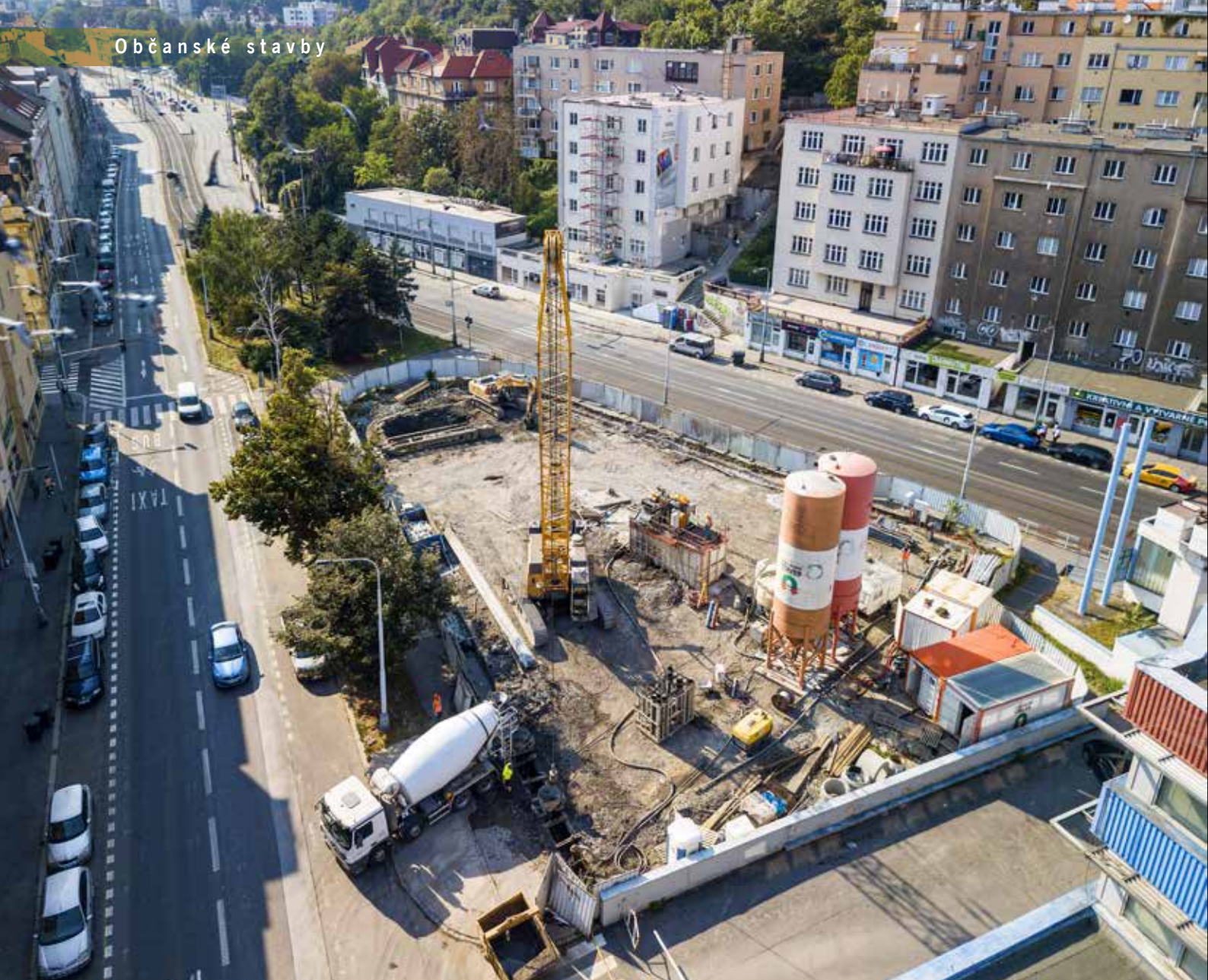
Provádění podzemních stěn s technologickým centrem pro výrobu a čištění paží bentonitové suspenze
