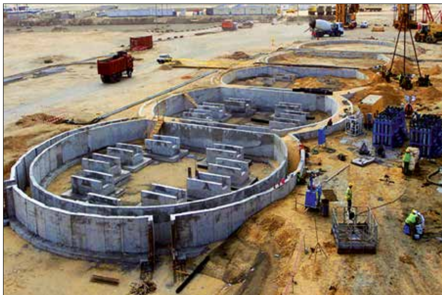
Vodící zídka pro startovací šachtu
