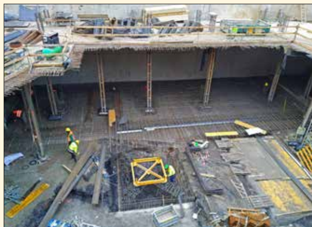
Provádění základové desky – vázání výztuže a montáž ocelového rámu (kříže) v základové patce jeřábu. Pohled na dočasné ocelové podpěry rozpěrné desky v úrovni stropu nad 2. PP.
