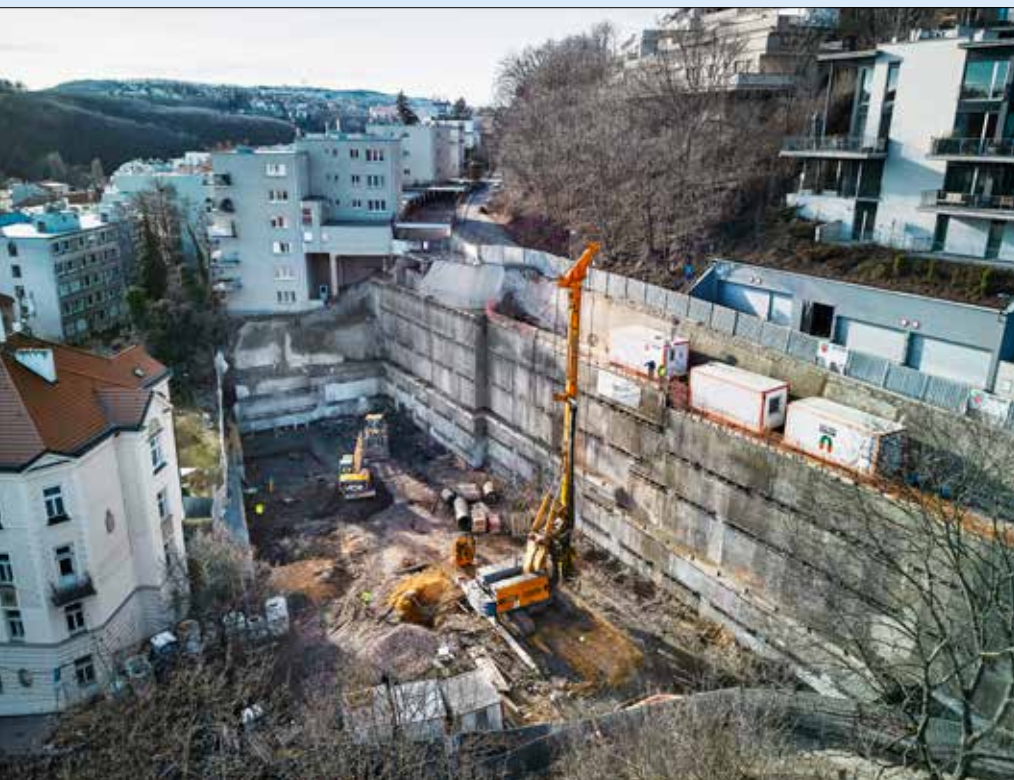
Celkový pohled na stavební jámu během provádění pilot z úrovně 5. PP
