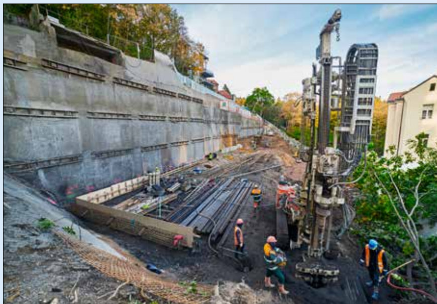
Instalace 2. stupně mikrozápěr ve 4. kotevní úrovni
