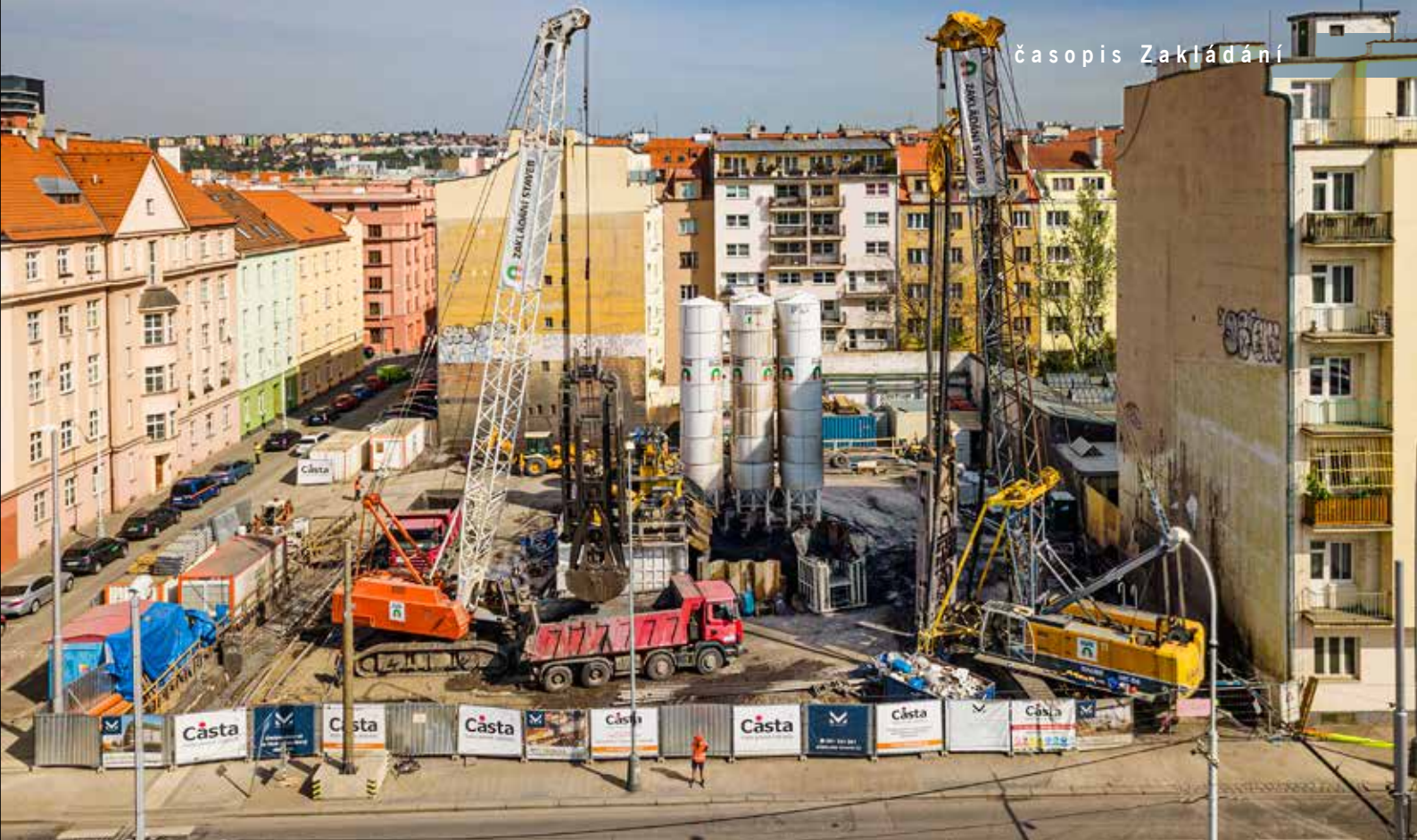
Provádění podzemních stěn, pásový nosič Liebherr HS 845 s drapákem Stein a hydrofréza BC 32 na nosiči Bauer MC 64
