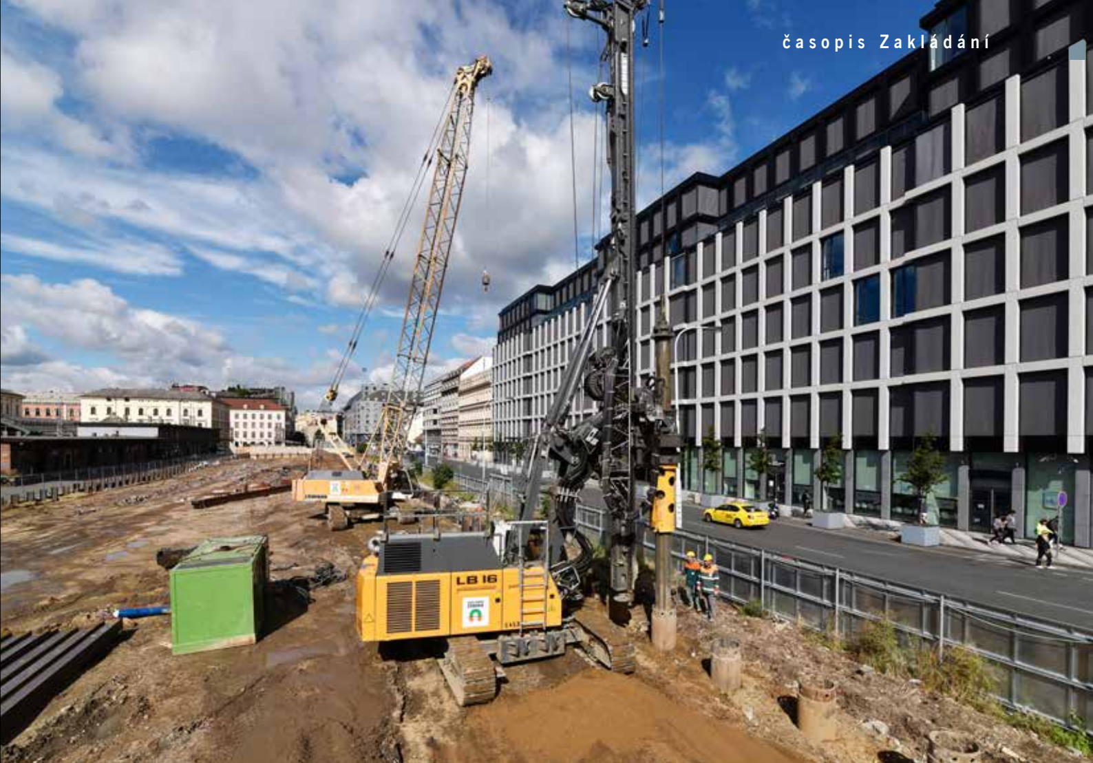
Provádění pažených předvrtů pro beraněné zápor
