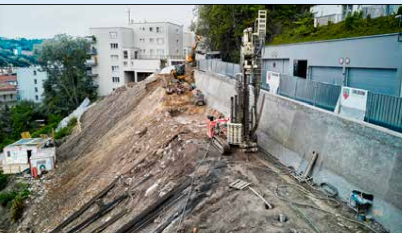
Instalace 1. stupně mikrozápor z pracovní úrovně pod zpevněnou kamennou zdí v Mošnové ulici
