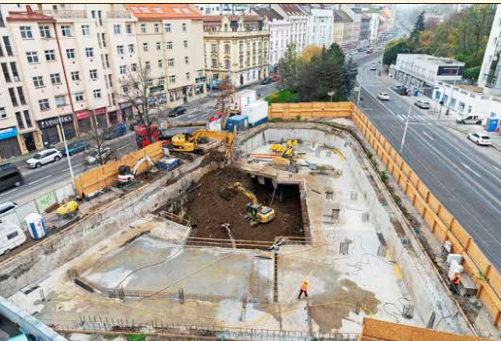
Výkop stavební jámy pod rozpěrnou deskou a navazující nakládka horniny
