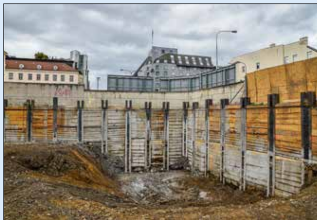
Dokončené záporové pažení v severozápadním rohu stavební jámy
