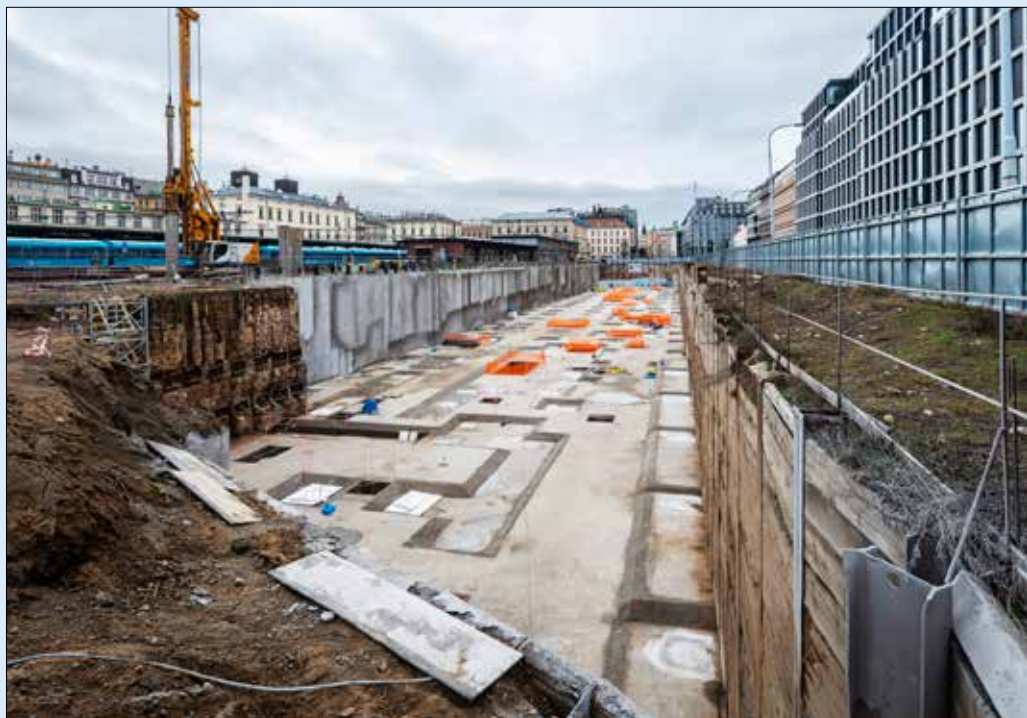
Pohled na dokončenou stavební jámu; pilotové zakládání věžových jeřábů
