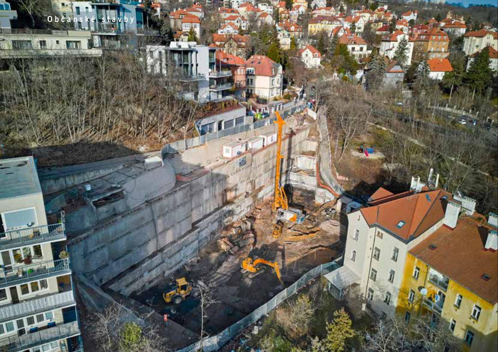
Celkový pohled na stavební jámu během provádění pilot z úrovně 5. PP
