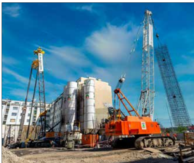
Osazování armokoše lamely podzemní stěny
