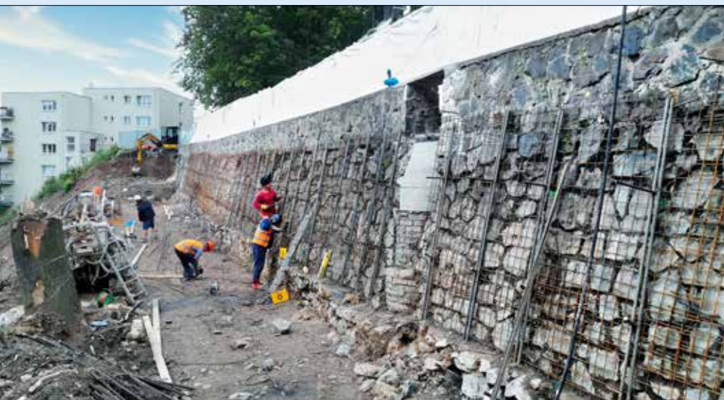
Zpevňování zdi pod Mošnovou ulicí
