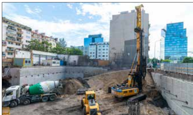
Provádění základových pilot v jihovýchodním rohu stavební jámy
