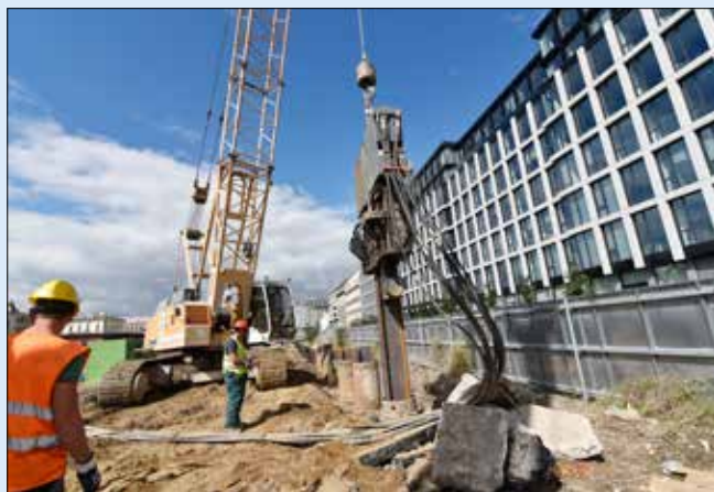
Beranění zápor do pažených předvrtů
