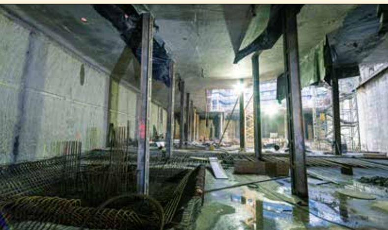
Provádění základové desky – vázání výztuže základové desky tl. 1200 mm v místě budoucích sloupů a dočasné ocelové podpěry. Vlevo ofrézované obvodové konstrukční podzemní stěny s vyfrézovanou drážkou pro strop nad 3. PP.
