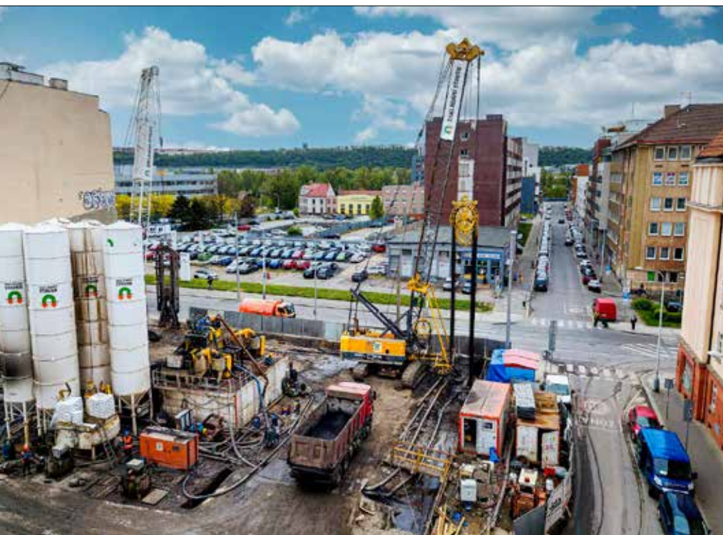
Těžba podzemních stěn a zařízení staveniště, pohled k jihu
