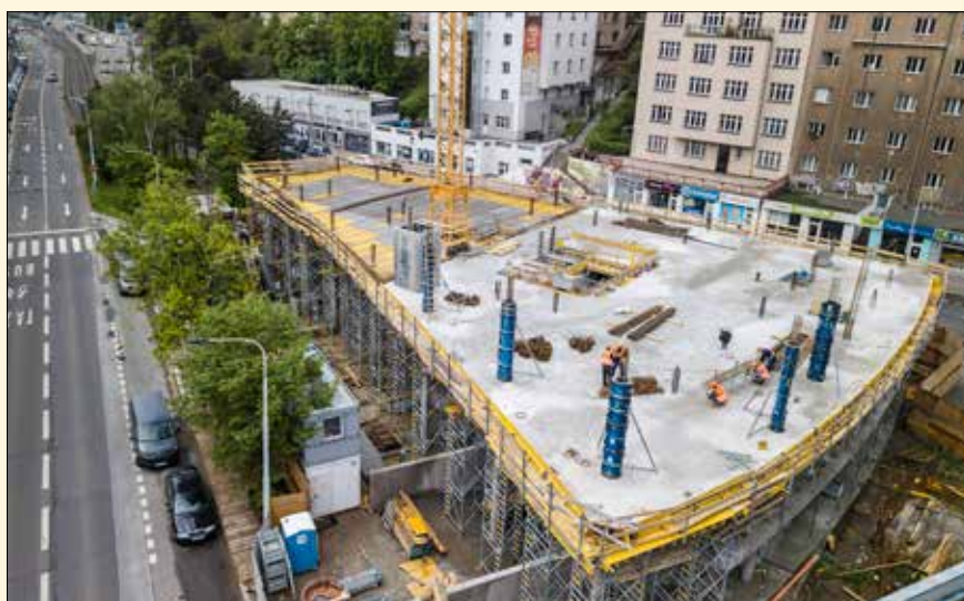
Pohled na stavbu od budovy České pošty západním směrem během realizace monolitických konstrukcí
