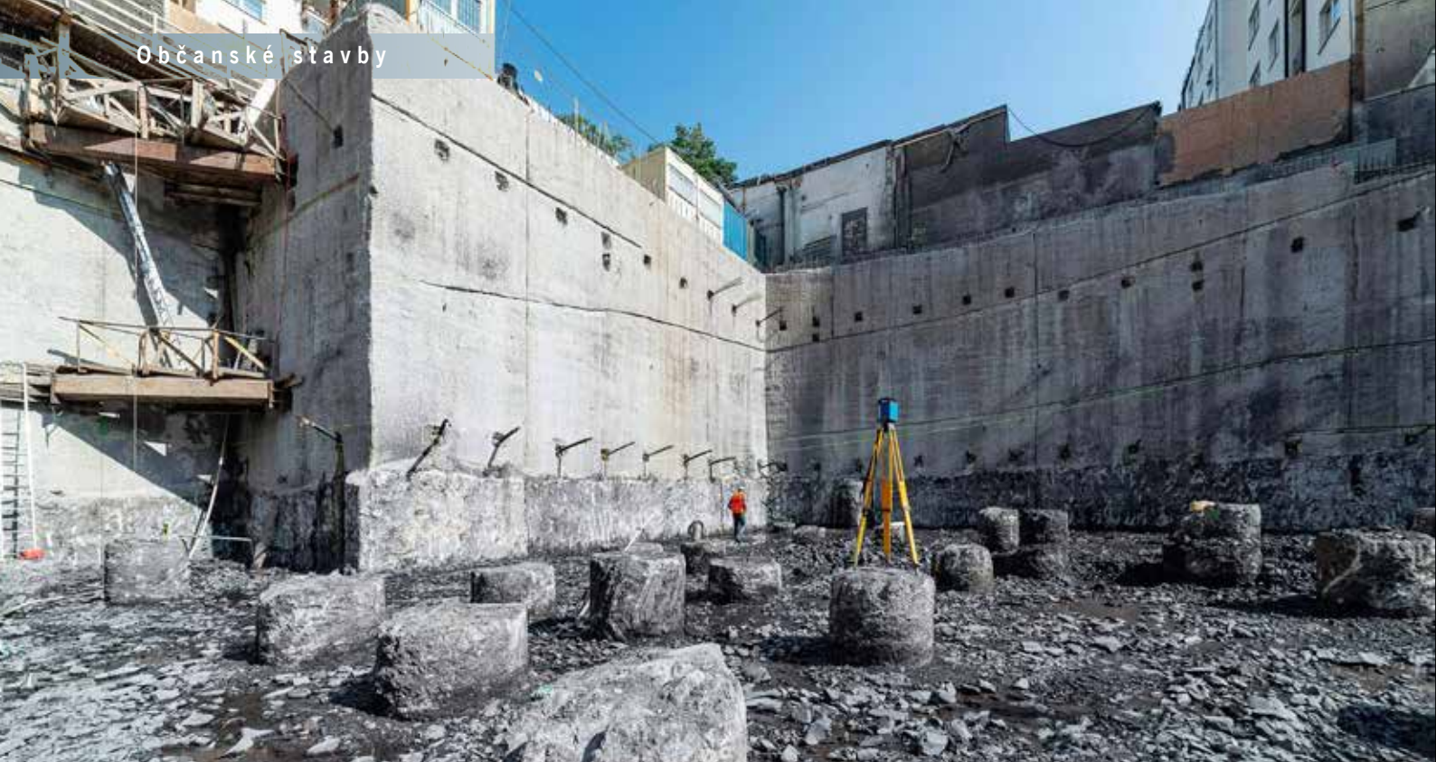
Výkop na definitivní úroveň s obnaženými hlavami základových pilot
