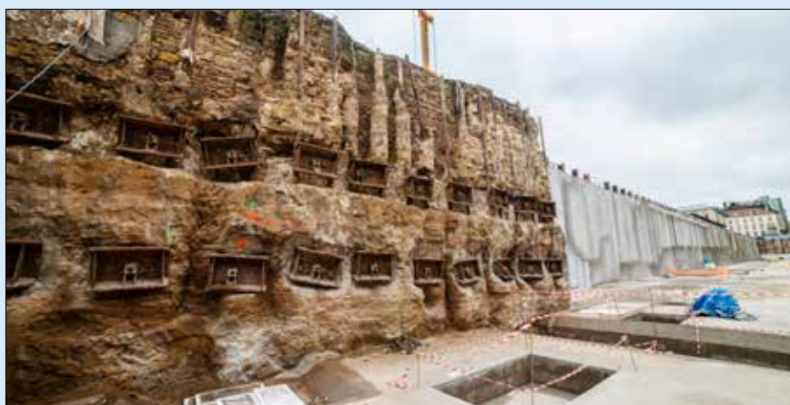
Pažení kotvenou stěnou ze sloupů tryskové injektáže s mikropilotou v místě původní hradební zdi na jihovýchodní straně stavební jámy
