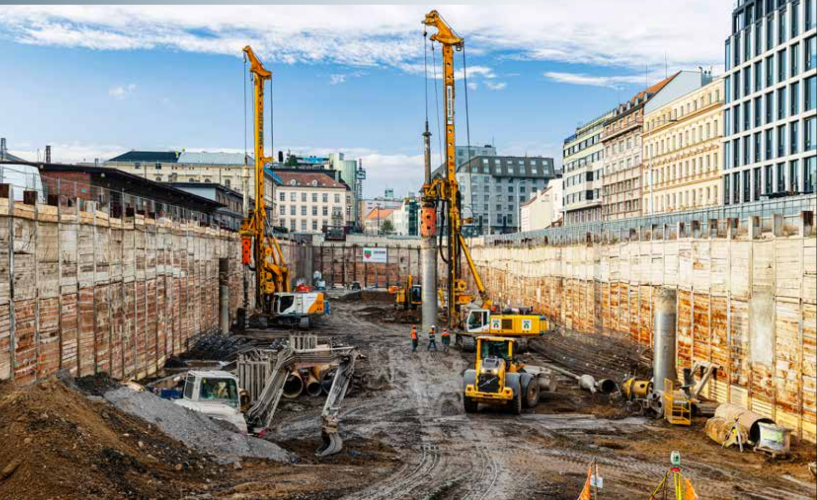
Provádění pilotového založení dvěma vrtnými soupravami
