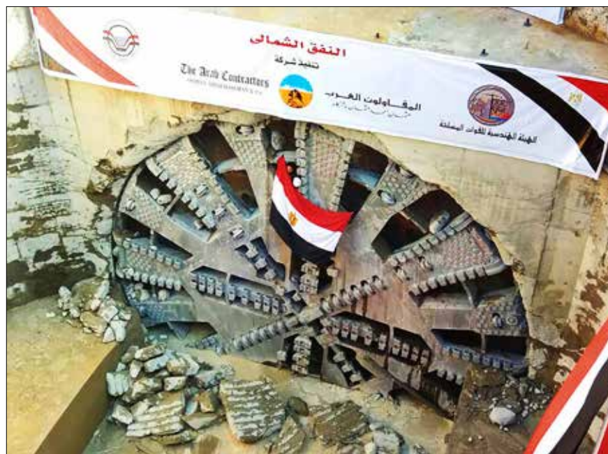
Slavnostní prorážka tunelu štítem TBM v ukončovací šachtě
