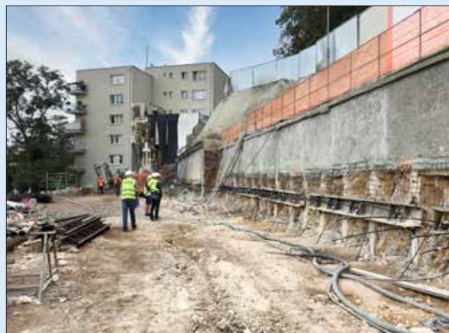
Instalace kotev na 2. kotevní úrovni
