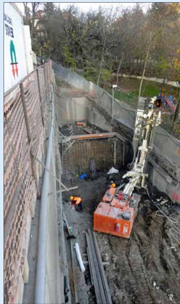
Instalace základových mikropilot ve východní části stavební jámy
