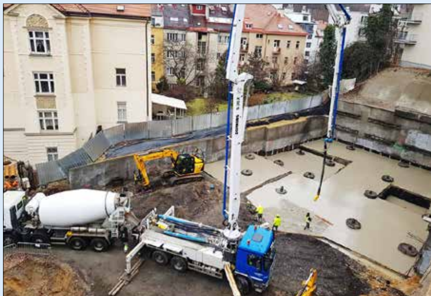
Betonáž základové desky
