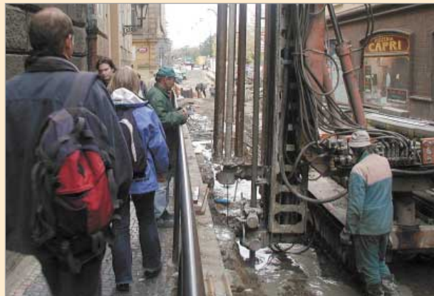
Vrtná souprava HBM 12 CB provádí injektážní vrtly v prostoru komunikace
