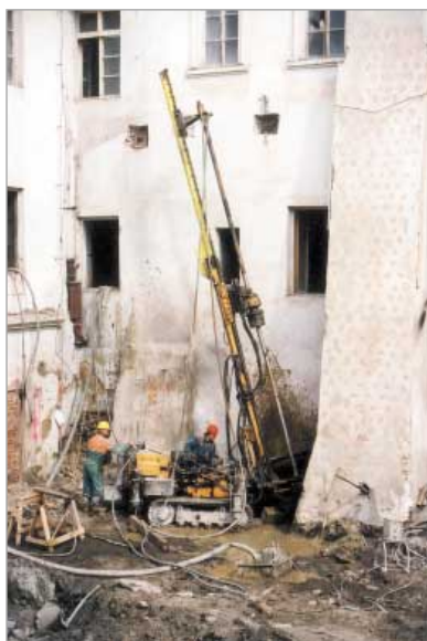
Vrtná souprava Hütte HBR 202 s prodlouženou lafetou při podchytávání základů jižního zahradního křídla tryskovou injektáží
