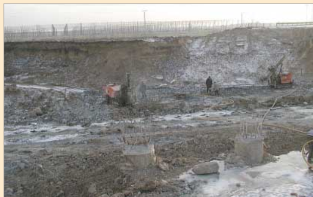
Vrtání mikropiloty a injektážních vrtů pro založení středního pilíře mostu na dálnici D8 (SO 201), v popředí piloty opěry
