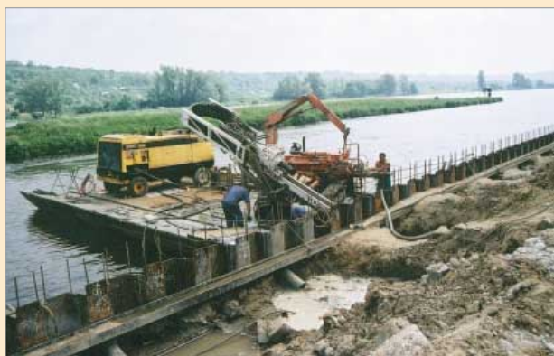
Celkový pohled na pracovní plošinu s vrtnou soupravou
