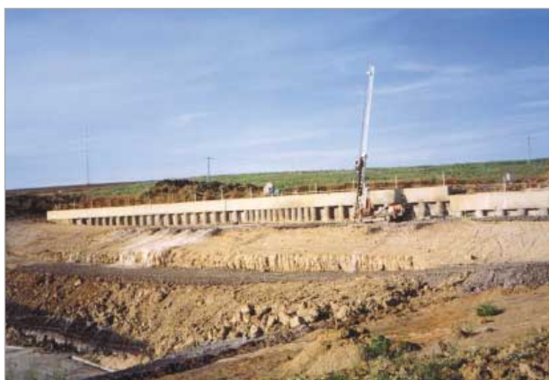
Obr. 3: Vrtná souprava Hausherr 12 CB při provádění plnicího vrtu před portálovou stěnou
