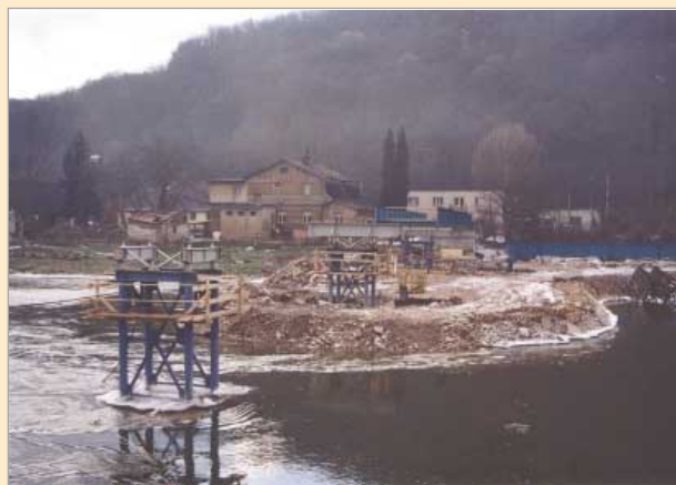
Založení lávky přes Berounku v Srbsku, provedená pilotáž I. etapy (dva pilíře)
