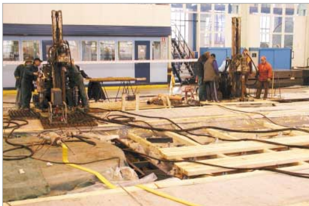
Obr. 5: Vrtací práce v železovém betonu základu prováděné pracovníky společnosti Zakládání staveb, a. s.
