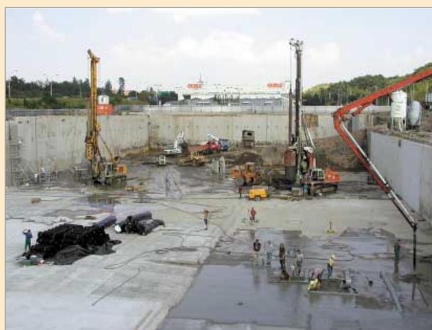
Stavební jáma před ukončením, pokládání izolací a vrtání posledních pilot
