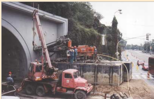
Vrtání kotvěv ze zvýšené pracovní plošiny vytvořené z panelů a pontonů, jižní portál Letenského tunelu
