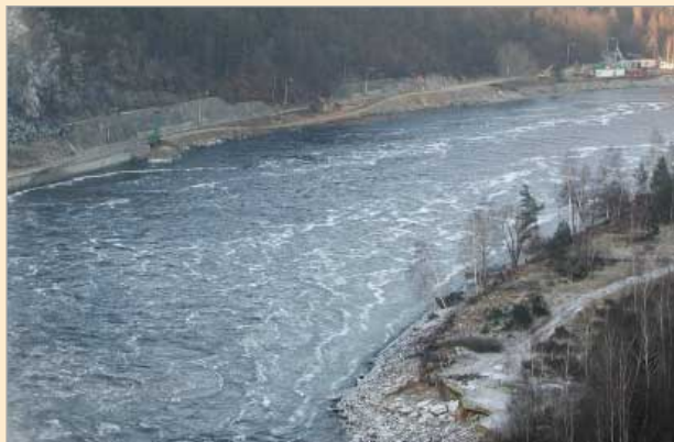
Pohled z přehradní hráze Orlík na poškozený levý břeh a komunikaci
