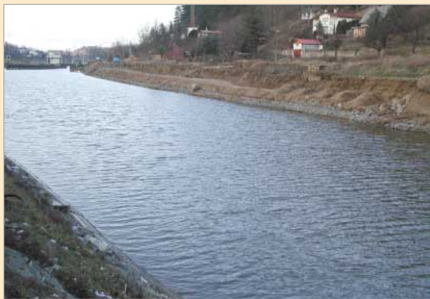
Pohled na pravý břeh kanálu po ukončení I. etapy prací – zaběhnutí štětovnic
