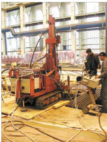
Obr. 6: Realizace pilíře tryskové injektáže prováděná pracovníky společnosti Soletanche ČR
