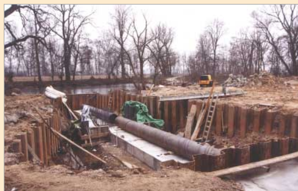
Výstavba propustku pod ochranou štětové jímky
