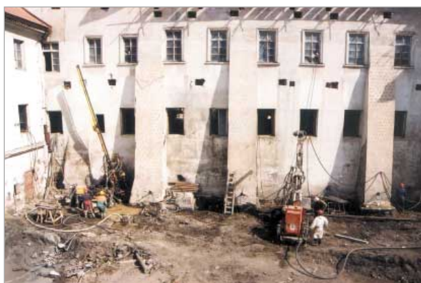
Současné provádění tryskové injektáže a vrtů pro mikrozáporové pažení stavební jámy garáží pod jižním zahradním křídlem
