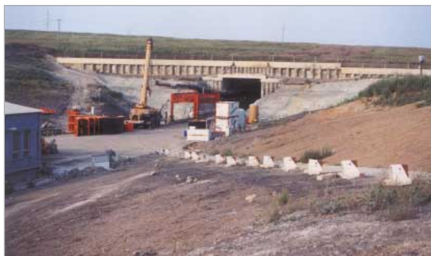
Obr. 7: Portál tunelu s dokončeným zářezem
