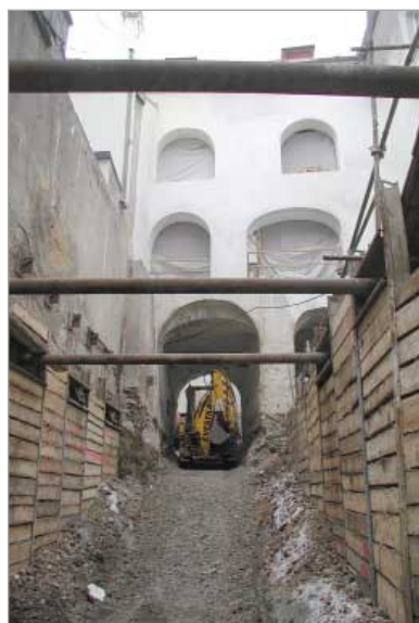
Mikrozáporové pažení sjízdné rampy, budoucí přístup do podzemních garáží z Nerudovy ulice
