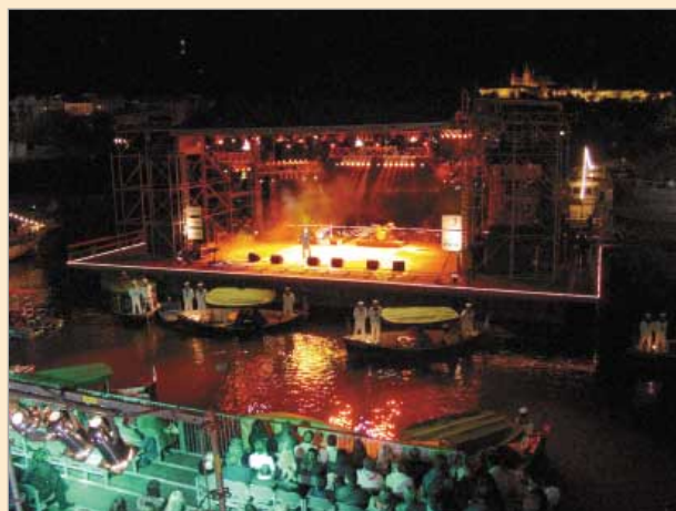
Koncertní scénu rozměrů 30 x 18 m neslo pontonové soulodí společnosti Zakládání staveb, a. s.
