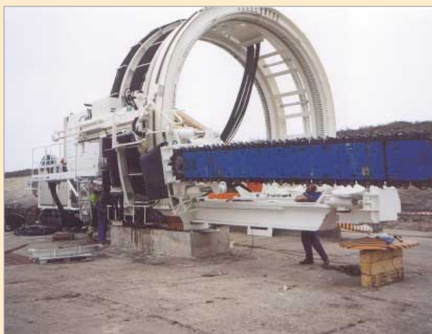
Obr. 1: Profilový řezací stroj Perforex 3713 před zahájením provádění předklenby č. 1 (10. 3. 2002)
