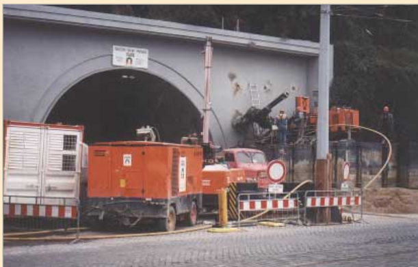
Pohled na stísněné staveniště před jižním portálem Letenského tunelu při nepřerušném tramvajovém provozu
