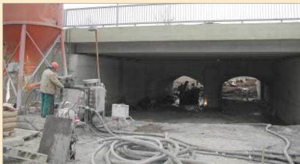
Provádění tryskové injektáže jednoho z pilířů inundačního mostu malou vrtnou soupravou
