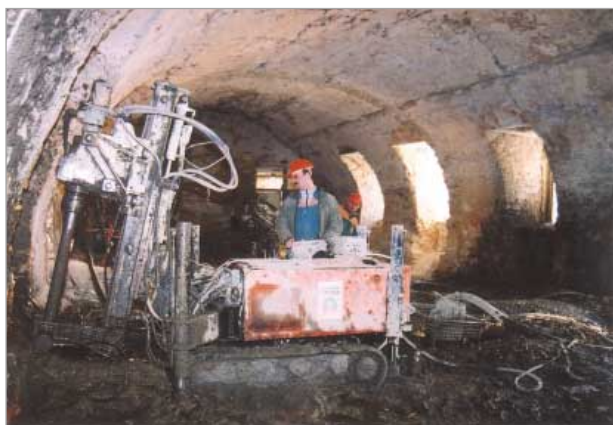
Provádění tryskové injektáže v objektu jižního zahradního křídla (bývalá konírna)
