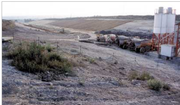
Obr. 6: Zářez železniční tratě před portálem v místech sanovaných důlních chodeb
