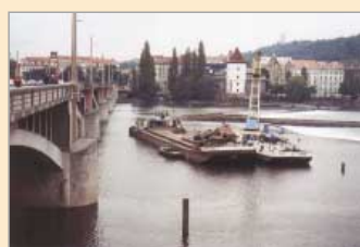
Beranění kotevních prvků do dna řečiště pro ukotvení celého soulodí nad Šitkovským jezem
