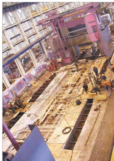
Obr. 8: Průběh sanací střední části základu
