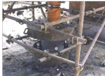
Obr. 3: Zatěžovací zkouška zkušebního pilíře TI
