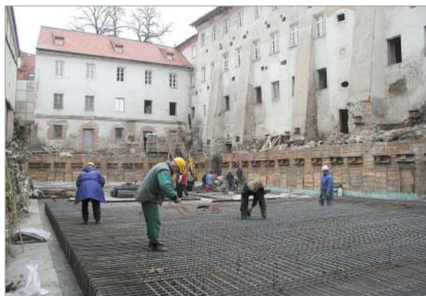
Provádění základové desky podzemních garáží v zapažené stavební jámě v místě zahrady, v pozadí západní a jižní zahradní křídlo (zleva)
