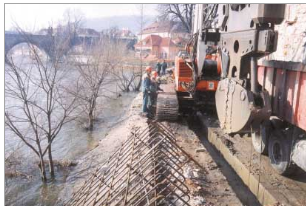
Těžba podzemní stěny soupravou Liebherr HS 843
