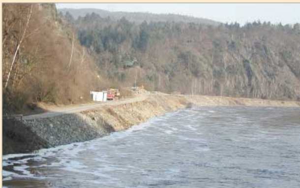
Celkový pohled na rekonstruovaný úsek vltavského břehu ve Štěchovicích
