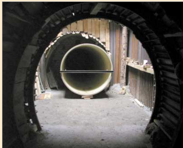
Přeložka Roztylského potoka byla provedena z části tunelováním, z části hloubením
