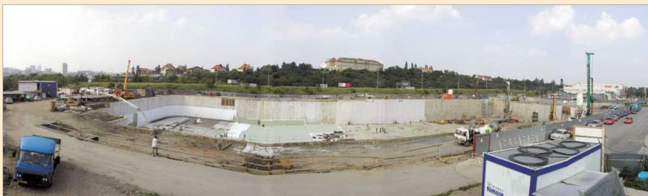
Panoramatický pohled na stavební jámu
