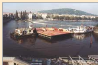
Postupné kotvení a vyvázání jednotlivých plavidel na zabírané kotevní prvky
