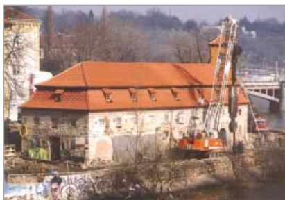
Těžba podzemní stěny v prostorově omezených podmínkách mezi starou nábrežní zdí a objektem Hergetovy cihlery
