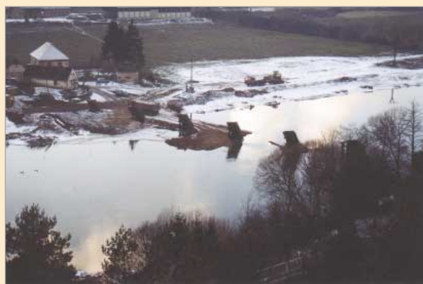
Založení lávky přes Berounku ve Stradonicích, nasypávání pracovní plošiny pro pilotáž opěr a pilířů
