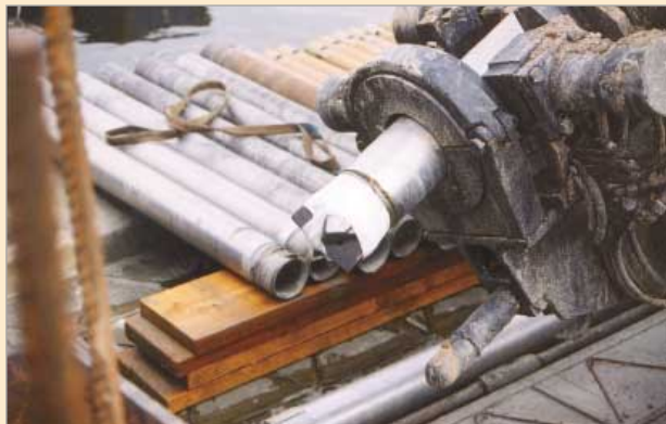
Pohled na úvodní pažnici osazenou „ztracenou“ křížovou korunkou
