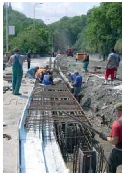
Výztuž převázky v hlavě pilot probíhala po dilatačních úsecích
