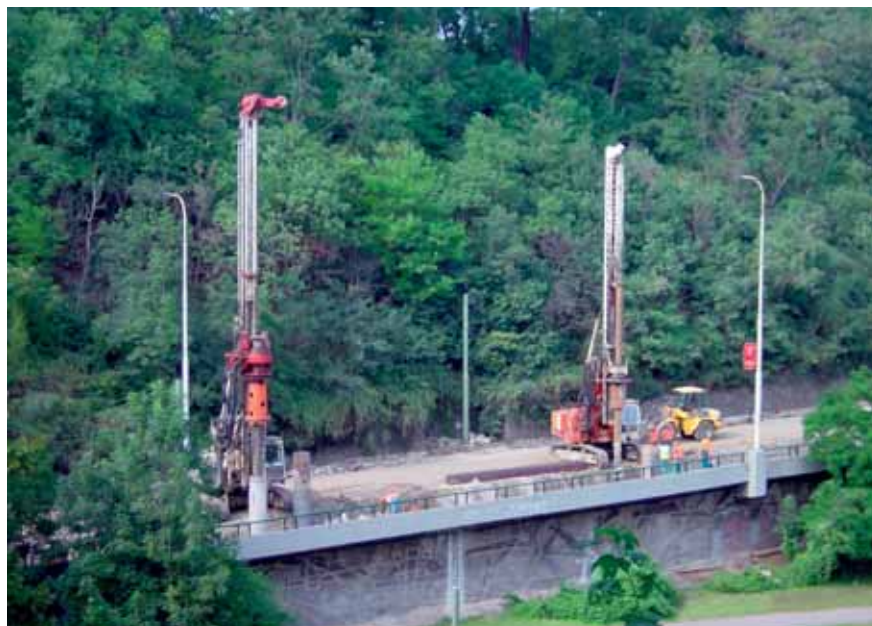
Rekonstrukce galerie Chotkovy ulice si při pracích ve výluce vyžádala nasazení maximálního množství strojních kapacit
