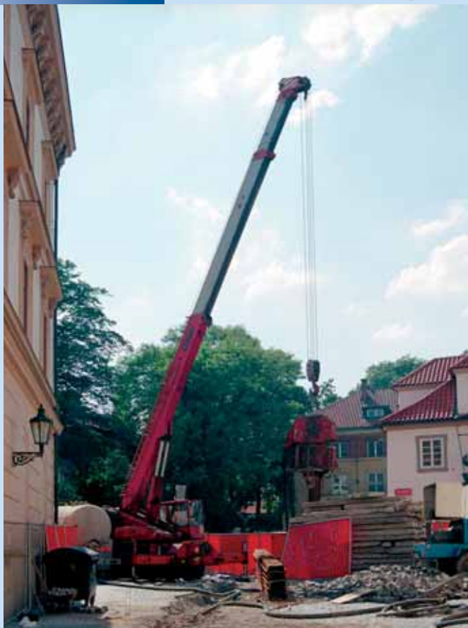
Obr. 6: Vibrování štětovnic pro výstavbu těsnicí stěny
