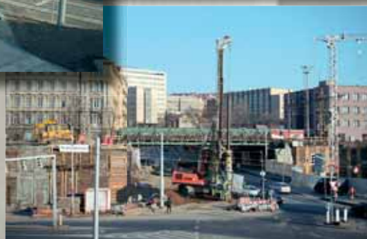
Modernizace železniční stanice Praha Hlavní nádraží – Mosty Seifertova ulice Pilotové založení opěr nového mostu, realizace: 2002
