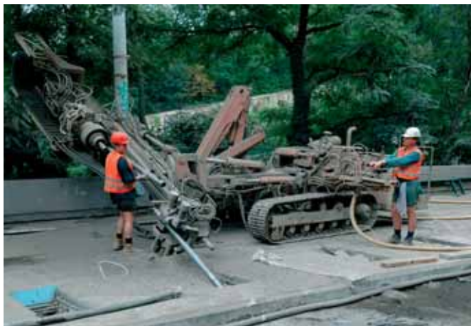
Hloubení vrtů pro trvalé pramencové kotvy vrtnou soupravou KLEMM KM 806 D
