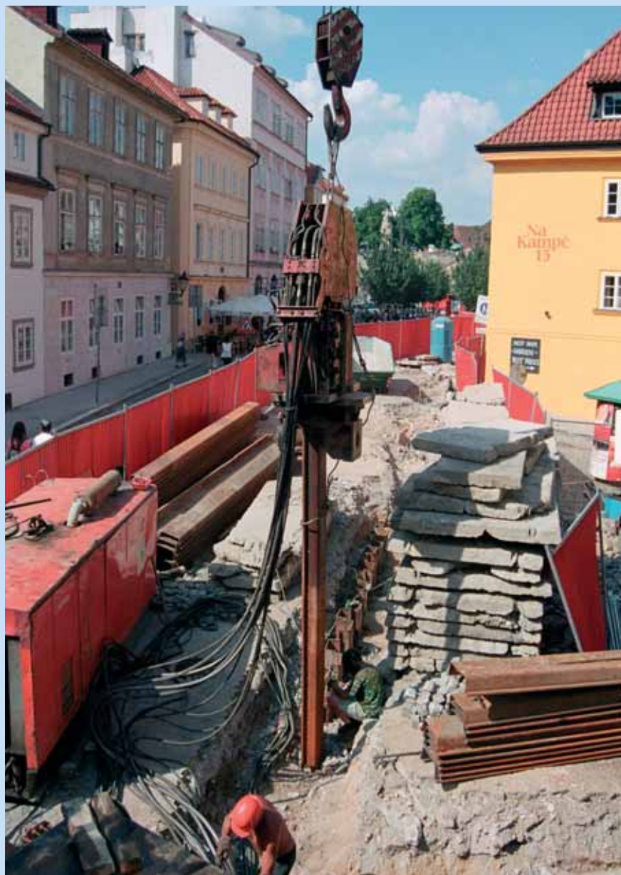
Obr. 5: Vibrování štětovic Larssen pro výstavbu těsnicí stěny na Kampě
