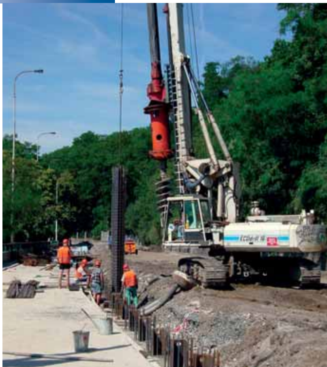
Osazování výztuže pilot – kombinace armokoše z betonářské výztuže a záporů z válcovaného profilu
