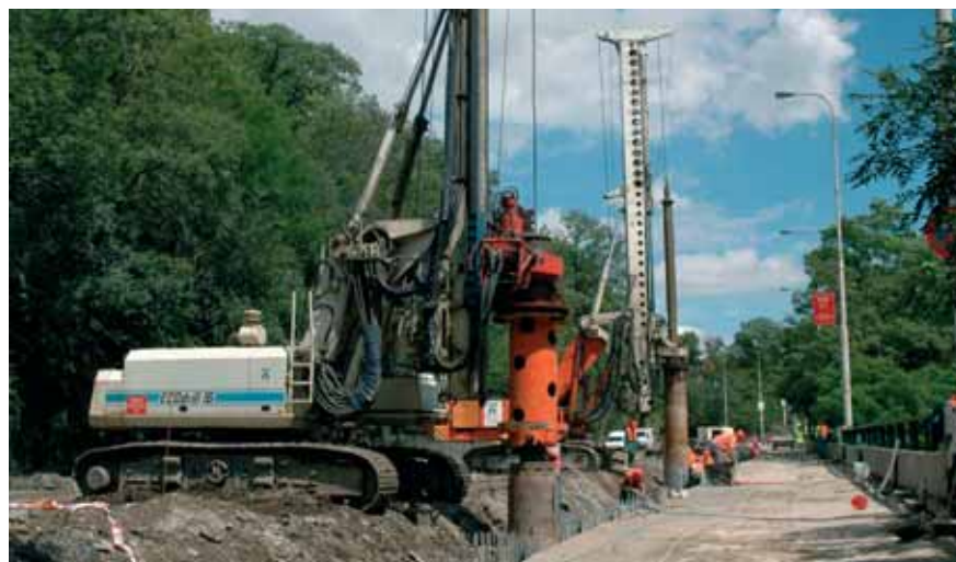
Vrtání pilot probíhalo ve svahových sutích a navážkách dvoupásovémi pažnicemi
