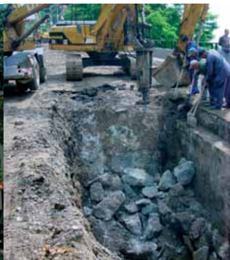
Bourání původních betonových konstrukcí v místě nové pilotové stěny
