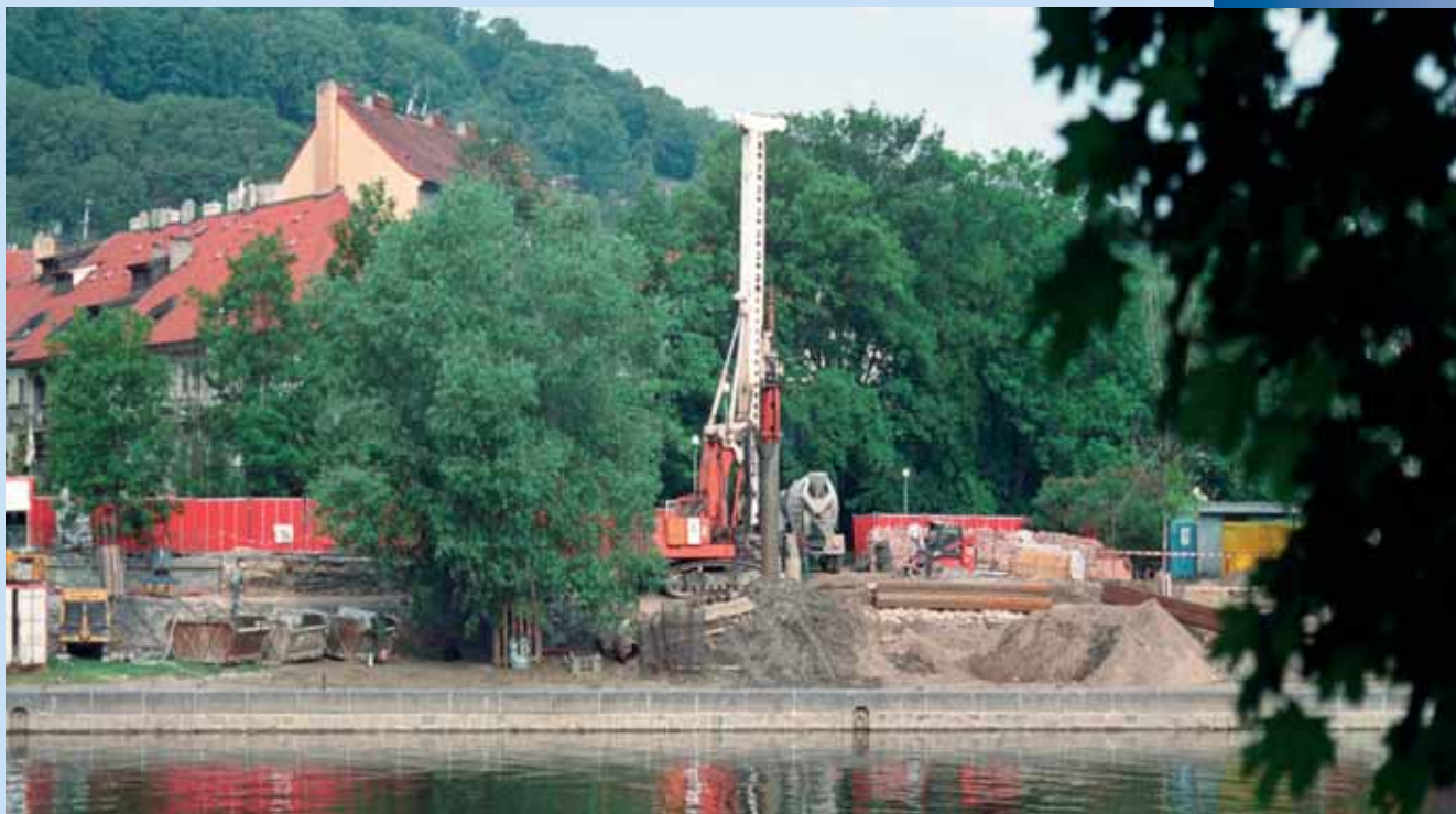
Obr. 8: Vrtná souprava Soilmec při provádění vrtaných pilot průměru 630 mm – nosných prvků těsnící stěny doplněné sloupy tryskové injektáže
