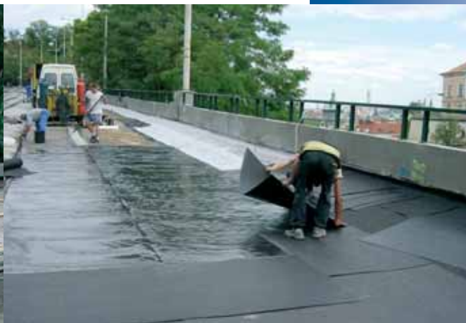
Provádění stěrkové hydroizolační membrány systémem Bakor
