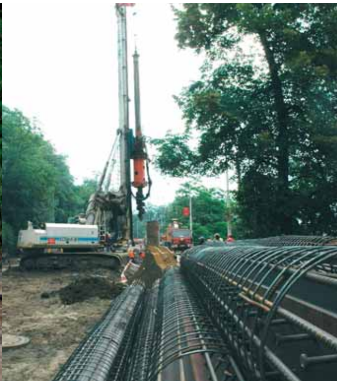
Pohled na poměrně složitou výztuž pilot. Prvky pro sřazení válcovaného profilu HEB 300 s betonem piloty.
