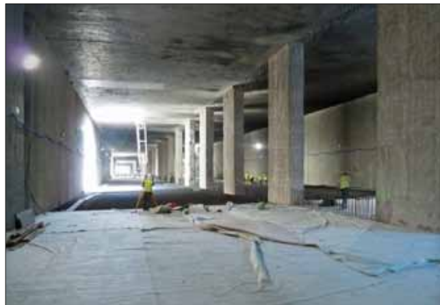
Pohled do hloubeného tunelu se střední řadou baretů
