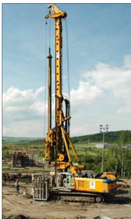
Obr. 12: Pilotovací souprava Bauer BG 25 s lafetou nesenou paralelogramem a s posuvnou vrtnou hlavou, zavrtávající výpažnici v roce 2003 (Zakládání staveb, a. s.)
