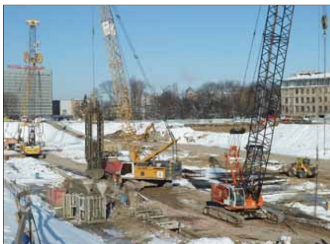
Výroba podzemních stěn pro objekt stanice (zima 2012/2013)
