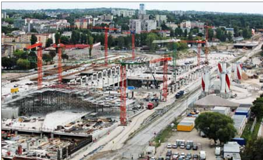
Letecký pohled na staveniště stanice s probíhající výstavbou nad stropní deskou
