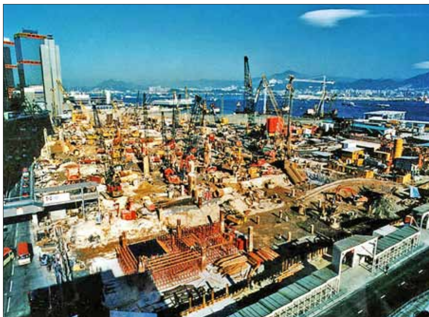
Obr. 1: Ukázka staveniště s velkým podílem pilotovacích souprav mezi mechanismy různých technologií, stanice metra Central Station Hongkong v roce 1996 (firma Soletanche)
