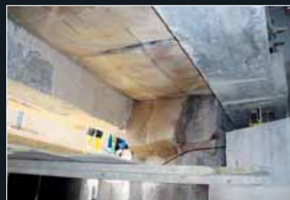
Klenební pásy pod zdí ND jsou vyřezány a vyjmuty až do úrovně stropu výlomu (11/2011)
