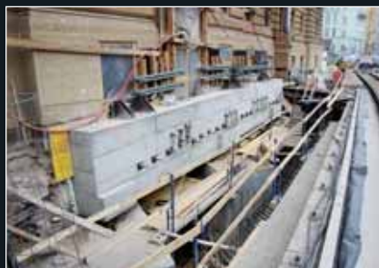
Vnější parapetní nosník dočasného podchycení po převzetí zatížení obvodovou zdí (11/2011)
