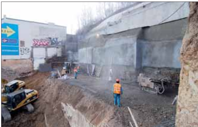
Práce na úrovni 6. NP
