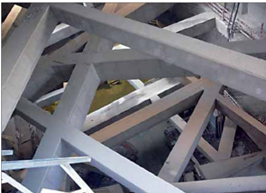
Složitý rozpěrný systém ze železobetonových trámů
