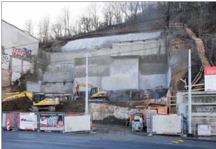
Pohled z ulice na zajištěný skalní odřez, výkop je na úrovni 3. NP.
