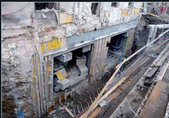
Pohled na novou konstrukci podchycení obvodové zdi z hrany 1. etapy tunelu 2 + 3, dočasné konstrukce jsou již odstraněny (1/2012)
