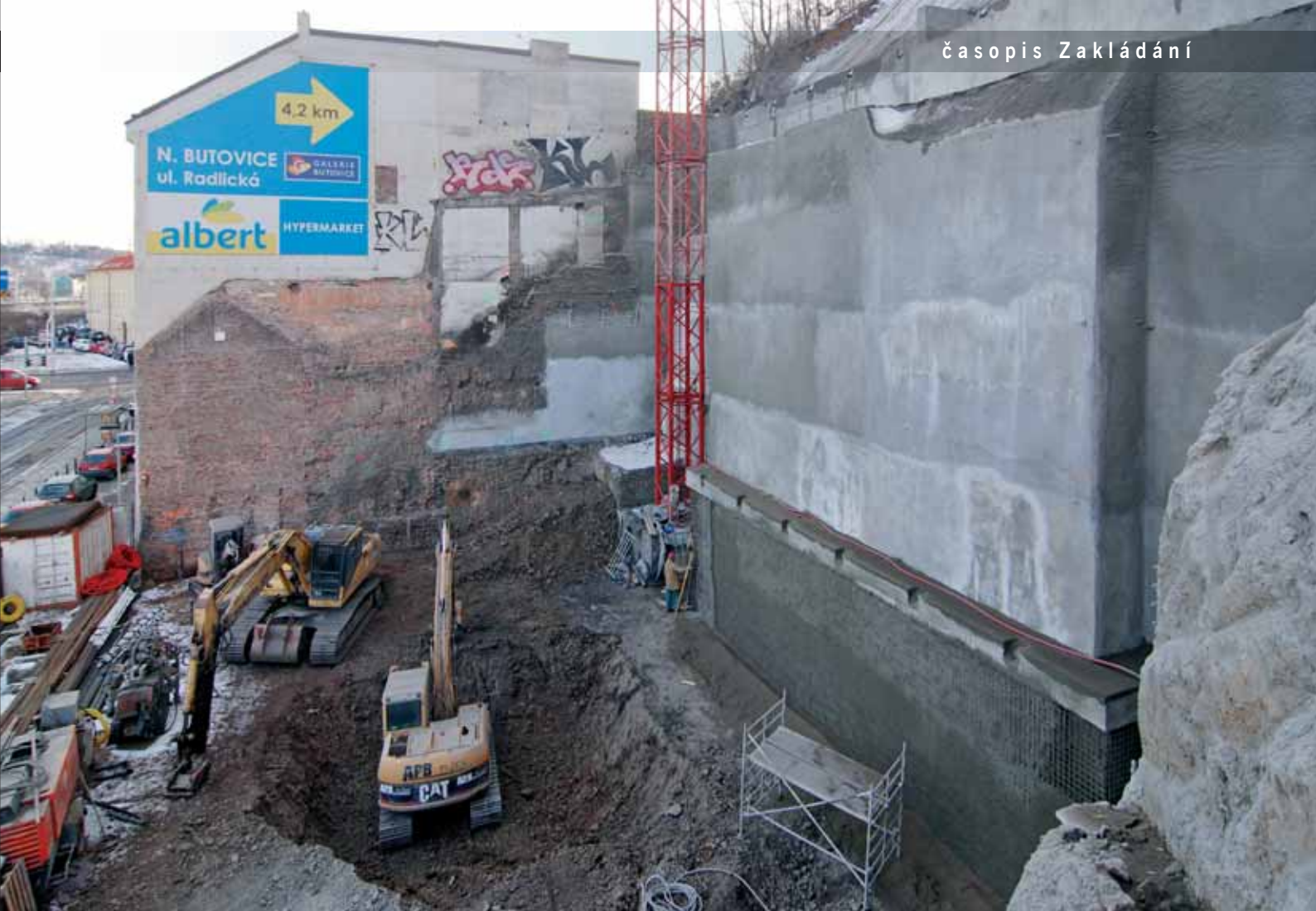
Stavební jáma pod zajištěným vysokým skalním odřezem, stavební práce jsou na úrovni 1. NP, jeřáb je založen v terasovitém výklenku.
