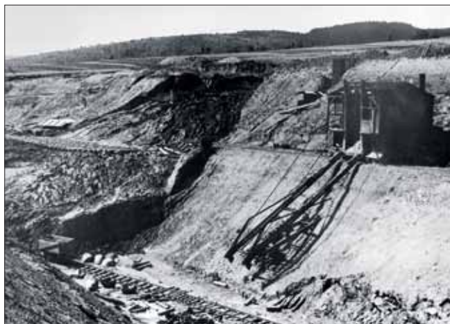
Těžká rypadla byla někdy příčinou sesuvu svahů. Společnost Lanna už svůj stroj na stavbě dráhy Vsetín–Bylnice po ujetí svahu začala rozebírat, i když tentokrát měl štěstí a stál stranou sesuvu.
