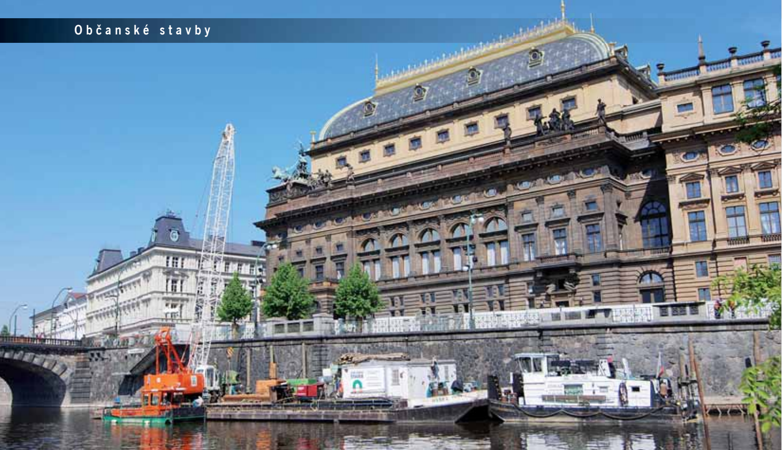
Beranění dočasných kotevních prvků pro nákladní lodě (4/2011)
