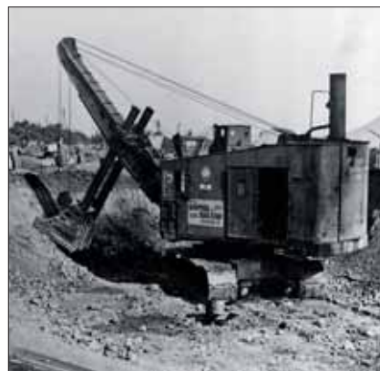
Rypadlo firmy Raynal a Balzar odstraňovalo zeminu na stavbě nového seřadovacího nádraží dolů v Kopistech u Mostu
