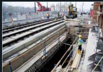
Na hotové 1. etapě tunelu 2 + 3 je dokončována tramvajová trať (11/2011)
