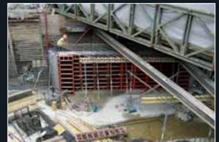
Výstavba 1. etapy nosné konstrukce tunelu 2 + 3 pod mostním provizoriem (9/2011)
