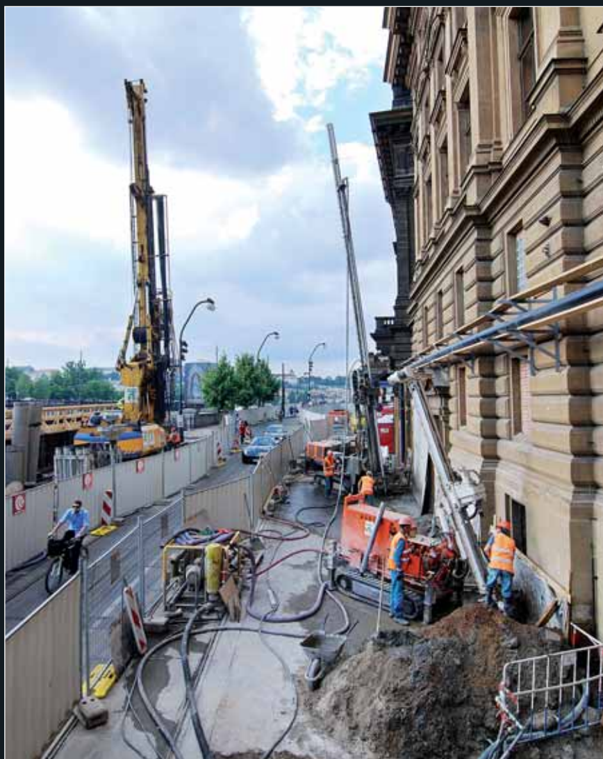
Provádění vějířovitých vrtů tryskové injektáže podchycení obvodové zdi divadla, pilotážní souprava vlevo zřizuje vrt pro zápor pažení (6/2011)
