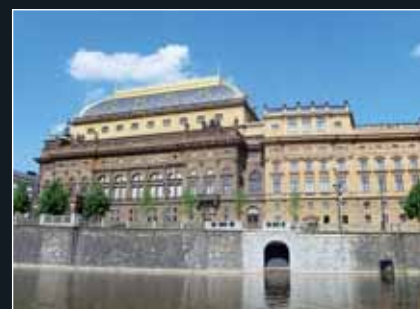
Pohled z Vltavy na klenutý portál vestavěný do nábrežní zdi (5/2012)
