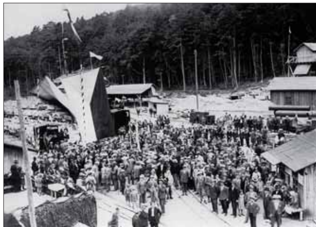
Proražení tří kilometrů dlouhého bralského tunelu na dráze Handlová–Horní Štubňa v roce prezidentových osmdesátin využili buildovatelé dráhy a pojmenovali tunel po T. G. Masarykovi. Slavnostní akt na staveništi proběhl bez účasti prezidenta 13. 7. 1930.
