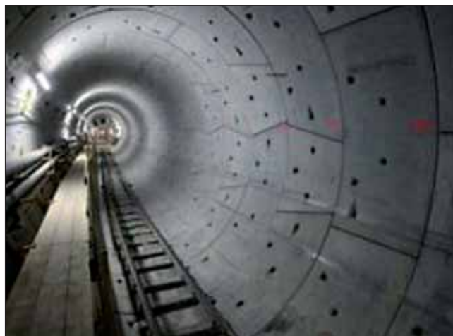
Traťový tunel linky metra M4
