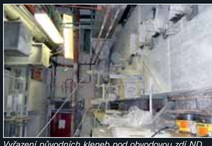
Vyřazení původních kleneb pod obvodovou zdí ND z nosné funkce, smyčkový řez „diamantovým lanem“ (11/2011)
