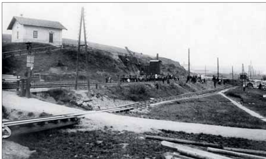
Firma Kress prováděla v České Třebové nejen bagrování pro druhou kolej ve směru k Olomouci, ale i celkové rozsáhlé úpravy stanice.
