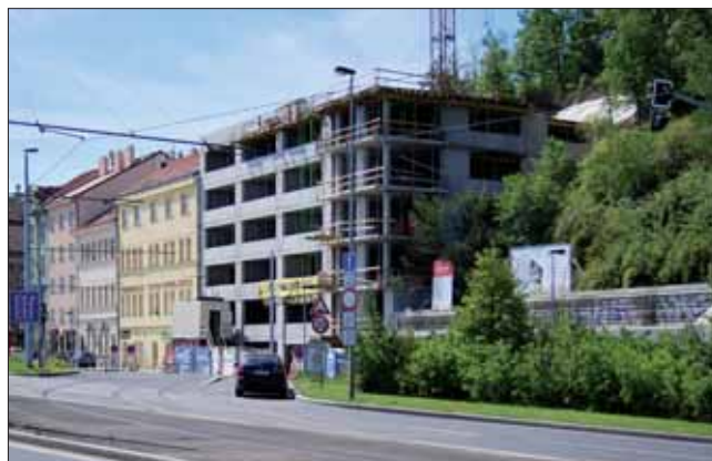
Nově vznikající objekt na úrovni 6. NP
