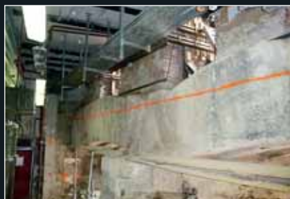
Pískovcové klenby pod obvodovou zdí ND, pohled z budovy, oranžová linie značí vrchol výlomu (7/2011)
