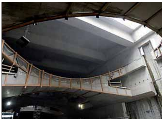
Složitý rozpěrný systém ze železobetonových trámů
