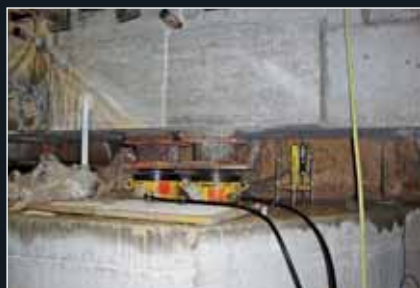
Aktivace parapetních nosníků hydraulickými lisy, vpravo inkrementální čidlo deformací (11/2011)
