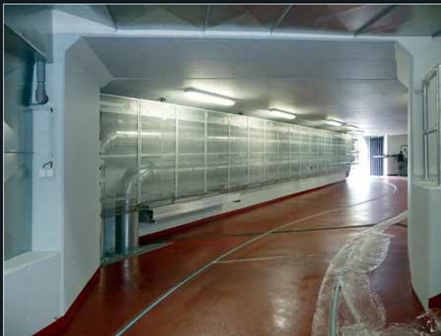
Pohled do dokončeného tunelu 2 + 3 a na kolejovou dráhu z navazujícího suterénu budovy divadla (5/2012)
