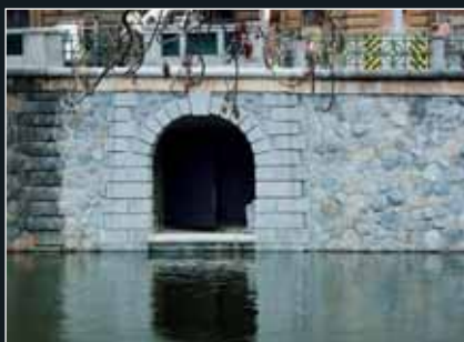
Historizující žulový portál v nábrežní zdi s protipovodňovými vraty před dokončením (1/2012)
