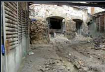
Stavební jáma tunelu 2 + 3, opěry původních tunelů před budovou ND byly záměrně ponechány (6/2011)
