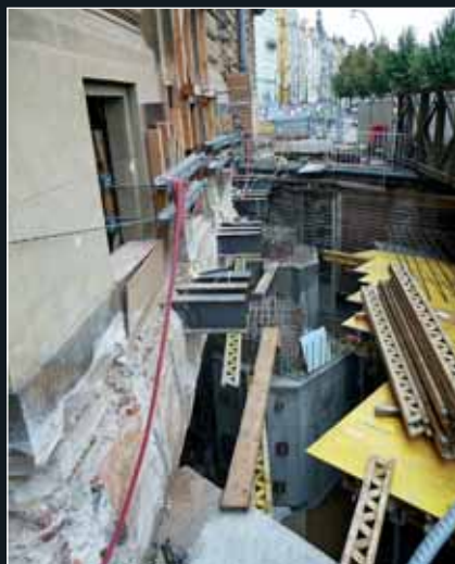
Příčnice jsou hotové, skořepiny na opěrách jsou sepnuty, dokončuje se výztuž úložných prahů (9/2011)
