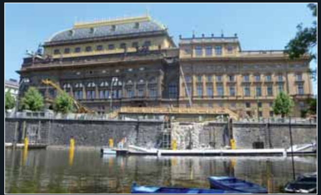
Rozebírání kamenného líce nábrežní zdi a realizace manipulačního prostupu dřikem z plovoucího prostředku (6/2011)
