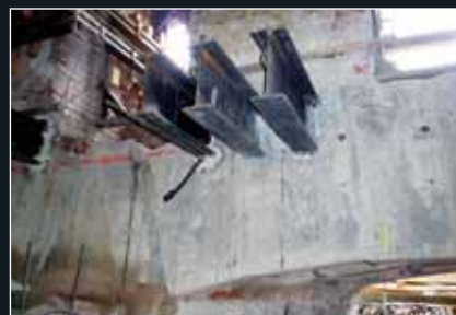
Ocelové příčnice zainjektované do vrtů pod meziokenními pilířem obvodové zdi (9/2011)
