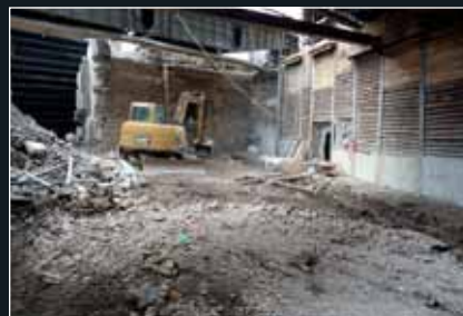
Vyrovnávání základové spáry tunelu 2 + 3 za rubem nábrežní zdi, manipulační vstup je uzavřen hradidly (7/2011)
