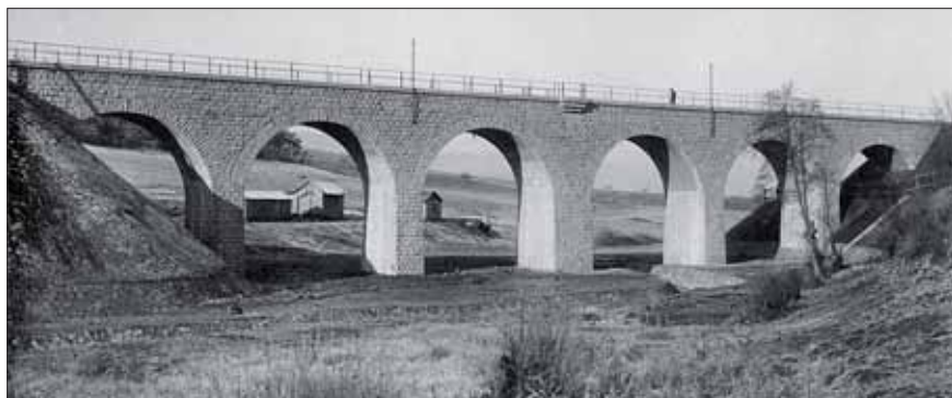
Viadukt „Na Barinách“ na dráze Zvolen–Krupina, který stavěla firma Hollmann-Babuška, má při délce 120 metrů 6 betonových oblouků obezděných kamenem.
