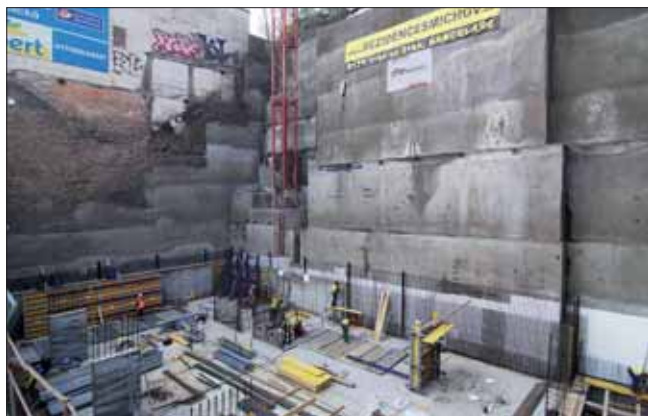
Zahájení prací na vestavbě
