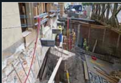
Zesilování původních opěr tunelů sepnutými skořepinami, osazování prvních příčnic do kleneb (8/2011)
