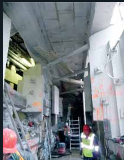
Dokončený výlom velikosti 12x5,5x2 m pod obvodovou zdí ND (12/2011)
