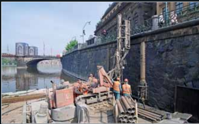
Provádění mikropilotového založení prahu 1. linie protipovodňové ochrany stavby z plovoucího prostředku (4/2011)
