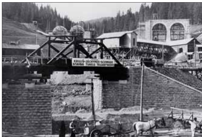
„Inžinieri Kruliš, Jáchymek, Schwarz“, jak stojí na tabuli, stavěli nejen telgártský tunel, ale i viadukt se středním železobetonovým polem dlouhým 32 m. V popředí na první fotografii je místo ocelové konstrukce mostu jen dřevěné provizorium pro pracovní drážku. Na obrázku hotového díla vidíme i spodní vjezd do 1240 m dlouhého spirálového tunelu, pojmenovaného po senátorovi a signatáři Martinské deklarace Kornelu Stodolovi.
