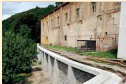
Provádění nové žlby římsy nad sanovanou zdí
