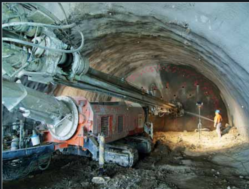
Zajišťování čelby pomocí „zámkových“ sloupů TI a laminátových kotv
