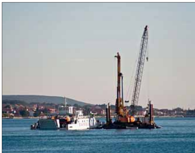
Obslužný trajekt „Otocí“ s naloženými domíchávací připlouvá k pontonu
