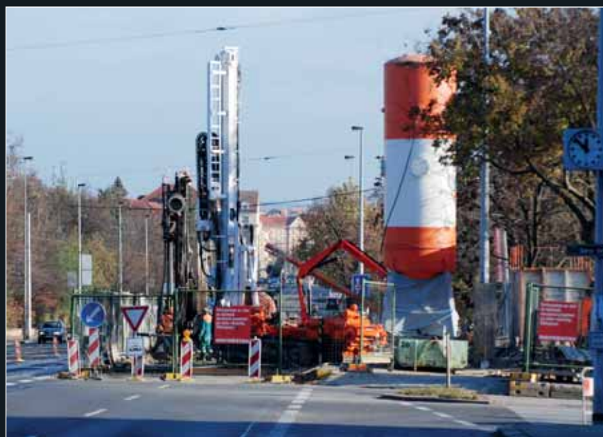
Provádění svislé těsnicí stěny z tryskové injektáže z prostoru vozovky Evropské ul. (1. etapa záboru)
