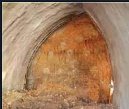
Detailní pohled na čelbu v levé části kaloty stabilizovanou pomocí „zámkových“ vrtů TI a laminátových kotv
