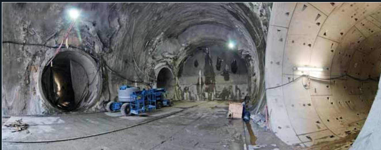
Vyražený spojovací tunel s viditelným zaústěním traťových tunelů po průjezdu obou razících štítů Tonda a Adéla
