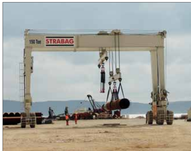
Portálový jeřáb při nakládání výpažnice
