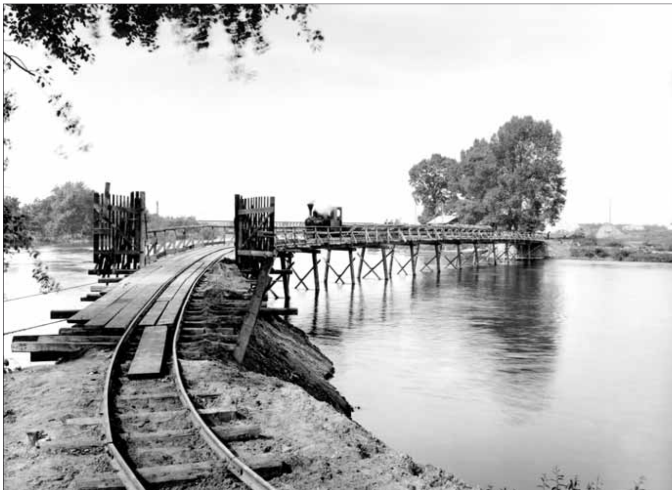
Provizorní dřevěné mosty byly běžnou součástí stavebních drážek, především na vodních stavbách. Firma Hlava-Kratochvíl si jeden takový postavila v roce 1929 přes Labe u Lobkovic.
