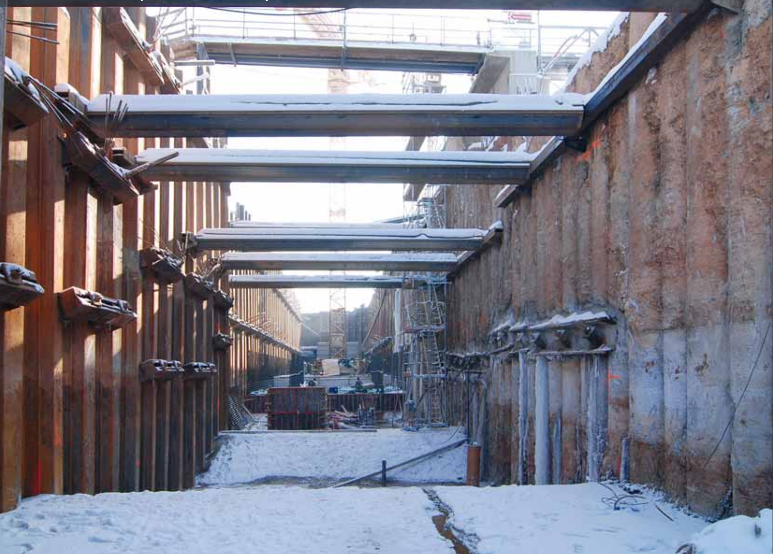
Rozepření stavební jámy pro plavební komoru v místě jezového pilíře
