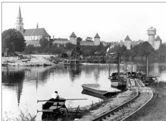
Fotografie pod nymburskými hradbami ze září 1919 dobře ukazuje nájezd na loď pro přepravu vozíků po vodě včetně sklopné nájezdové rampy, vyrovnávající kolísání vodní hladiny. Úpravu Labe prováděla firma A. Lanna.
