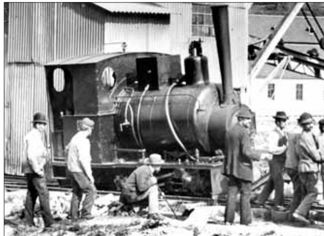
Použitou tunelovou lokomotivu si koupila firma A. Lanna na počátku 90. let 19. století. V pražské Libni se ji právě dělníci pokoušejí dostat na koleje, přičemž je dobře vidět zvětšená nádoba kotle. Později byl kotel vyměněn za nový obvyklé konstrukce.
