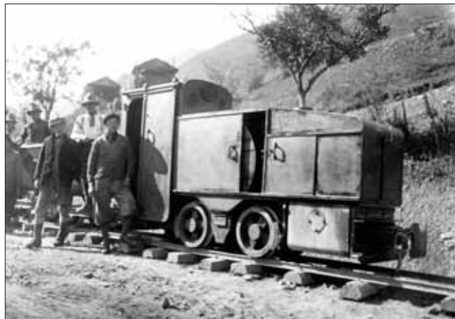
Jednu z nejstarších motorových lokomotiv na našich stavbách vlastnila firma A. Lanna. V roce 1917 ji vyrobila firma Deutz na rozchod 600 mm a výkon jejího benzinového motoru byl asi 25 koní. Fotografie je ze stavby kanálu elektrárny Nevická na Podkarpatské Rusi.
