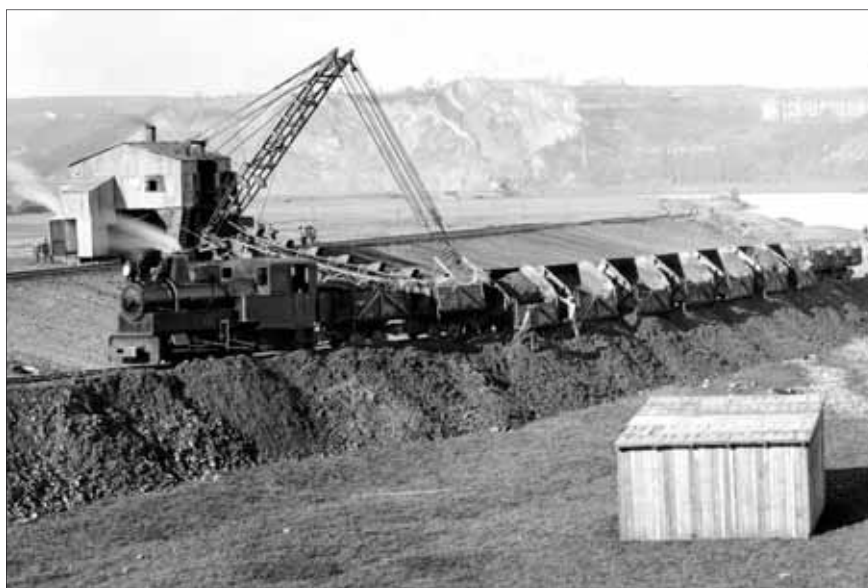
Jedny z největších stavebních lokomotiv své doby přivezla brněnská firma Bratři Redlichové na velkou úpravu Vltavy na pražských Manínách roku 1923. Stroje, vyrobené firmou Krauss v Linci o čtyři roky dříve, jezdily na rozchodu 900 mm a měly výkon 175–200 koní.
