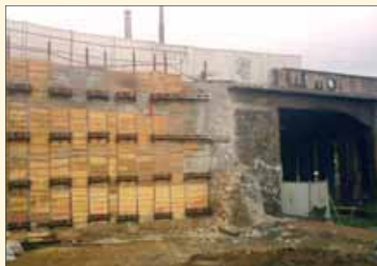
OP1 – východ: Pohled na mikrozáporovou stěnu, provedeny 4 kotevní úrovně z 5, v levé části je vidět prorážka kanalizační štol, 1. etapa
