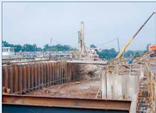
Provádění tryskové injektáže u jezového pilíře
