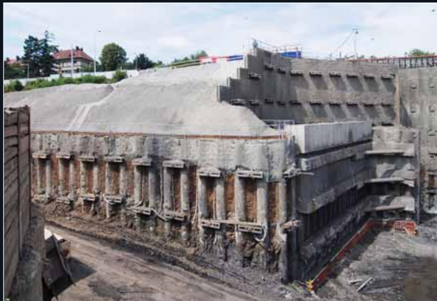
Pohled na západní stěnu stavební jámy přiléhající ke sjezdové rampě, pažení je zde vytvořeno ve dvou výškových úrovních v kombinaci pilot a zápor s vynášecím žlb. nosníkem.
