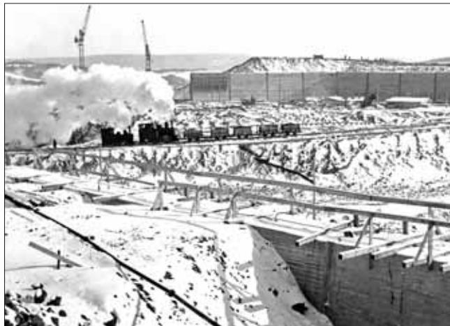
K vyvážení výkopu z hlubokých stavebních jam bylo občas zapotřebí spojit síly dvou nebo tří lokomotiv. Fotografie L. Votruby byla pořízena v únoru 1944 v budoucím bazénu přečerpací elektrárny na Homoli u Štětovic.
