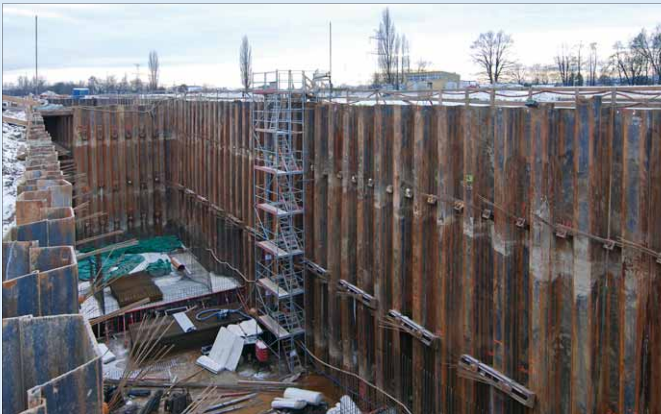
Pohled na štětovou stěnu jímky kotvenou až ve třech úrovních pramencovými kotvami
