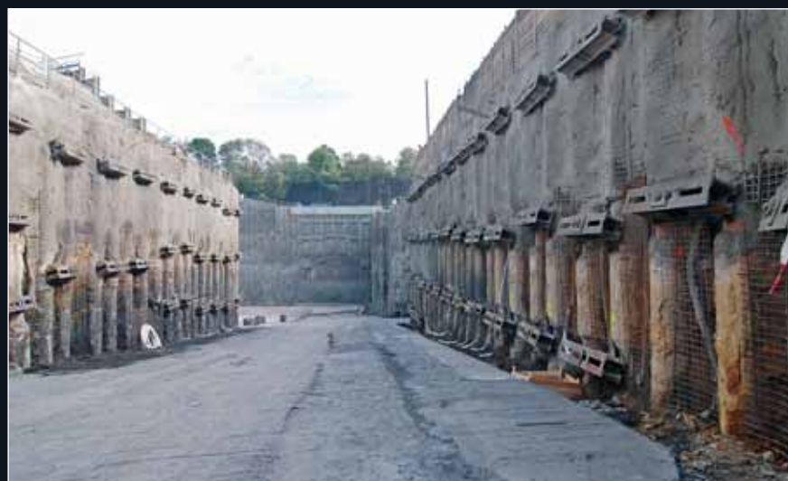
Sjízdňá rampa zajištěná ve své spodní části po obou stranách také kotvenými pilotovými stěnami a stříkaným betonem s výztužnou sítí
