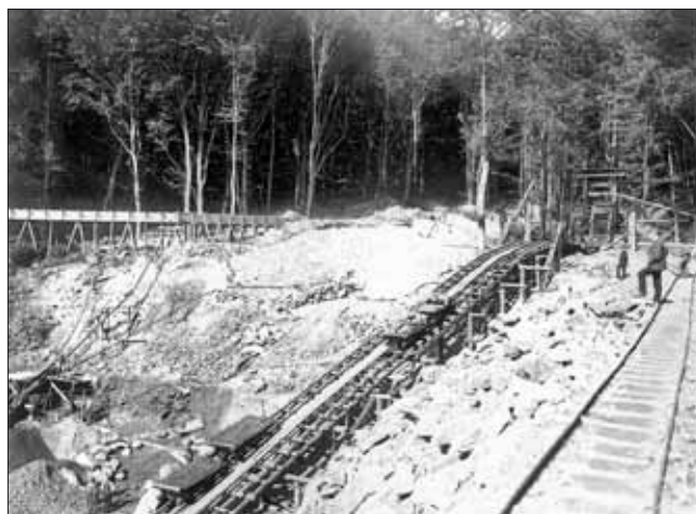
Kolejovou dopravu na laně předvádí obrázek ze stavby krušnohorské přehrady Jezeří firmou H. Rella v letech 1902–1904. Na dvoukolejné svážnici se gravitací spouštěl kámen z lomu.
