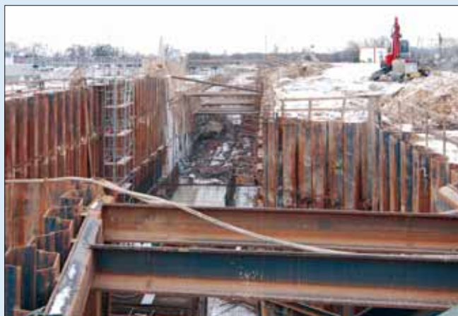
Zahájení betonáže základové desky plavební komory
