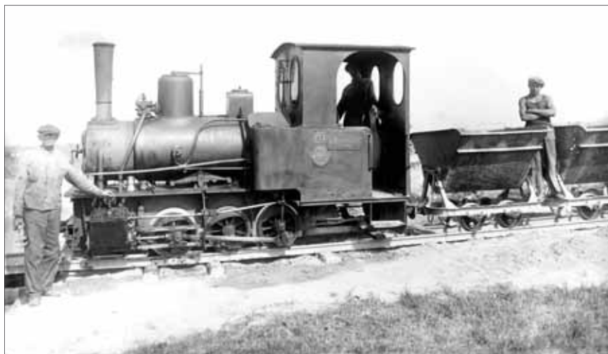
Třínápravová lokomotiva PIA z roku 1903 od výrobce Orenstein & Koppel s výkonem 30 koní patřila původně uhelné dráze o rozchodu 600 mm u Chomutova. Ve 20. letech minulého stol. ji koupila stavební firma Nejedlý, Řehák a spol. a používala například v roce 1931 při regulaci Lužnice u Veselí. Dobře je vidět jednoduchý pákový mechanismus rozvodu páry podle patentu O&K.
