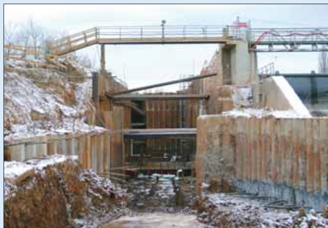
Pohled do stavební jámy plavební komory, vpravo je zahájeno kotvení převrtávané pilotové stěny dolního plavebního kanálu
