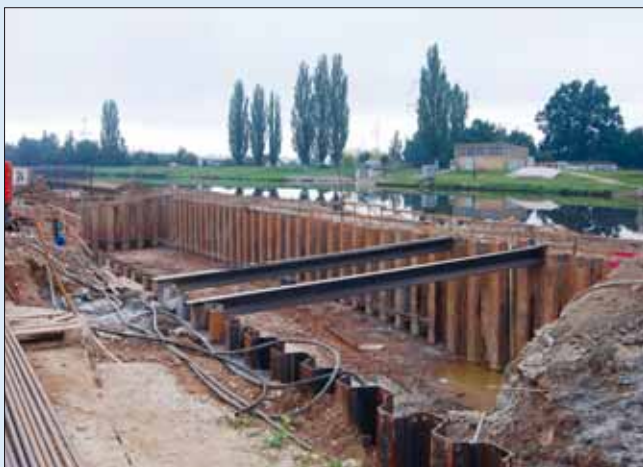
Štětová jímka plavební komory s provizorním rozepřením pro eliminaci nadměrných počátečních průhybů
