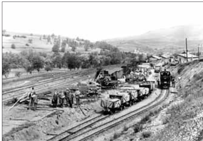
Překládací stanice Ráztočno z dráhy ČSD normálního rozchodu (vlevo) na úzký rozchod 760 mm. Úzkou drážku, dlouhou skoro 6 km a vedoucí obtížným horským terénem k viaduktům a tunelům budované dráhy Handlová–Horná Štubňa, postavilo v letech 1927–1928 konsorcium firem Kruliš–Jáchymek–Schwarz.
