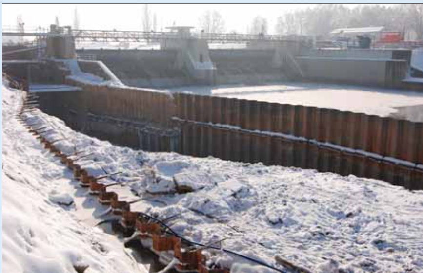
Jímka dolního plavebního kanálu zajištěná z části převrtávanou pilotovou stěnou a štětovou stěnou
