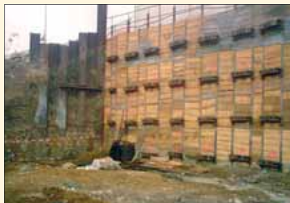
OP1 – východ: Pohled na mikrozáporovou stěnu, provedeny 4 kotevní úrovně z 5, v levé části je vidět prorážka kanalizační štol, 1. etapa
