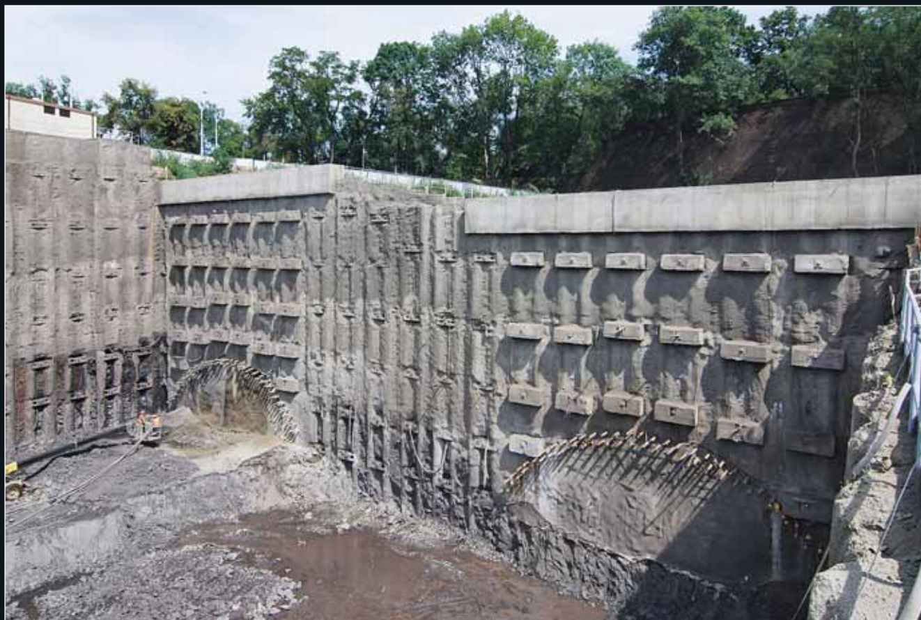
Portálová východní stěna s již realizovanými mikropilotovými deštníky, které zajišťují rozrážku budoucích tunelových tubusů
