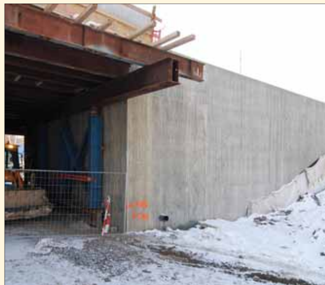
OP2 – východ: Pohled na křídlo nového mostu, do kterého byly osazeny kotevní desky táhel
