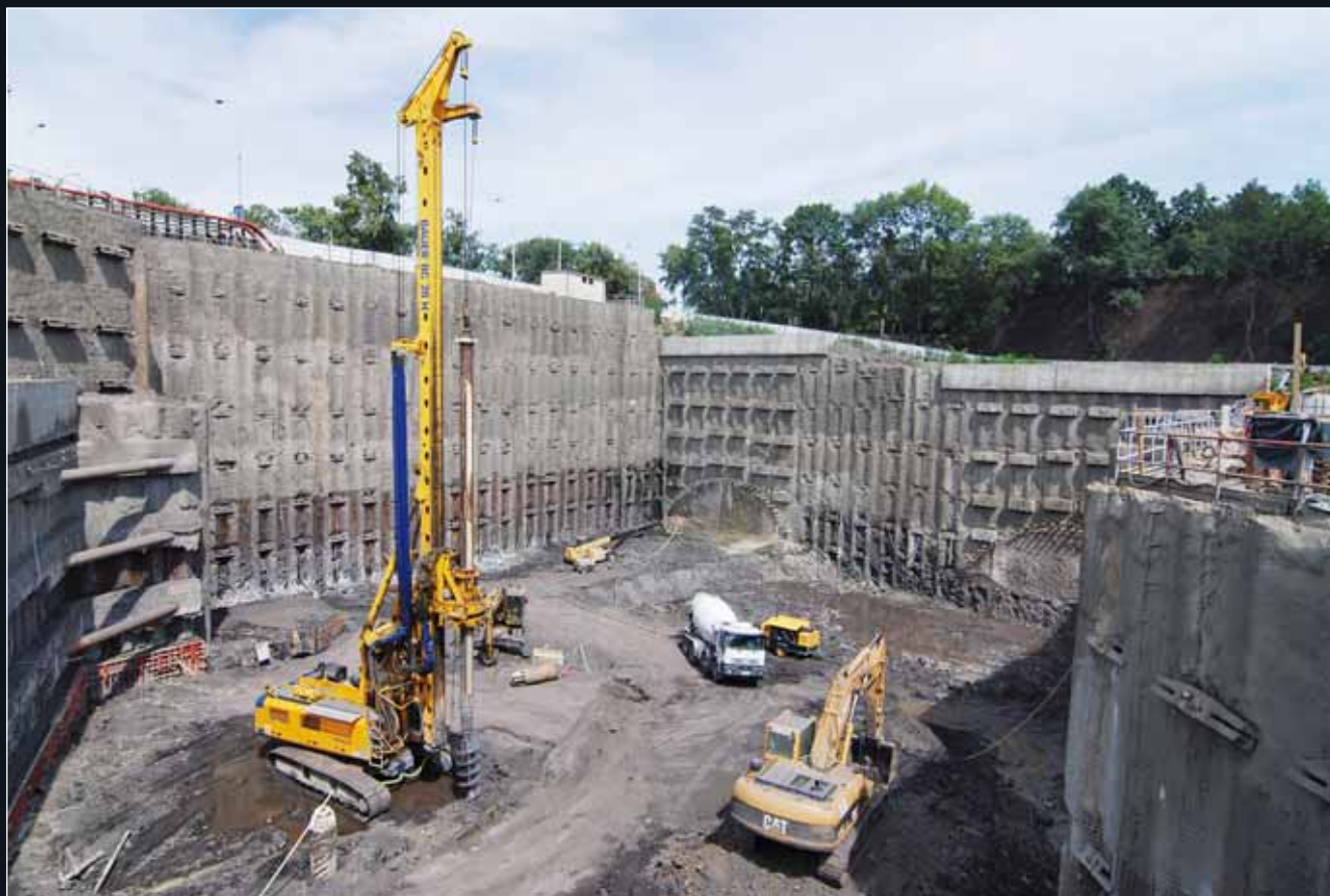
Pohled do částečně vytěžené stavební jámy směrem na severní a východní stěnu pažení
