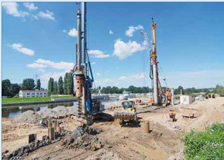
Provádění předvrtů v ose budoucí štětové stěny
