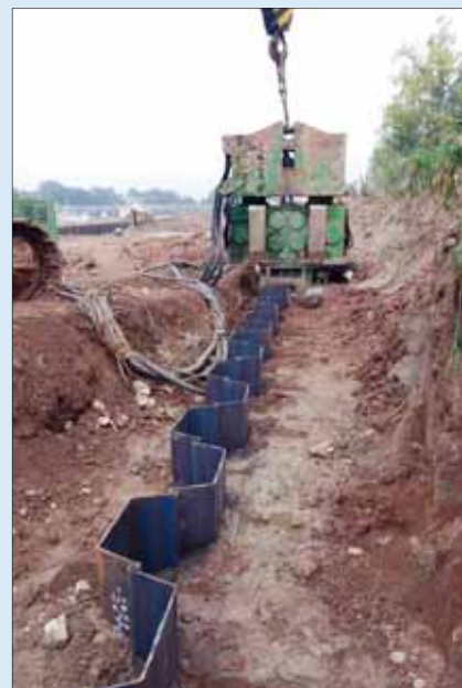
Beranění nábrežní stěny horního plavebního kanálu
