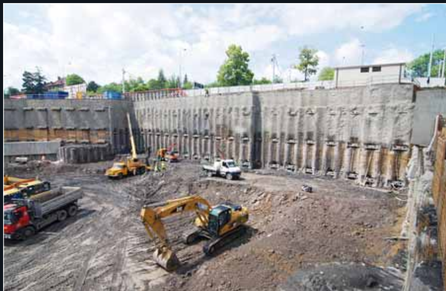
Výkopové práce probíhaly po etapách v závislosti na aktivaci jednotlivých kotevních úrovní a aplikaci stříkaných betonů v příslušných výškových páslech
