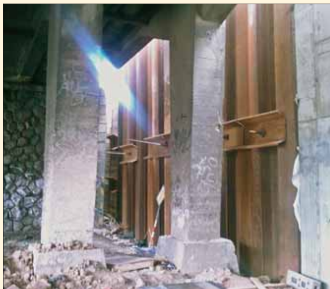
OP2 – východ: Pažící štetová stěna pod stávajícím mostem
