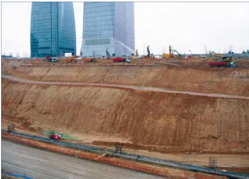
Pohled napříč částečně vytěženou stavební jámou; probíhá kotvení protilehlé podzemní stěny, v popředí je podzemní stěna se sníženou hlavou.
