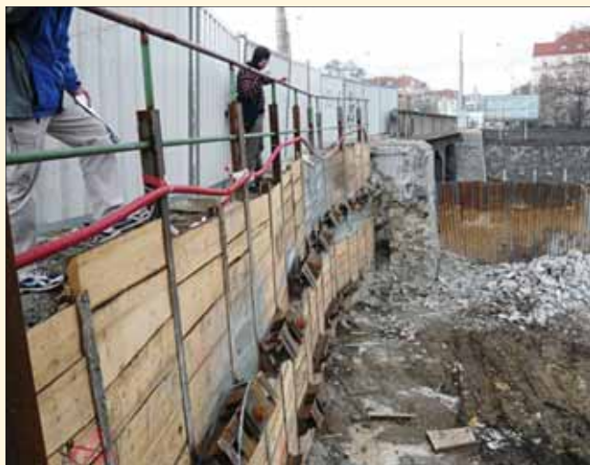
OP1 – východ: Začátek demolice křídla stávajícího mostu, 1. etapa
