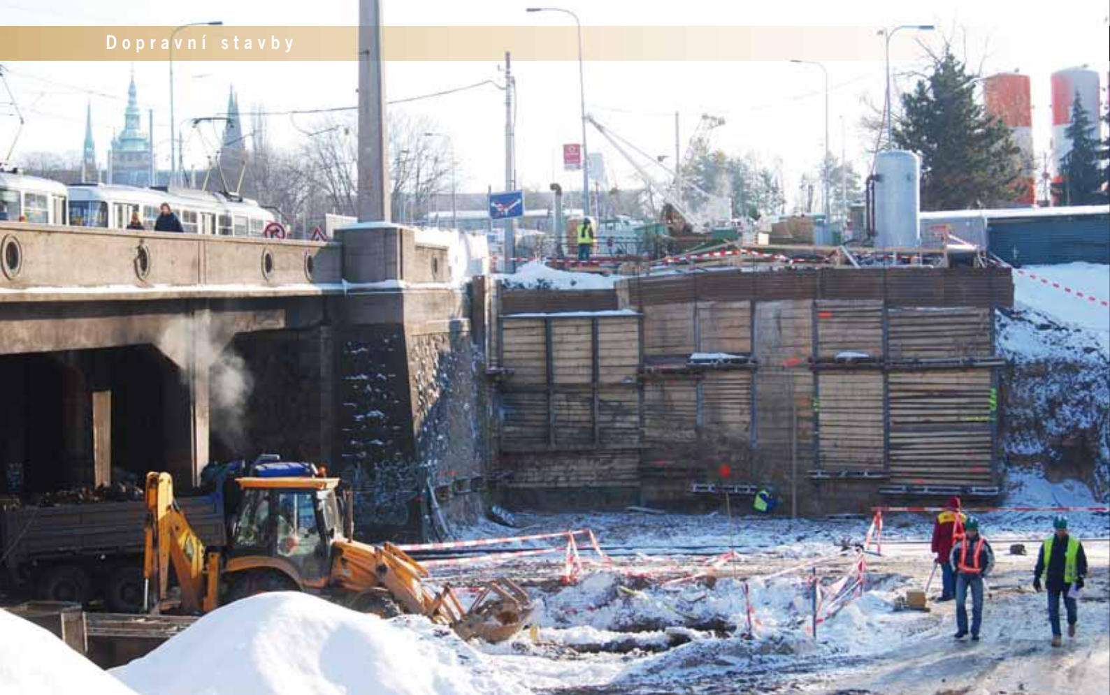
Pohled na záporové pažení u OP1 – západ, úroveň výkopu je přibližně ve 2/3 maximální hloubky, v pozadí katedrála sv. Víta
