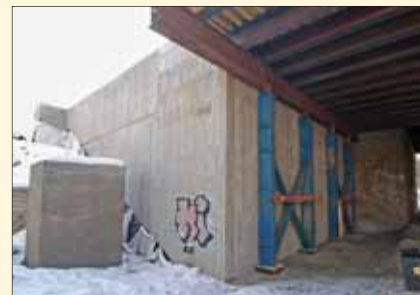
OP1 – východ: Opěra nového mostu, 1. etapa
