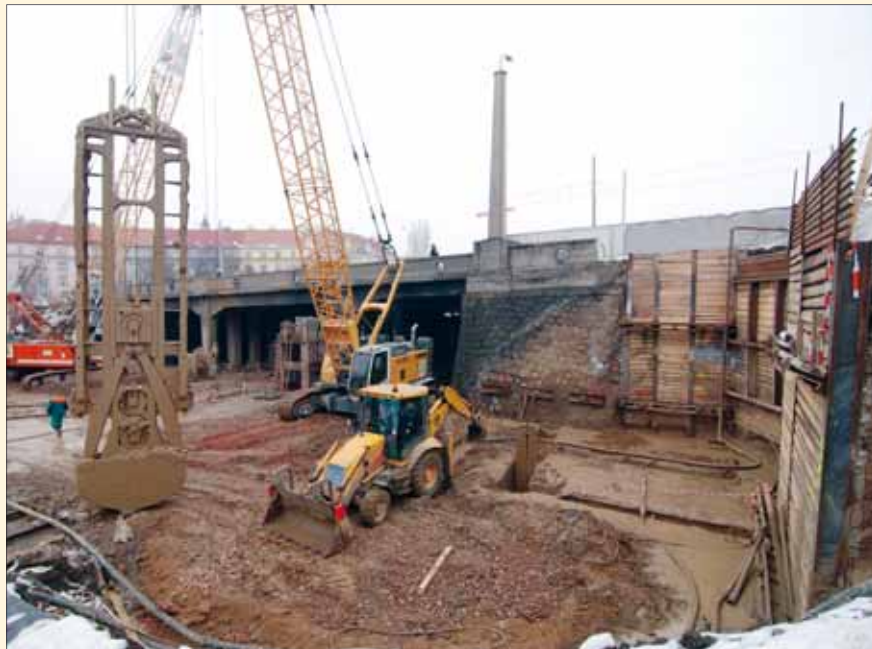
OP1 – západ: Výstavba podzemních stěn založení nového mostu pod ochranou záporového pažení
